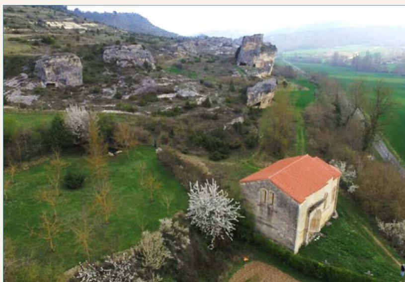
Fig. 71. Mortuorio de Marquina de Suso.
