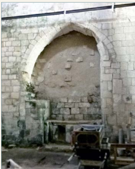
Fig. 74. Acceso reaprovechado como capilla.
