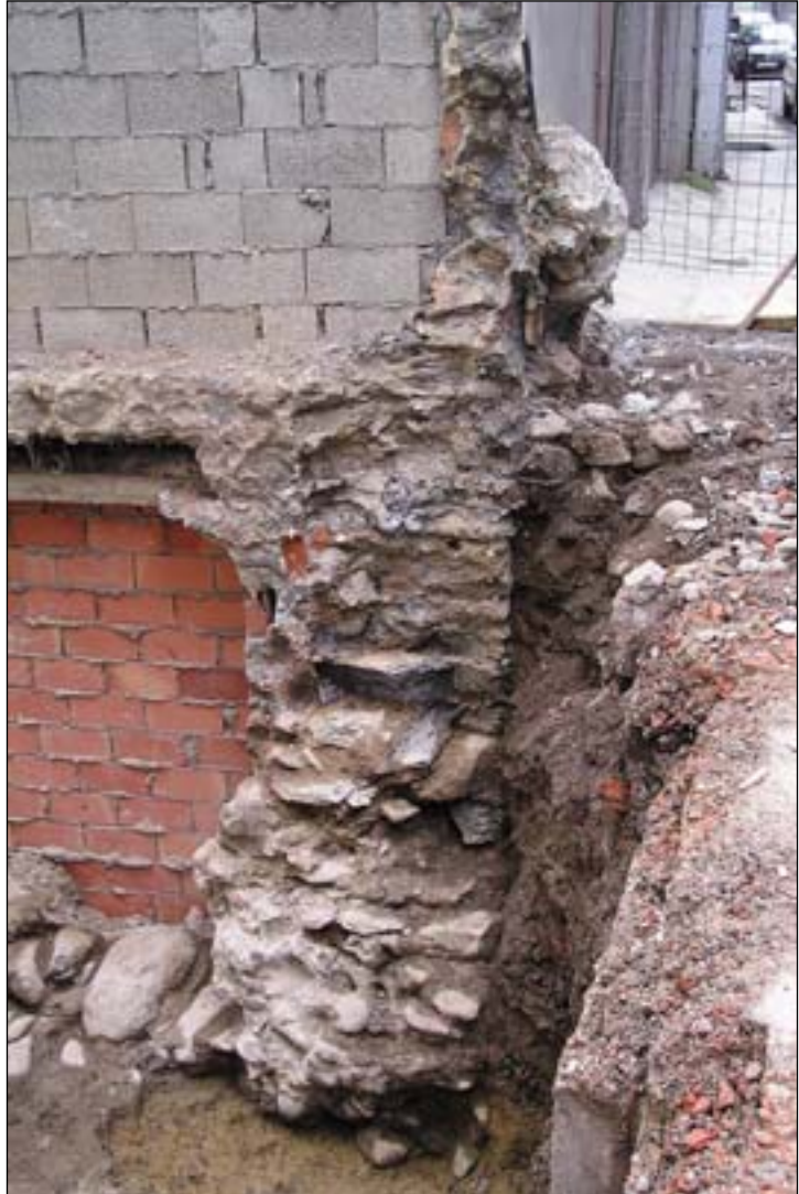
Vista del alzado de la muralla localizada en el solar de Nagusia nº 77 (Azkoitia) con las dos fábricas superpuestas.
