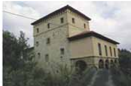
Desde el norte se aprecia el cuerpo de la torre, originalmente existente
