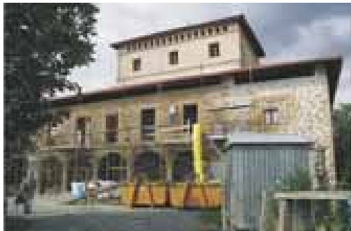
El edificio, durante las labores de restauración
