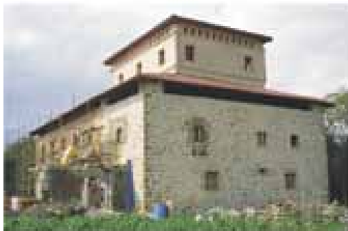
Aspecto de la primera obra del palacio, al este de la torre banderiza
