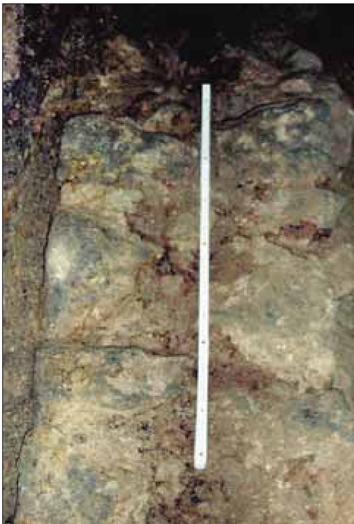
Beheko kalea 34 (Lekeitio). Vista parcial del muro que atraviesa el solar en dirección este.
