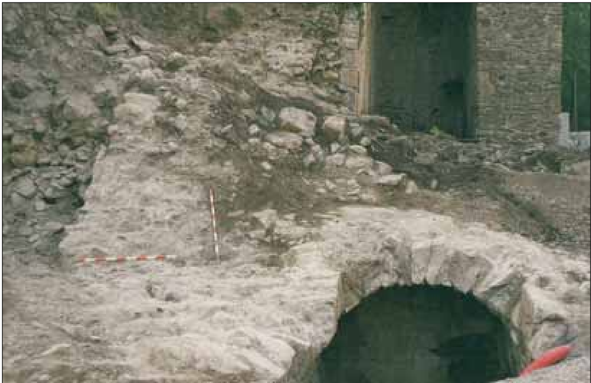
Olazarko Burdinola-errota (Eskoriatza). Ganga-formako kanalaren ahoa eta antepararen zimenduak.
