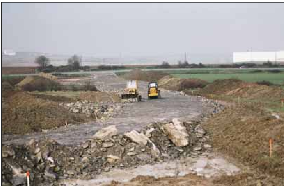
“Errepidearen atal berrietako askotan egindako lanen adibidea. Gutxi sakondu ondoren hareharriz eta legarrez betetzen zen.”
