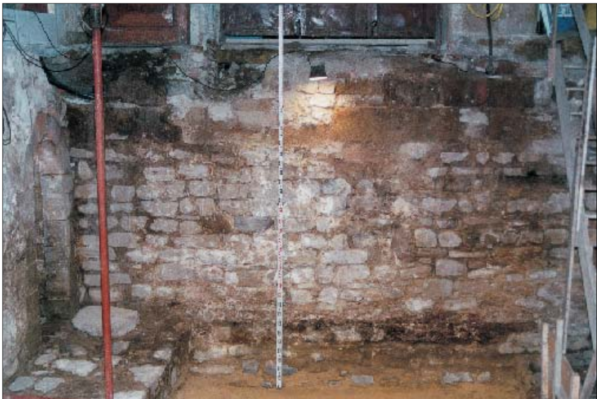
Embeltran kalea, 3 (Donostia). Orubearen ikuspegi orokorra, I-ko fatxadaren zimentazioa ikus daiteke bertan. M-ko mehelinean irekitako arku zorrotz samarra ageri da ezkerrean.
