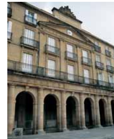
Sede de Euskaltzaindia. Bilbao.
