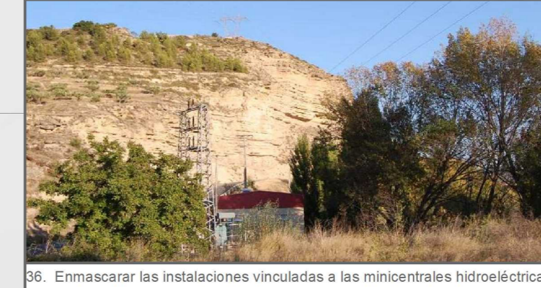
36. Enmascarar las instalaciones vinculadas a las micentrales hidroeléctricas
