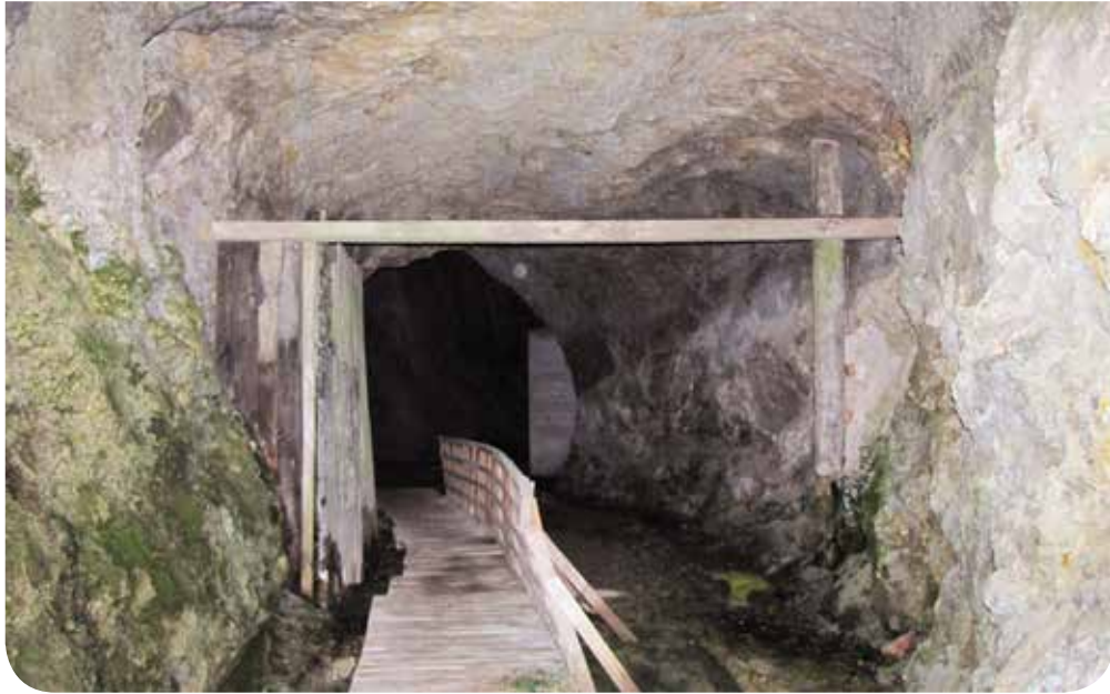
Las galerías están abandonadas y son peligrosas.
