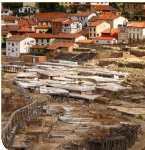
Detalle de la parte restaurada.
