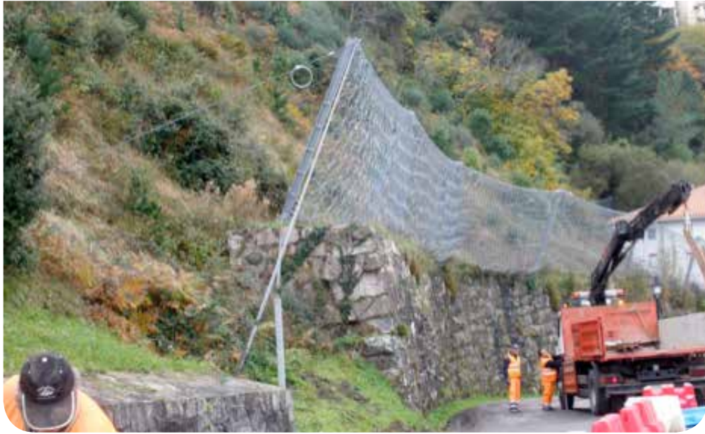
Muros de contención de las laderas de Elantxobe.
