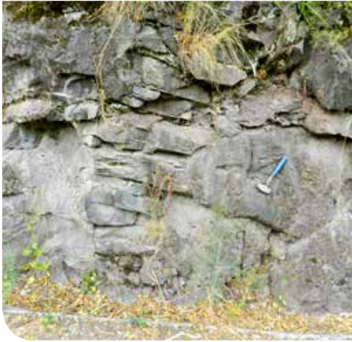
Dique sinvolcánico con disyunción de forma irregular y bordes ondulados que se adapta a la forma de las pillow que lo encajan.
