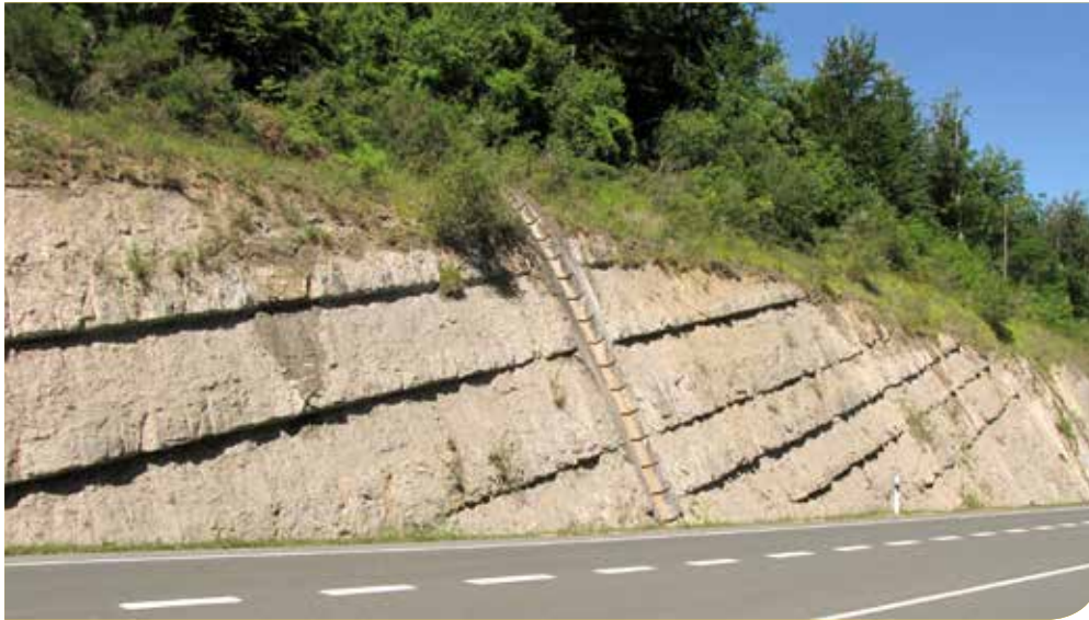
Aspecto de las calcarenitas y margas del Cretácico superior del puerto de Azazeta.
