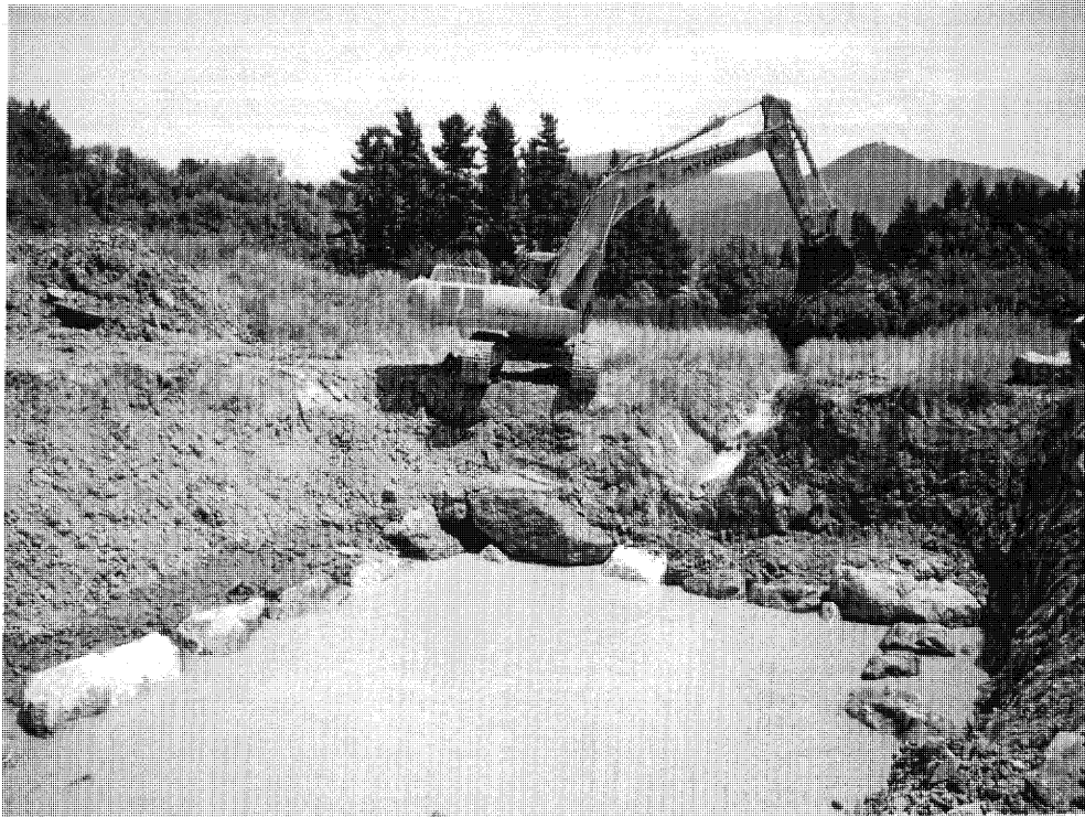
Construcción de la balsa del frente 2M
