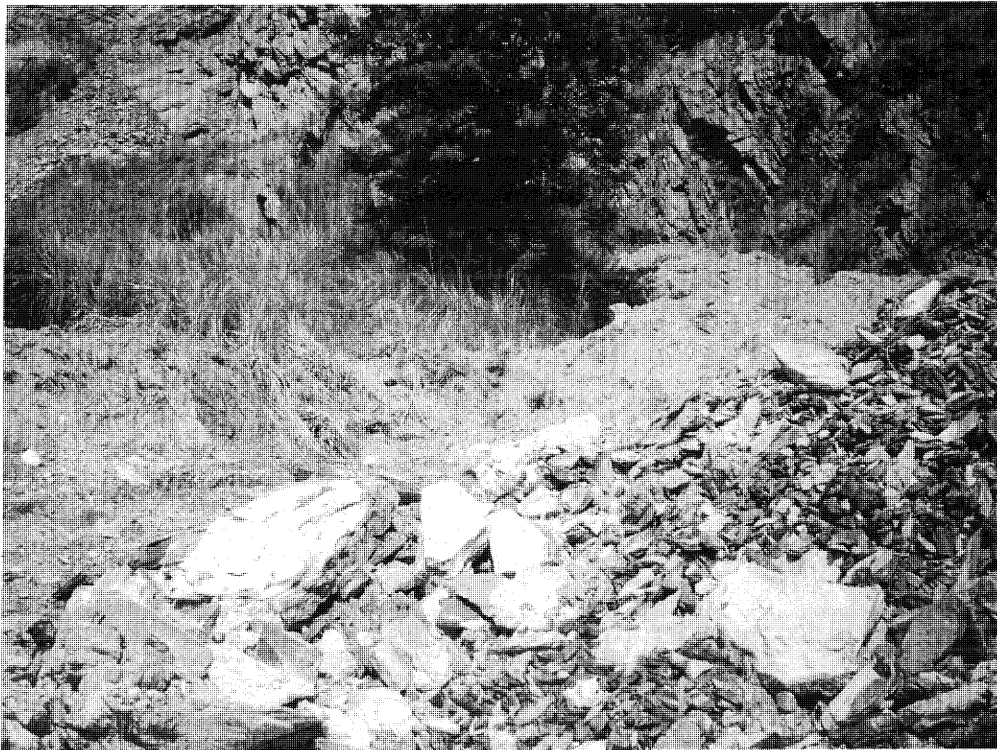
Habilitación de la balsa de decantación
