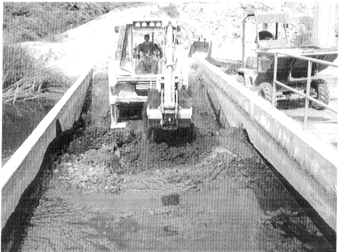
Limpieza de la balsa de decantación de la trituración secundaria
