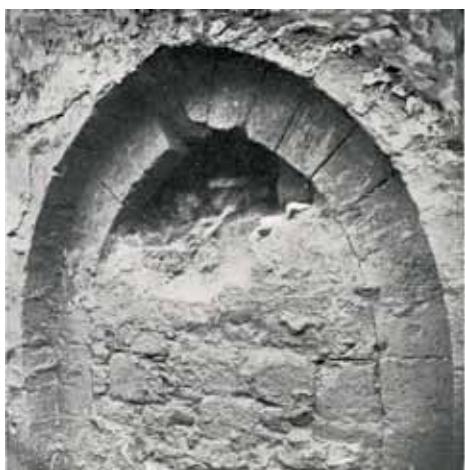
Arco que perteneció a la puerta de la capilla del Hospital de San Lázaro, correspondiente al patronato de Caballeros de San Lázaro, orden sacro-militar 1119. Este Hospital fue incendiado por los franceses en el sitio de 1512. Juana La Loca dio en 1535 una real cédula de reedificación. Revista Novedades del 13 de Noviembre de 1910.
