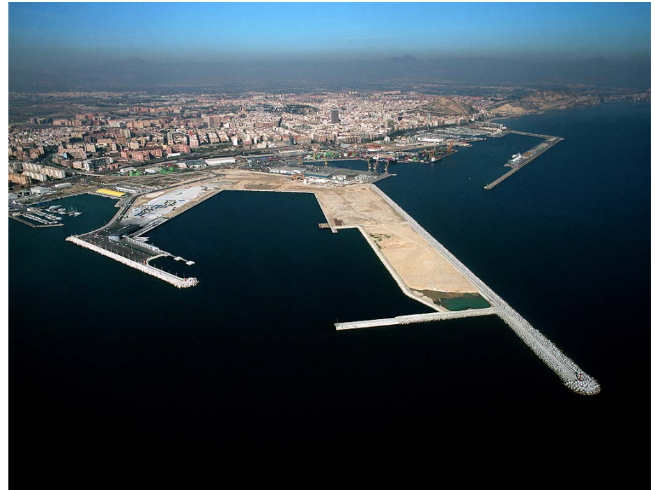
TMS Puerto de Alicante
