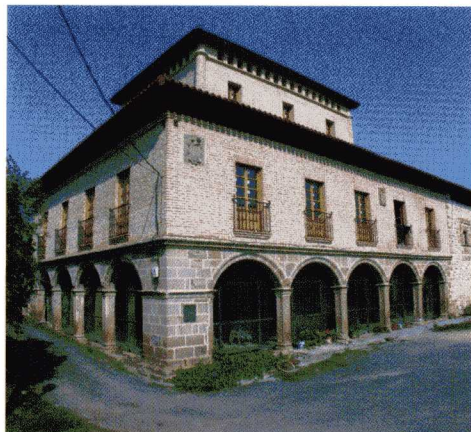
Murgako Dorrea (Murga, Araba). Torre de Murga (Murga, Álava).
