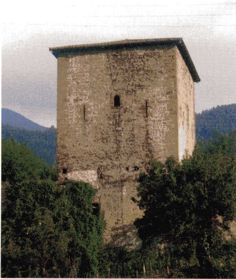
Quadra-Lakabexeko Dorrea (Quadra, Bizkaia). Torre de la Quadra (La Quadra, Bizkaia).
