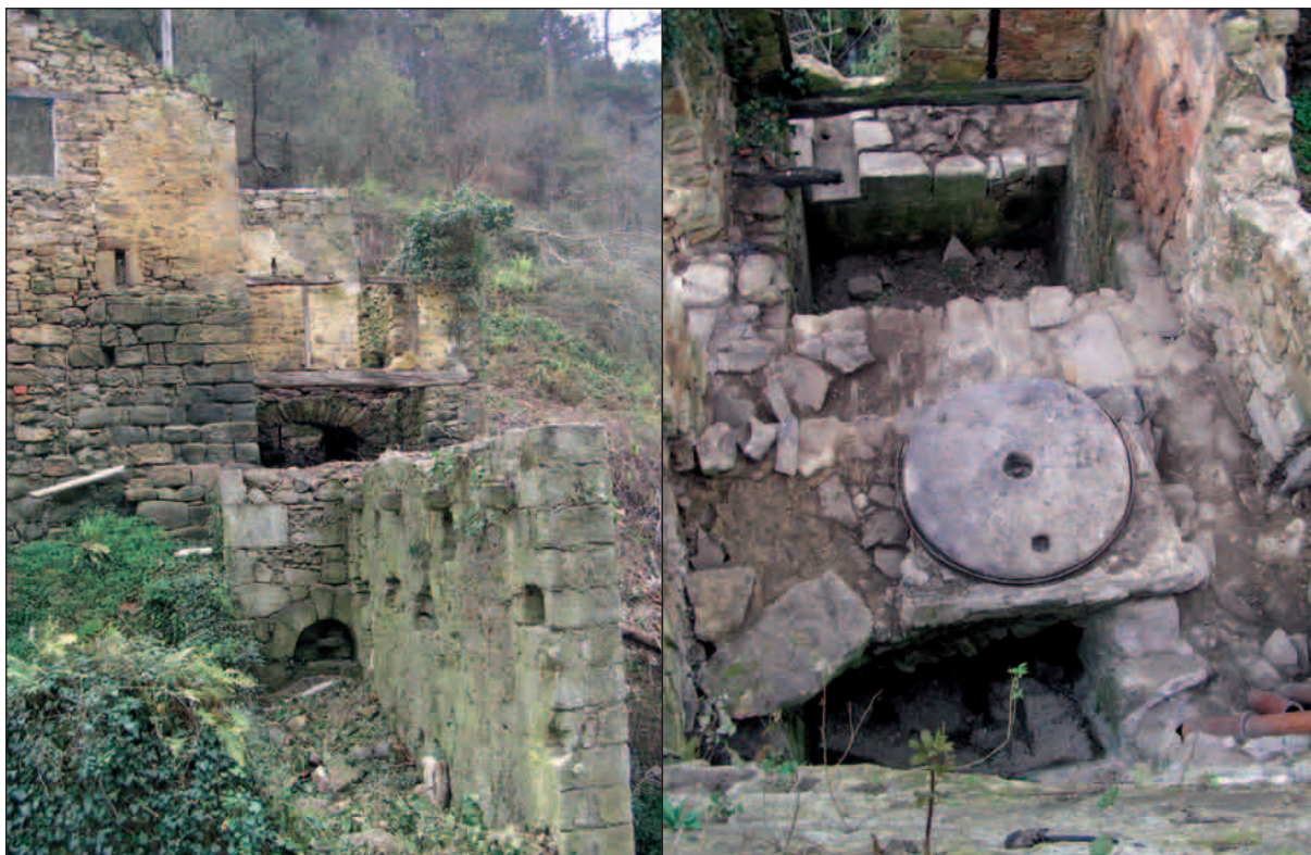
Ezker.: Txanka goikoa baserriko errota gainjarrien aurre-aurreko ikuspegia. Eskuin.: goiko errotako ehoteziaren xehetasuna, errotaria lehen planoan, eta beheko errotako aldaparoa.
