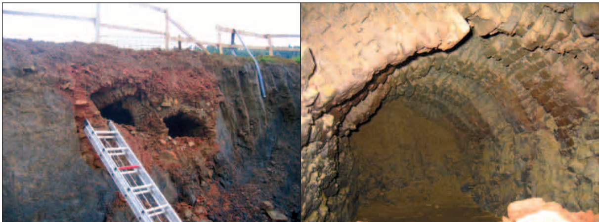
Telleria teileria. Errekuntzarako ganberaren xehetasunak (ezk.) eta Teileriaiko egituren ikuspegi orokorra (esk.).
