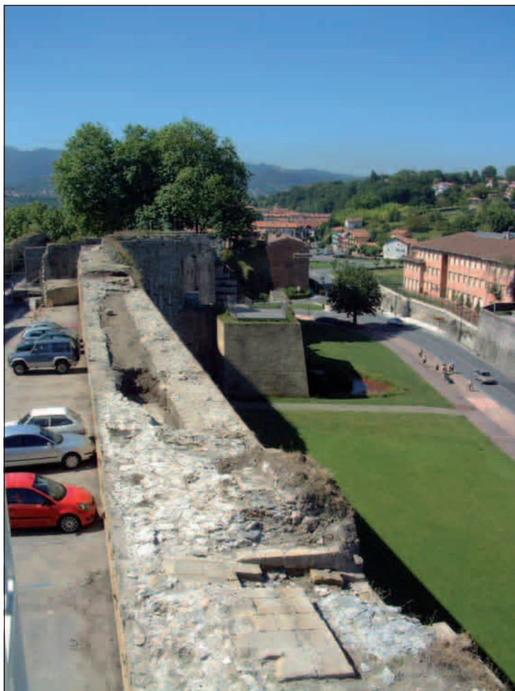
Muralla. Cortinas sur y oeste. Detalle de los trabajos de control arqueológico durante las labores de limpieza de la cortina oeste.
