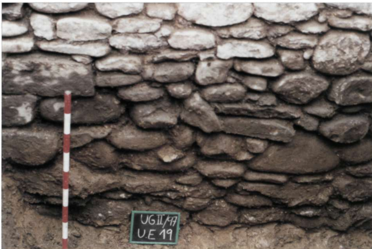
Udiarraga kalea, 37-41 (Ugao-Miraballes). 19. U.E. Zimentazioetan metro beteko lodiera duen horma, zimentazioak sakonera handian antolatutak. Hormaren sendotasuna seguru asko ibaiaren hurbilak eragina da, baina hiribildua ixteko harresi-atala ere izan zitekeen une jakin batean.
