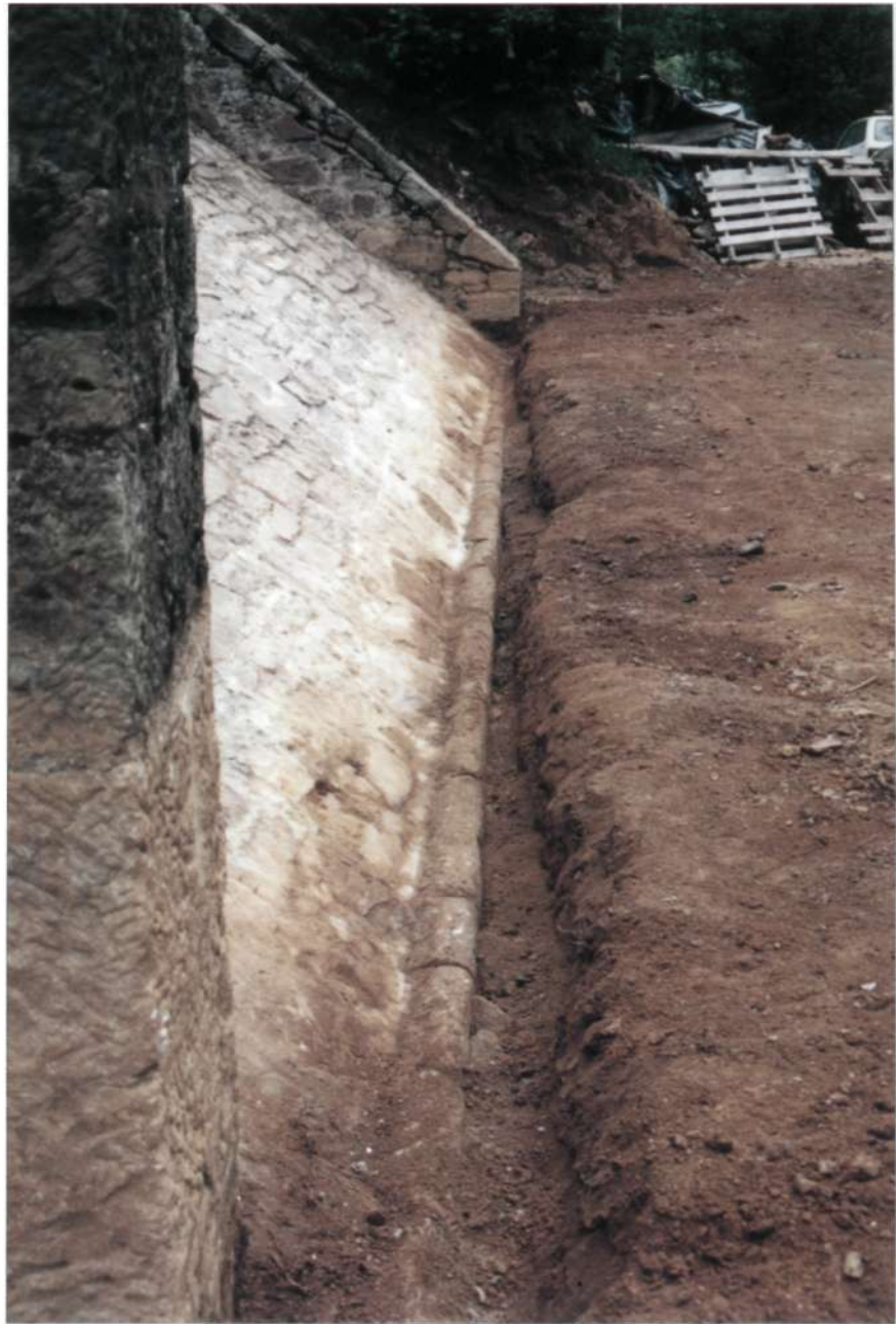
Instalaciones Mineras del Alto de Udana: Vista general sur del remate inferior de la masera. Julio 1997.
