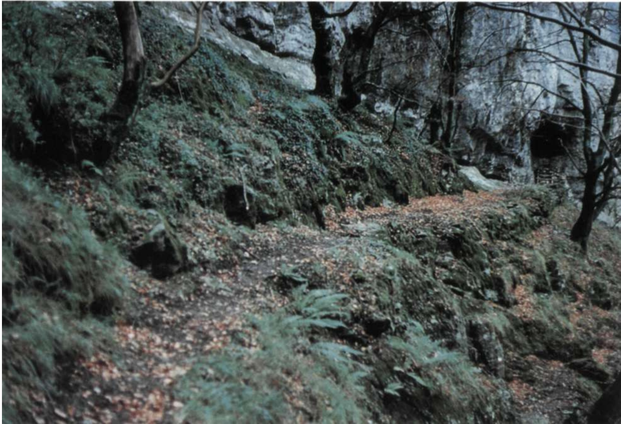
Lizarrusti. Vista general del trazado ferroviario.
