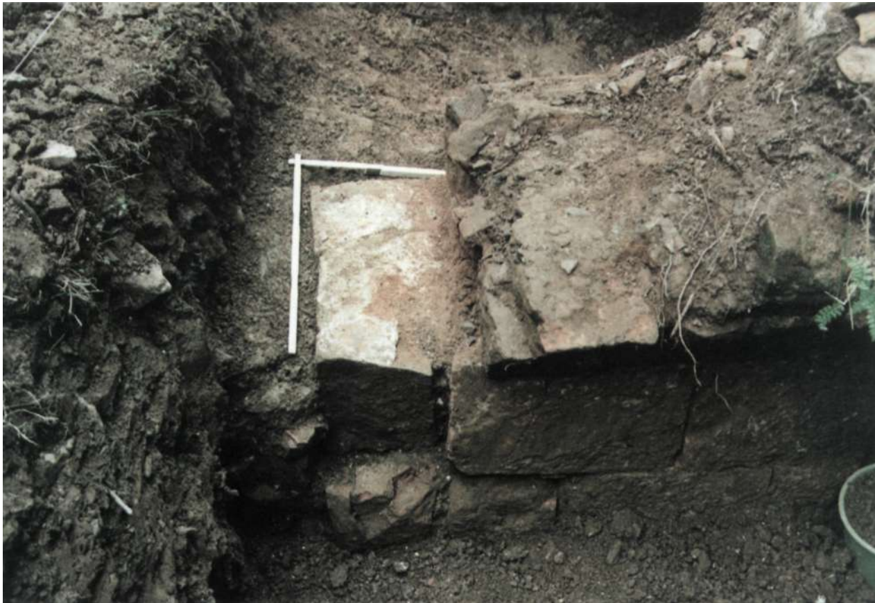
Tejería de Kortaberria. Vista del muro de separación entre ambas cámaras.
