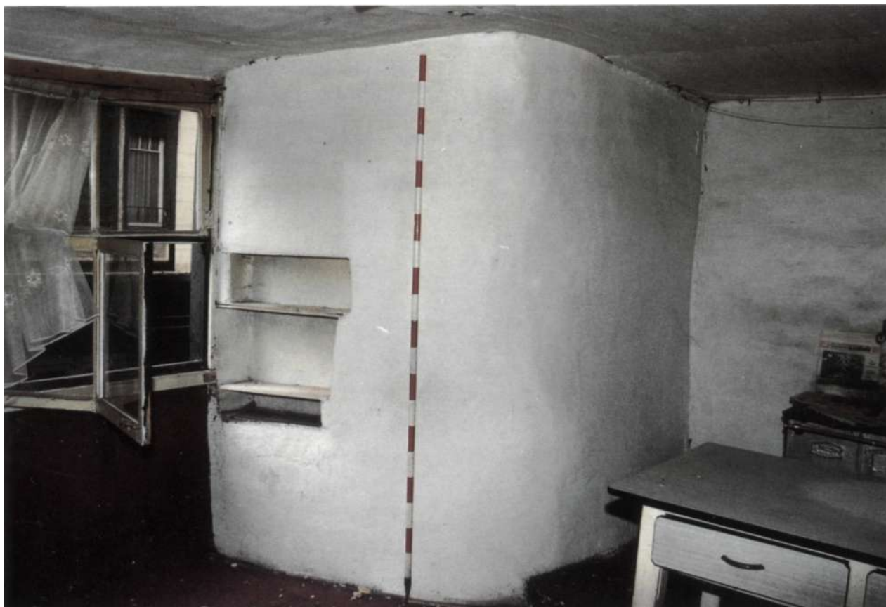
Solar n.º 10-12 de la C/ Ferrerías. En primer plano se observa la muralla formando parte de la estructura del edificio.
