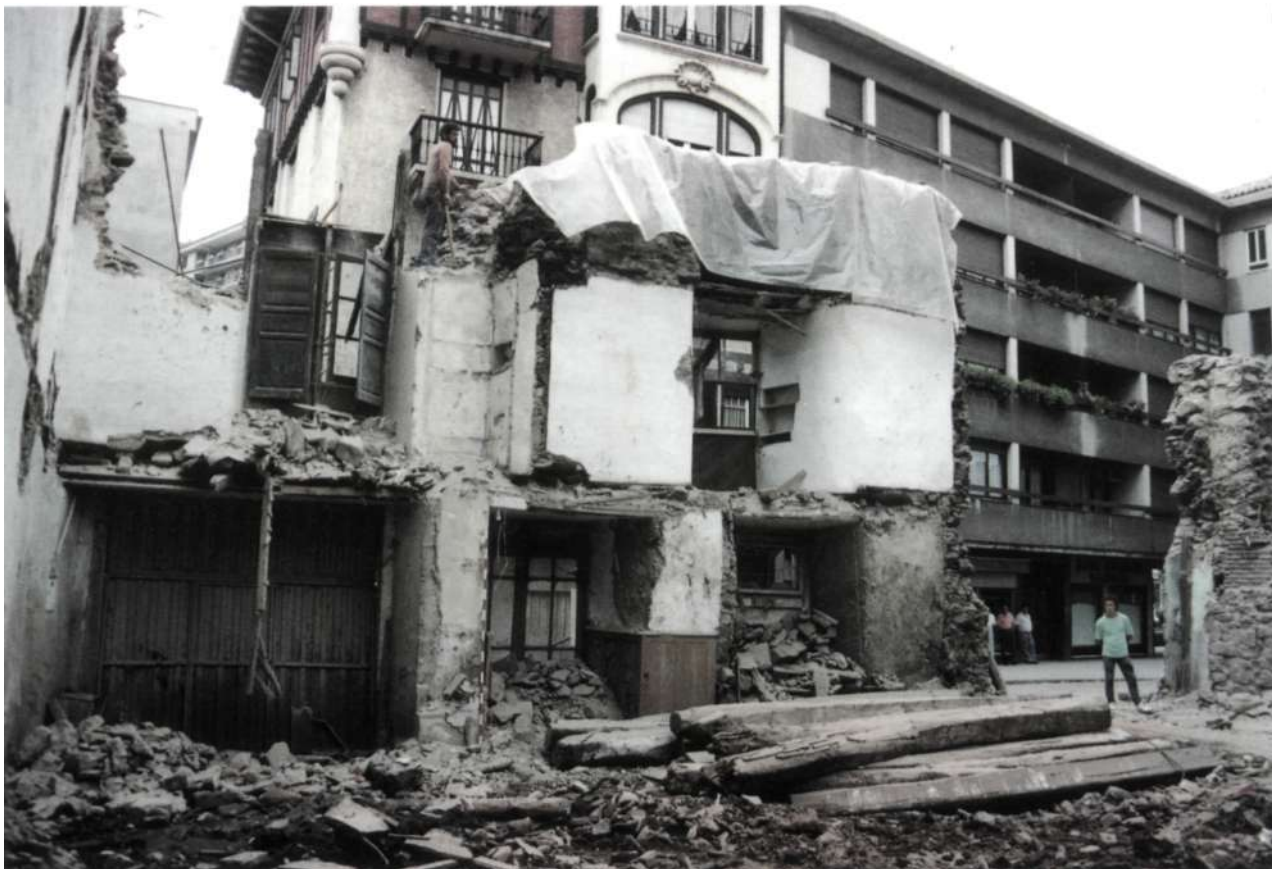
Solar n.º 10-12 de la C/ Ferrerías. Vista general del derribo, manteniendo el tramo de muralla.
