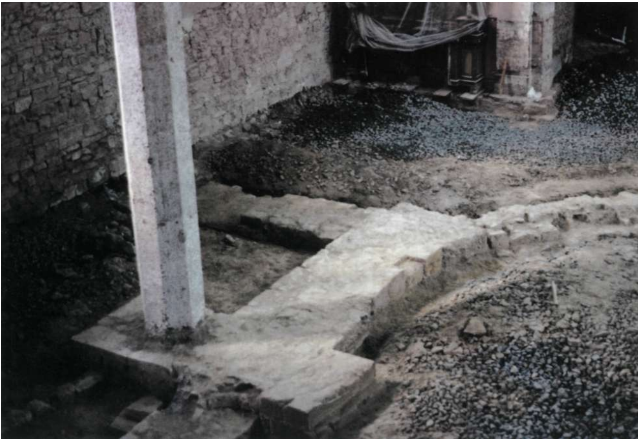
Iglesia de Santa M. a . Vista parcial de la excavación.
