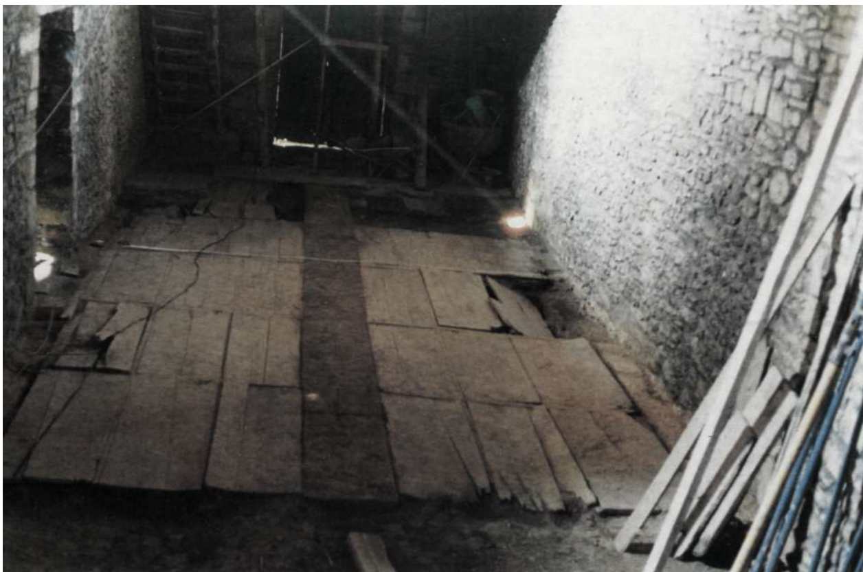
Ernita de Santa María Magdalena. Dima. Vista general de las cubiertas de madera de las sepulturas.
