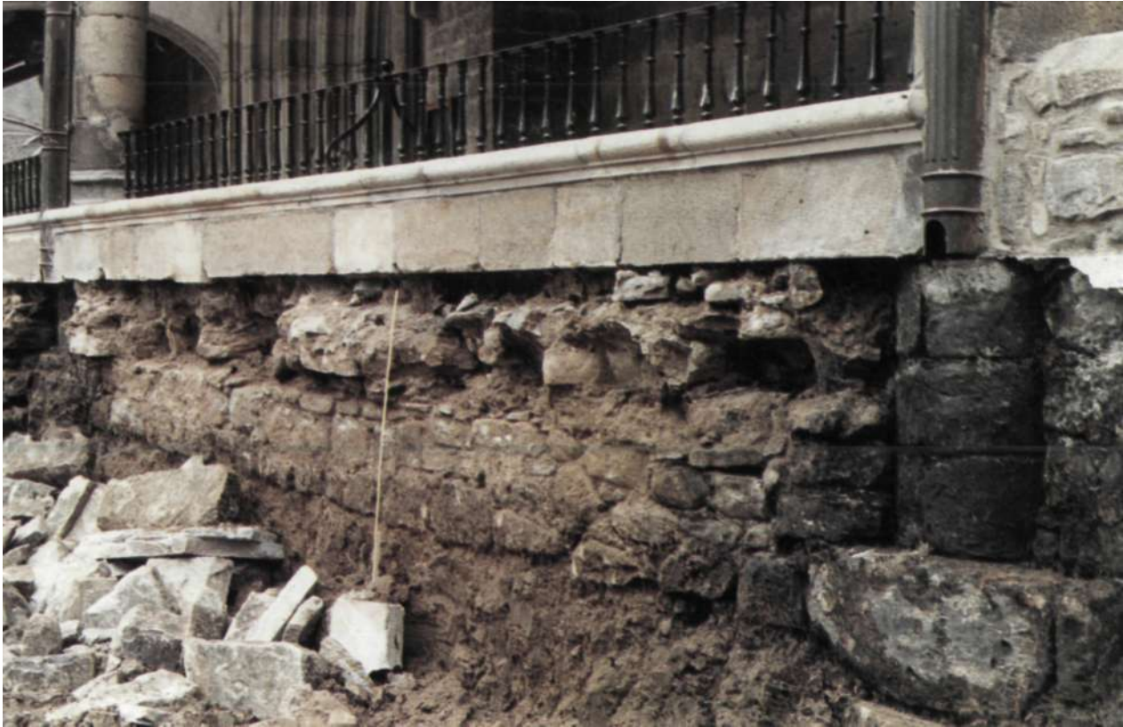
Cimentación del sector noroeste del atrio septentrional de la iglesia de la Purísima Concepción. Elorrio.
