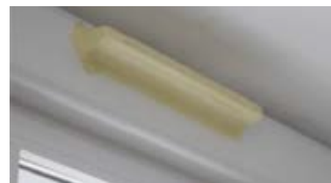
Sellado en un aireador de ventana en un salón
