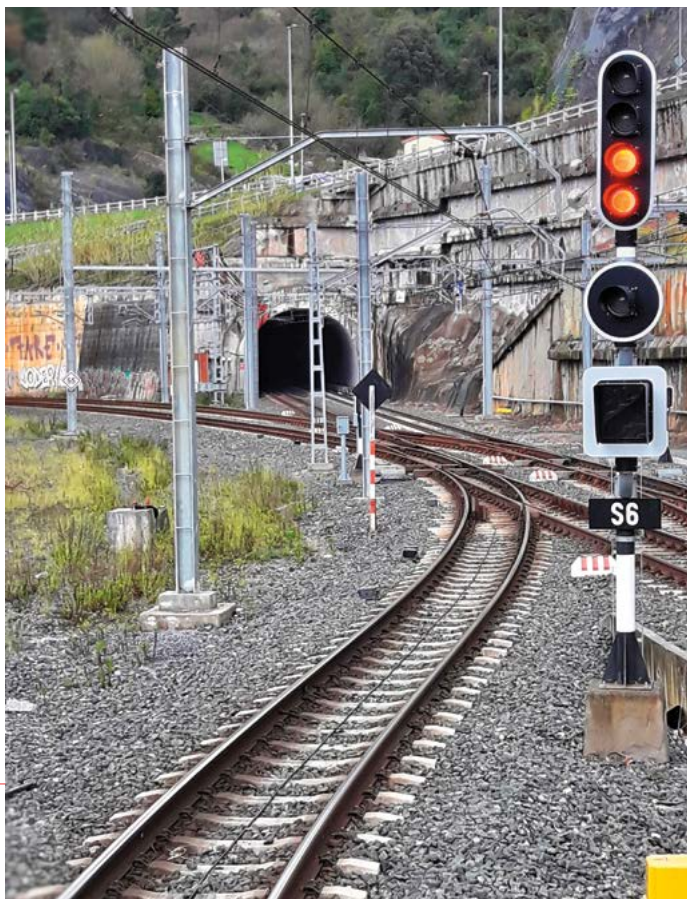
Señalización luminosa para el bloqueo automático.
