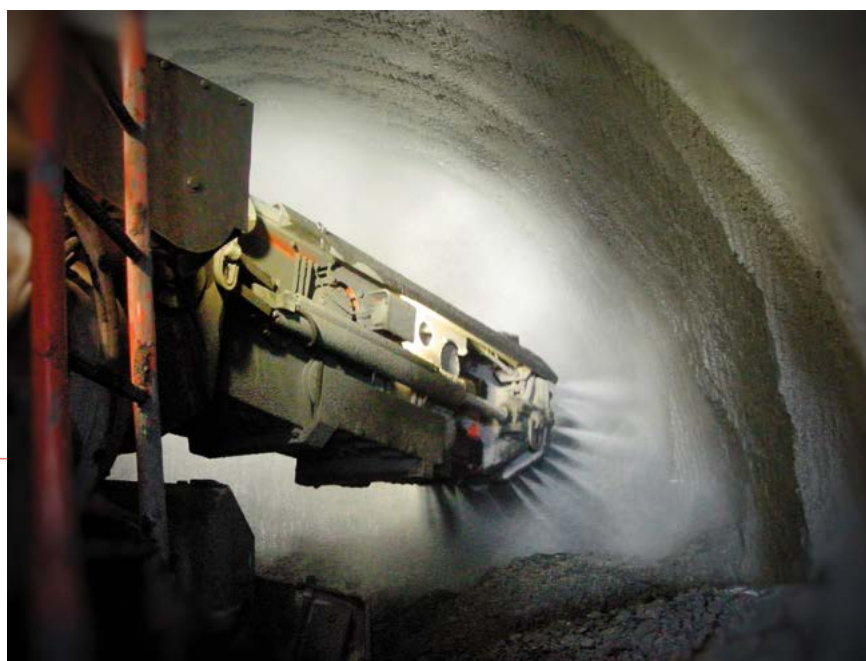
Rozando con inyectores de agua para limitar la emisión de polvo.
