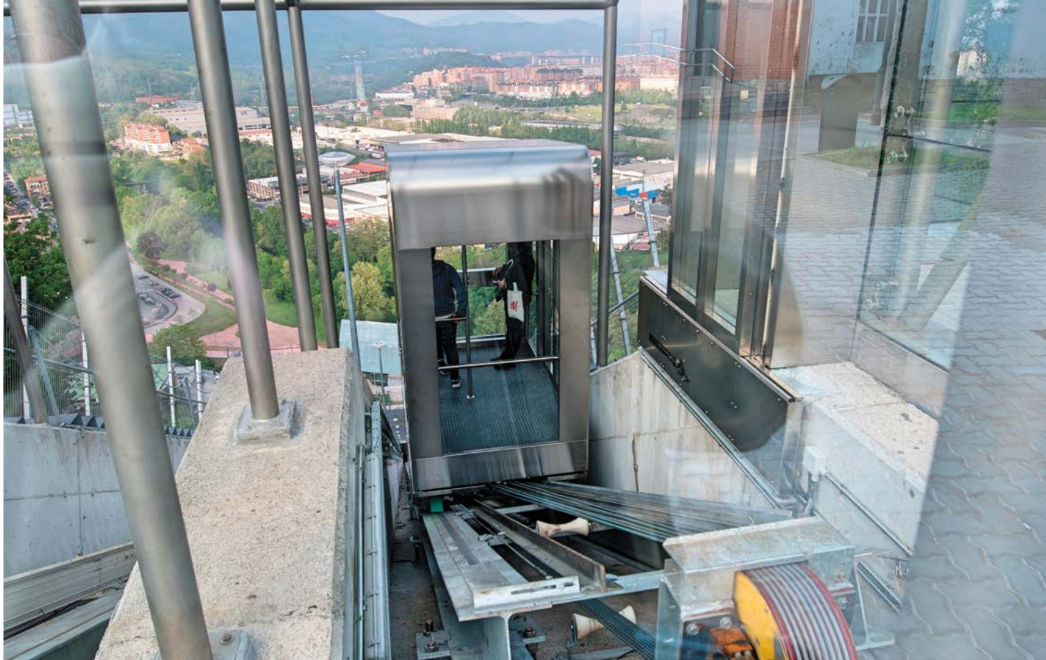
Kukullaga-Etxebarriko geltokiko instalazio bereziaren terminala San Antonio auzoarekin lotzen duen igogailu inklinatua da.
