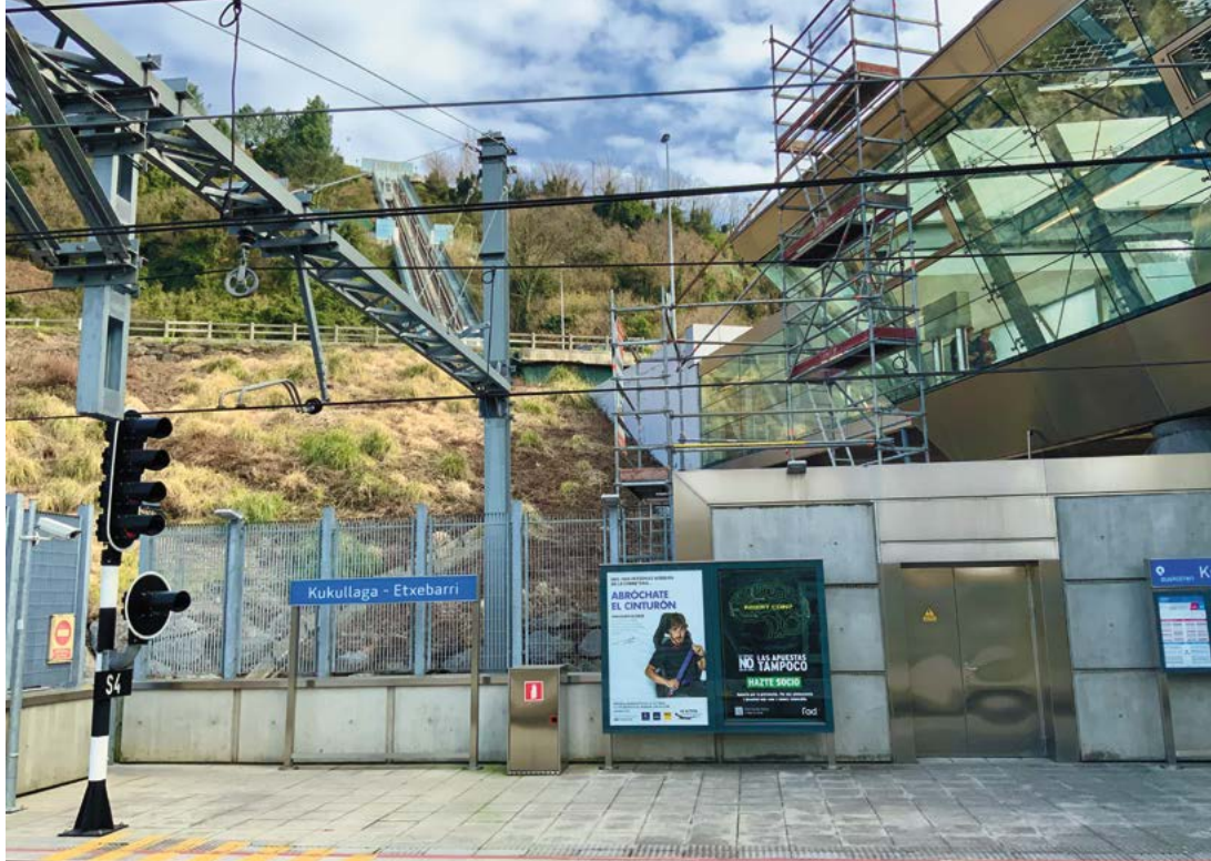
Kukullagako geltokian ohiko katenaria instalatu da.
