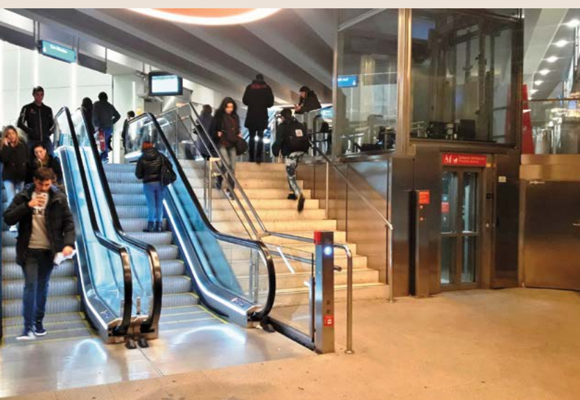
1., 2. eta 3. lineen arteko loturako igogailua Zazpikaleetan.
