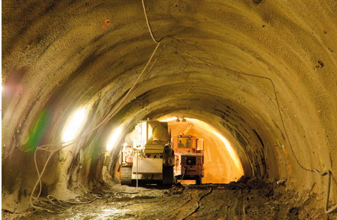
Obras de perforación del túnel entre Uribarri y Matiko.
