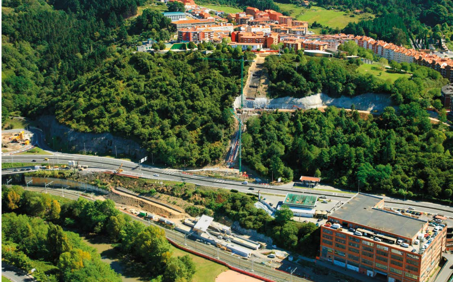
Eraikitzen ari zen Kukullaga-Etxebarriko geltokiaren irudi panoramikoa. San Antonio auzoa ikusten da goialdean.
