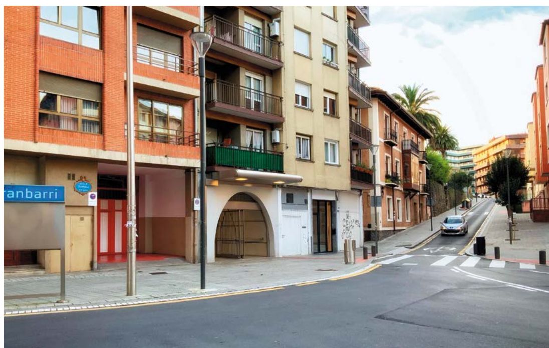
Sarrerako aho berezia Zumaia kalean, eraikin baten beheko solairuan.
