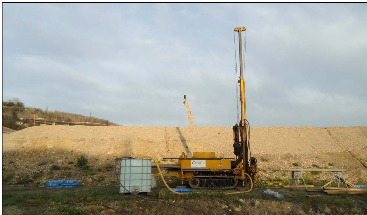
Figura 11. Emplazamiento sondeo SM-2.
