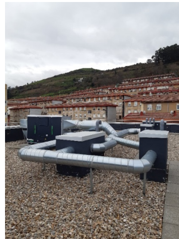
Figura 2. Bombas de Calor y Ventilación Mecánica sobre la cubierta del edificio.
