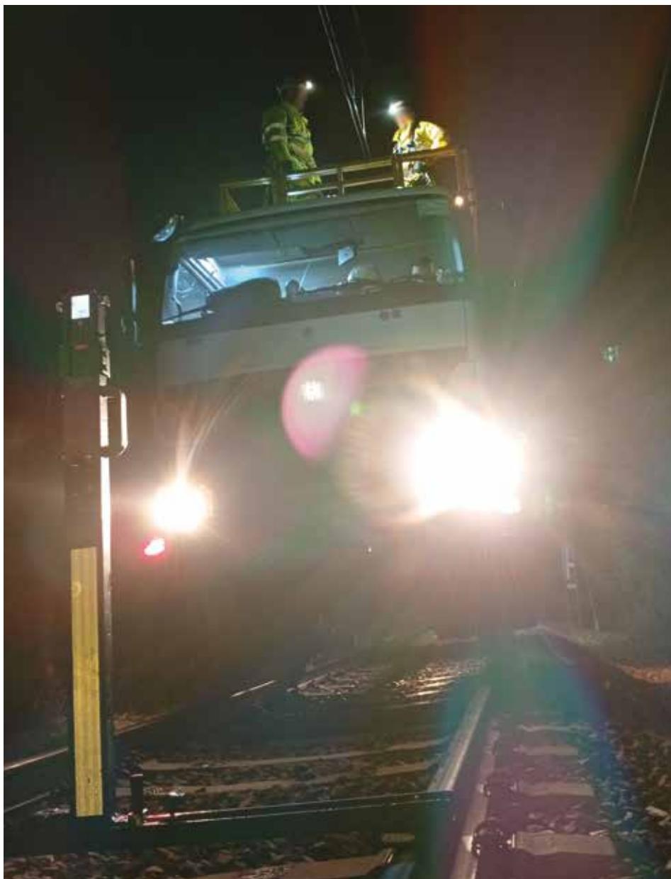
106. argazkia. Altuerako lanak, altxatzeko bitarteko mekanikoak erabiliz.
