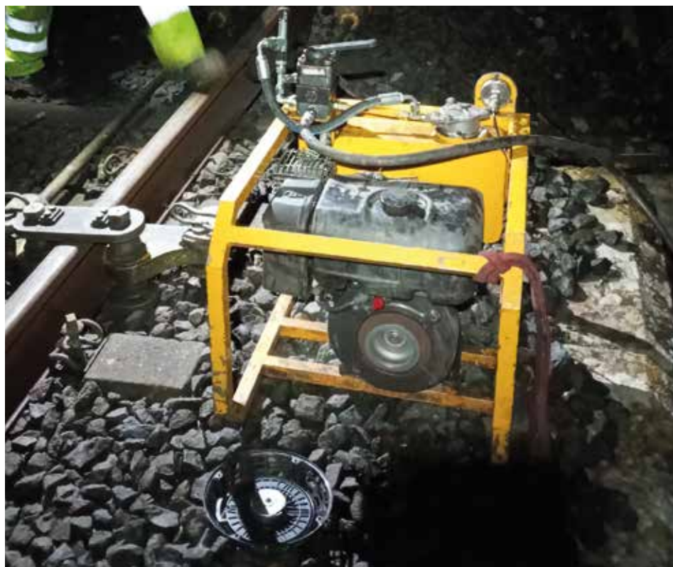
99. argazkia. Tenkagailu hidraulikoa.
