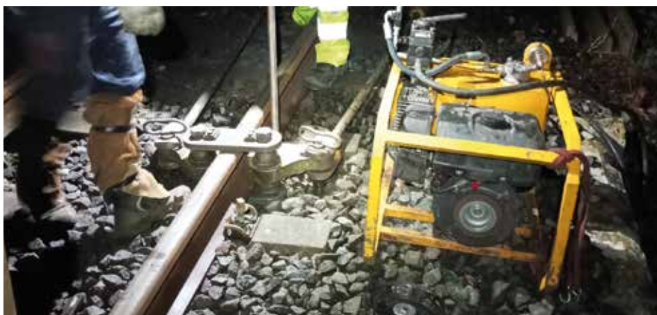
153. argazkia. Konpresorea duen tenkagailu hidraulikoa (tentsioak askatzeko ekipamendua) .
