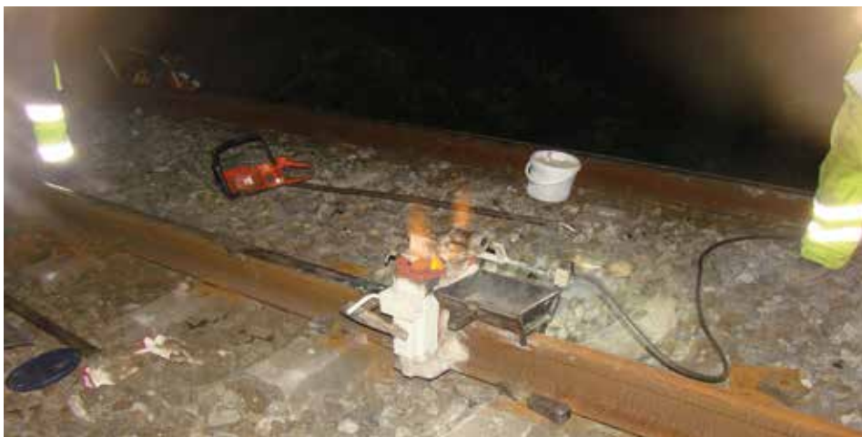
131. argazkia. Soldadura aluminotermikoko ekipamendua (arragoa, karga eta su-pistola).
