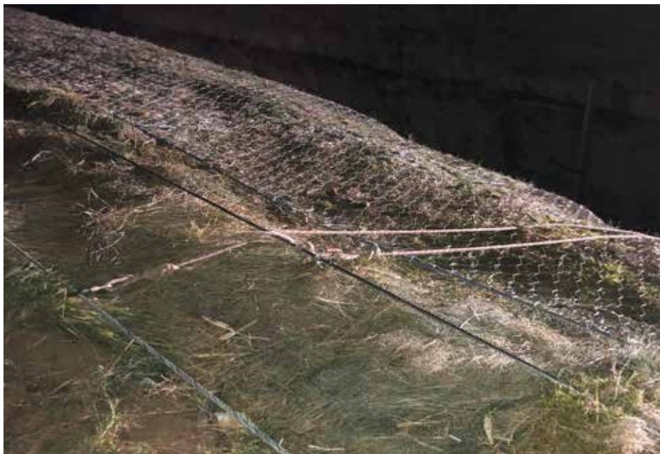
62. argazkia. Eusteko bi soka independente, bata sartzeko eta jaisteko, eta bestea larrialdietarako. Sokak sarearekin marruskatzeagatik izan dezakeen higadura zaindu behar da.
