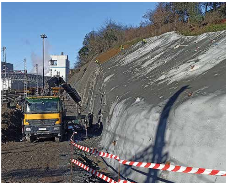
56. argazkia. Ainguraketak eta buloiak ipintzea.
