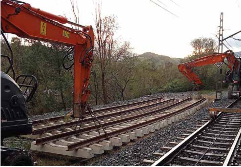
7. argazkia. Bikoteak kargatzeko lanak, bi bidetako atzerako hondeamakina bi erabilita.
