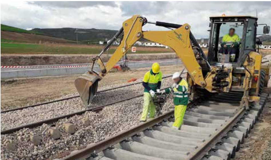
96. argazkia. Iltzagailua erabiltzen duten langileak.
