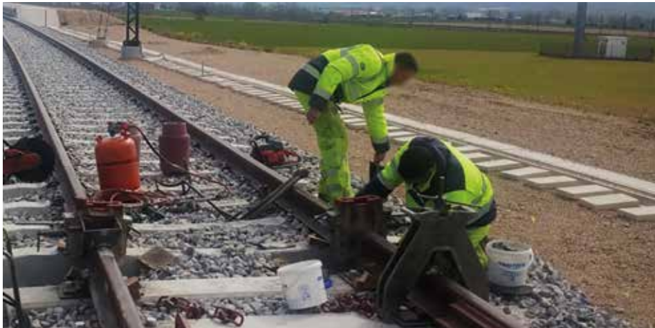
130. argazkia. Beroketa-ekipamendua (aire-propanozko botilak dituen erregailu-orga).
