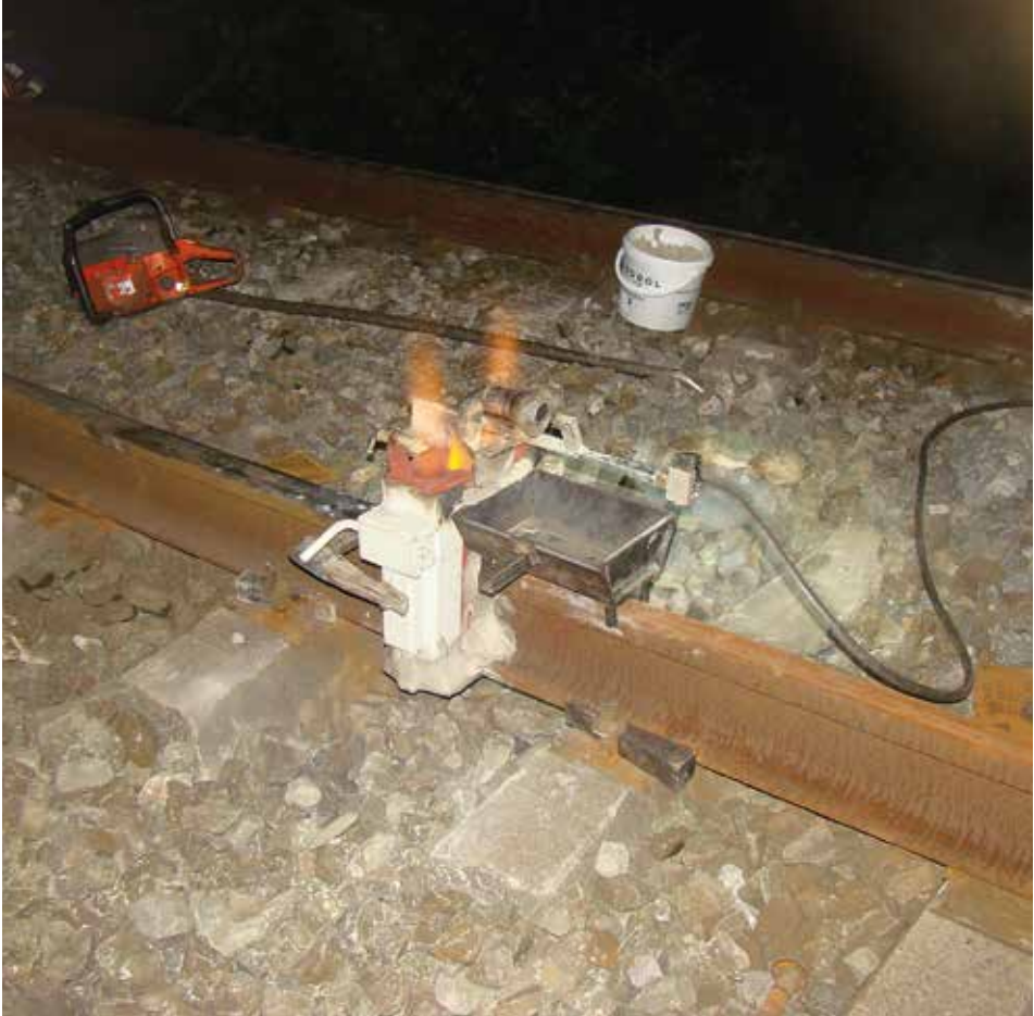
79. argazkia. Soldadura aluminotermikoa.
