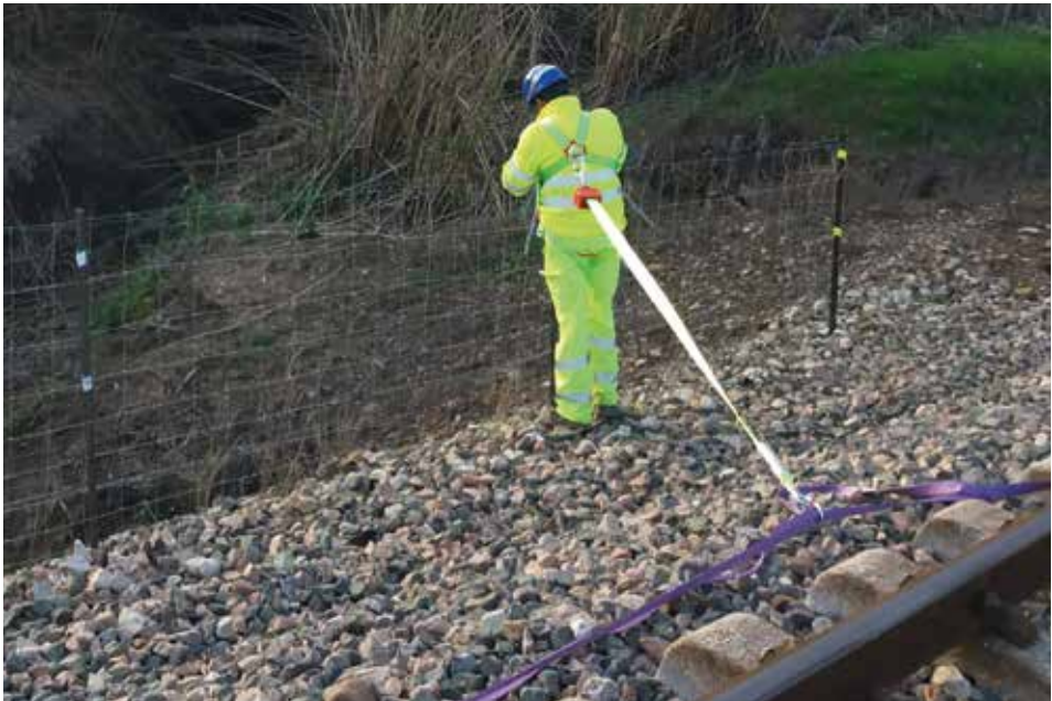
69. argazkia. Arnesa eta segurtasun-soka erabiltzen ari diren langileak.
