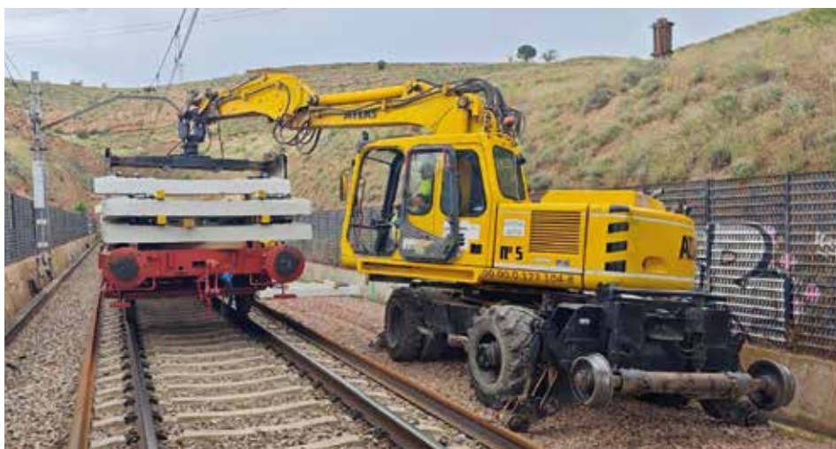
92. argazkia. Trabesak deskargatzea, bi bidetako atzerako hondeamakina erabiliz.
