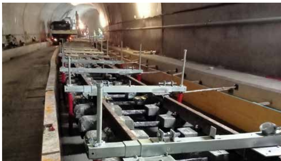
Fotografía 36. Maquinaria en zona estable.
