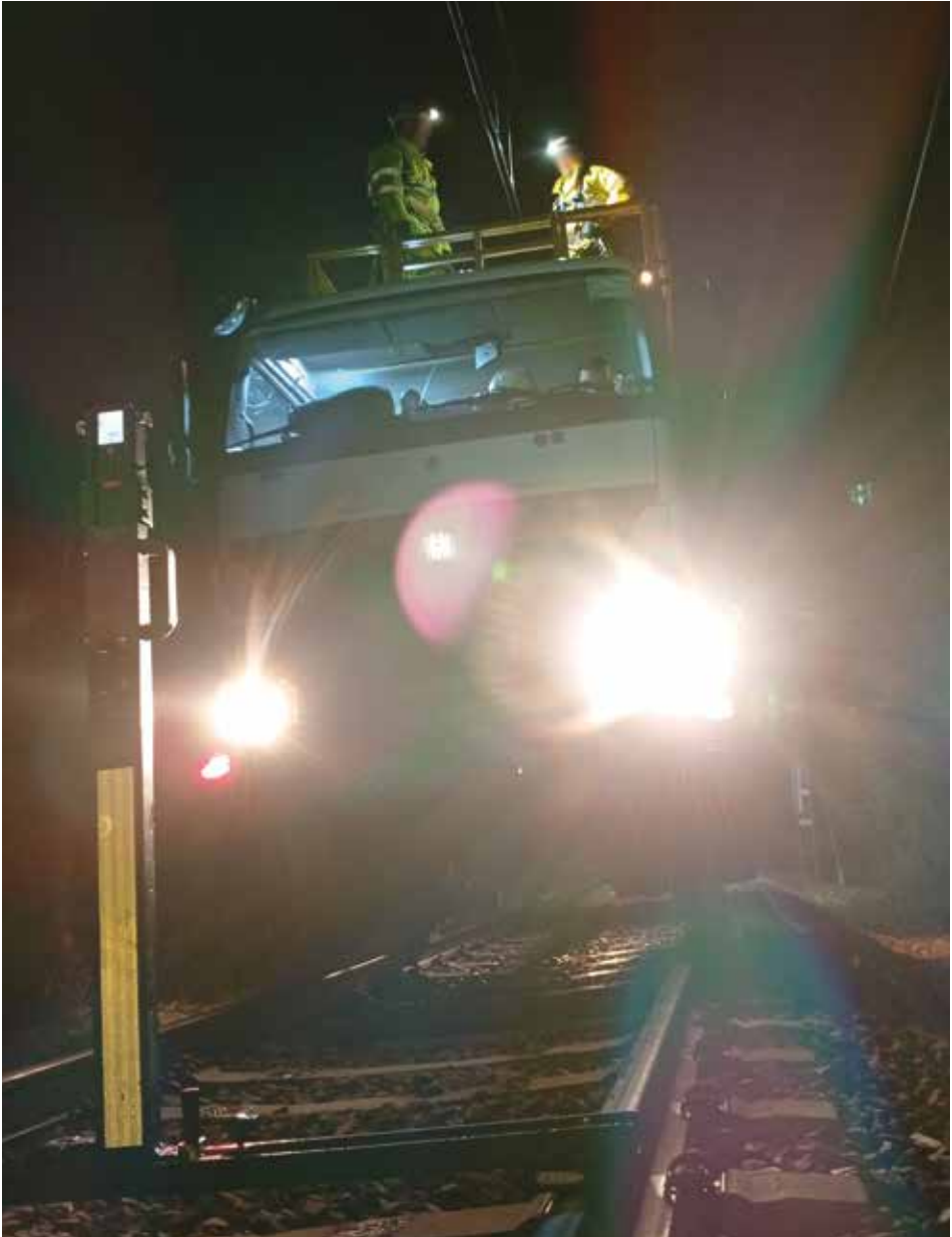
Fotografía 106. Trabajos en altura con medios de elevación mecánicos.
