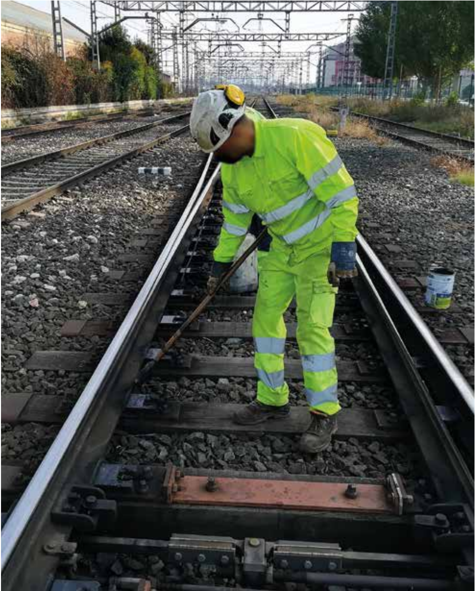
Fotografía 97. Engrase de aparatos de vía.
