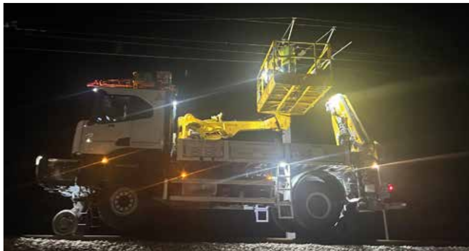
Fotografía 132. Ferrocamión con castillete o grúa.
