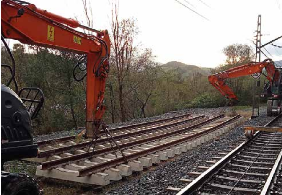
Fotografía 7. Carga de parejas por dos retroexcavadoras biviales.
