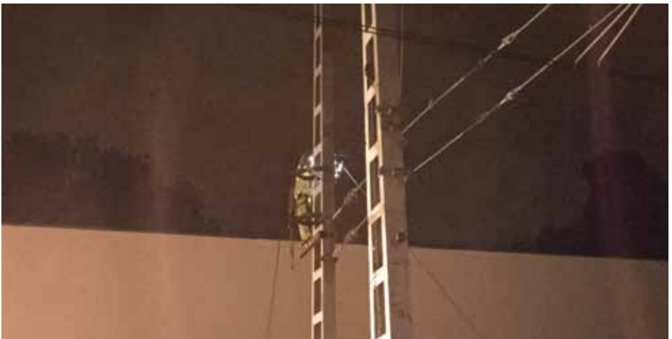
Fotografía 114. Trabajos sobre poste.
