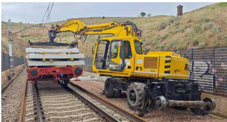
Fotografía 92. Descarga de traviesas con retroexcavadora bivial .
