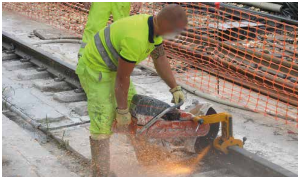
Fotografía 27. Corte de carril con tronadora.
