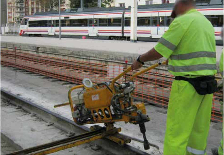
Fotografía 28. Afloje de sujeciones con motoclavadora de carril.
