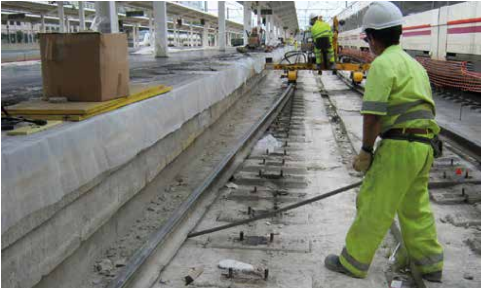
Fotografía 29. Cambio de carril.
