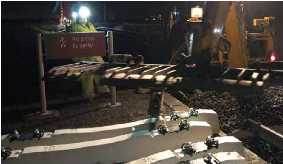
Fotografía 19. Maniobra de desplazamiento de la carga.
