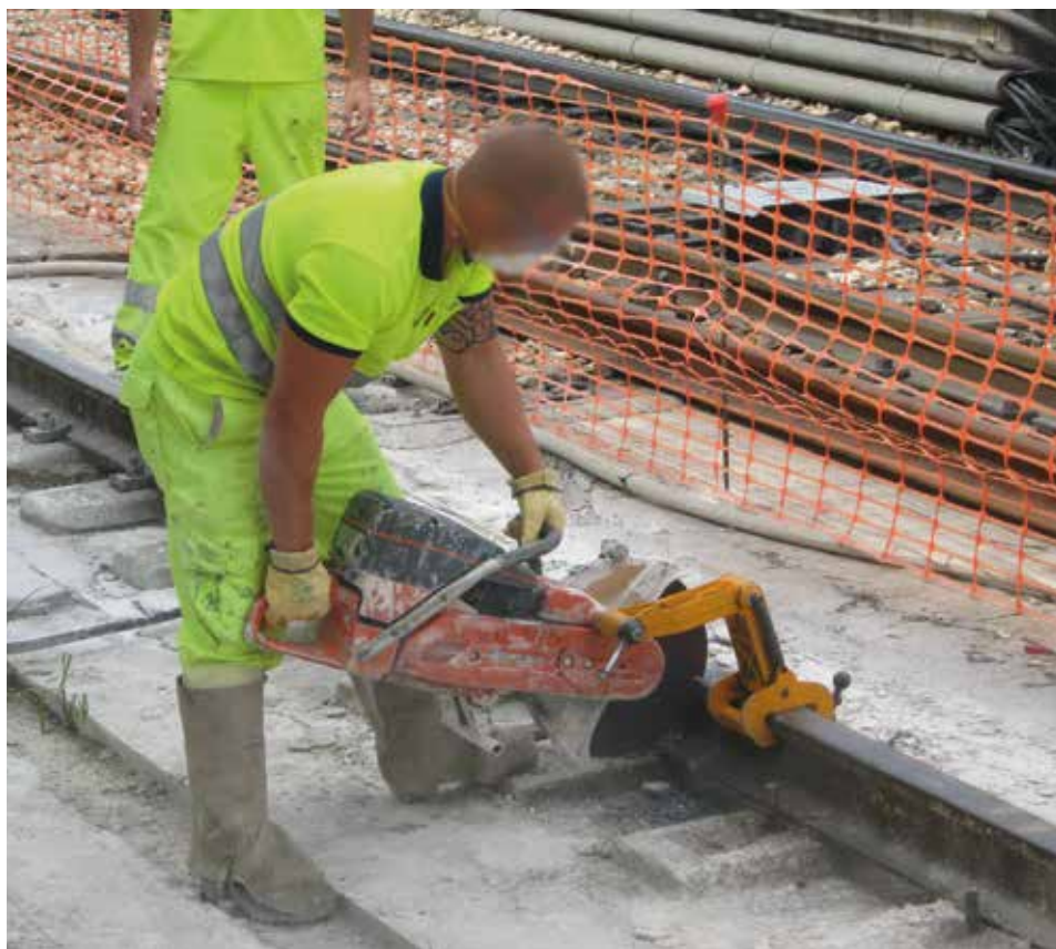
Fotografía 78. Corte de carril mediante tronzadora.
