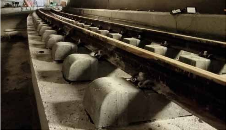
Fotografía 33. Nuevo tramo de vía en placa.
