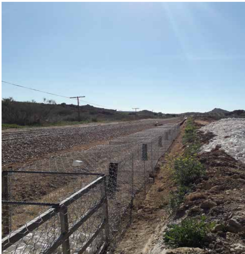
Fotografía 67. Muro de gaviones.
