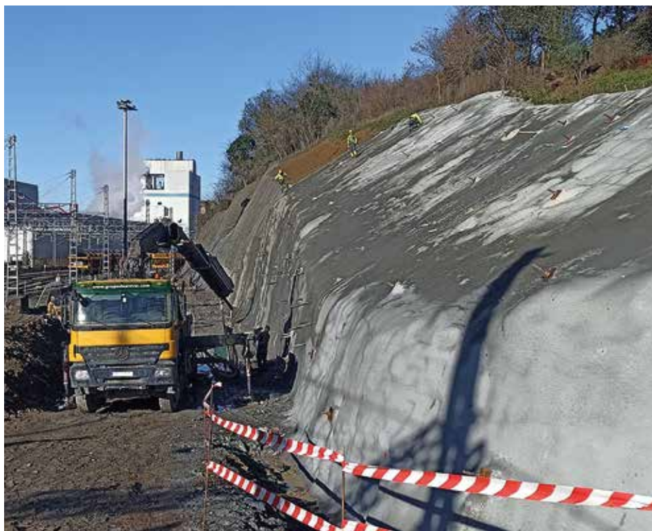
Fotografía 56. Colocación de anclajes y bulones.
