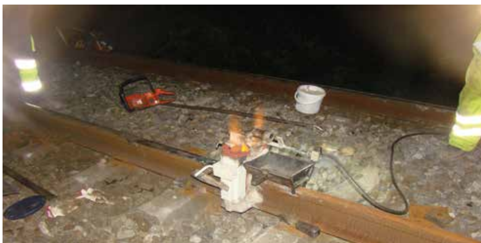
Fotografía 131. Equipo de soldadura aluminotérmica (crisol, carga y pistola de ignición).
