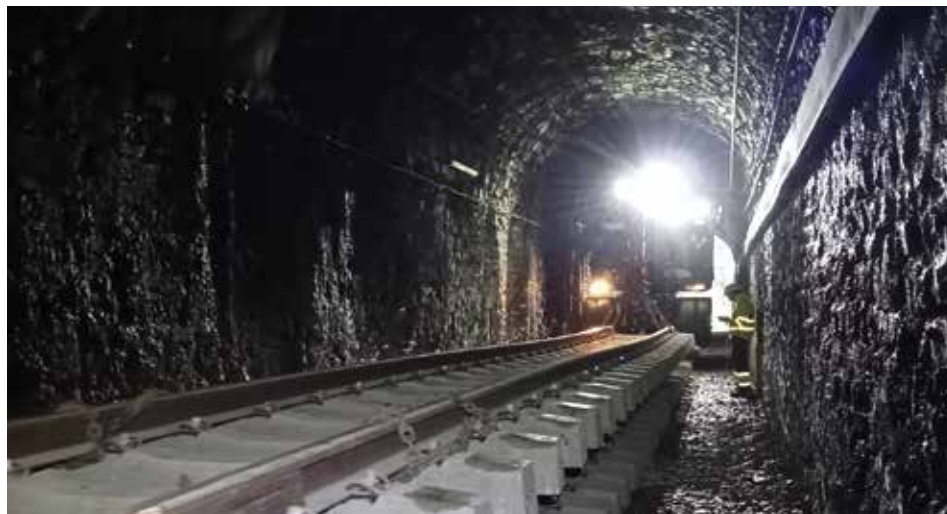
Fotografía 20. Personal necesario manteniendo distancia de seguridad previamente establecida.
