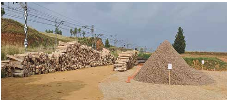
Fotografía 16. Acopio de balasto.
