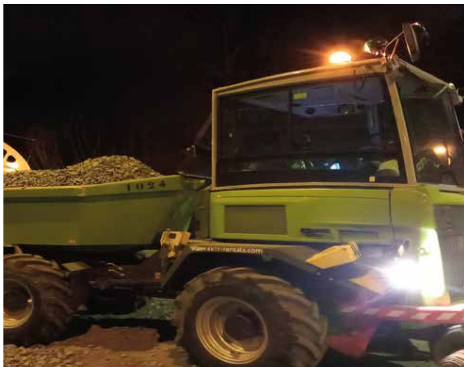
Fotografía 73. Aporte de balasto mediante dumper.
