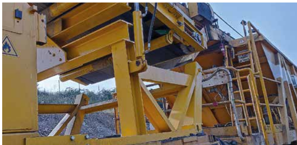
Fotografía 13. Plataforma lateral de descanso de la tolva.
