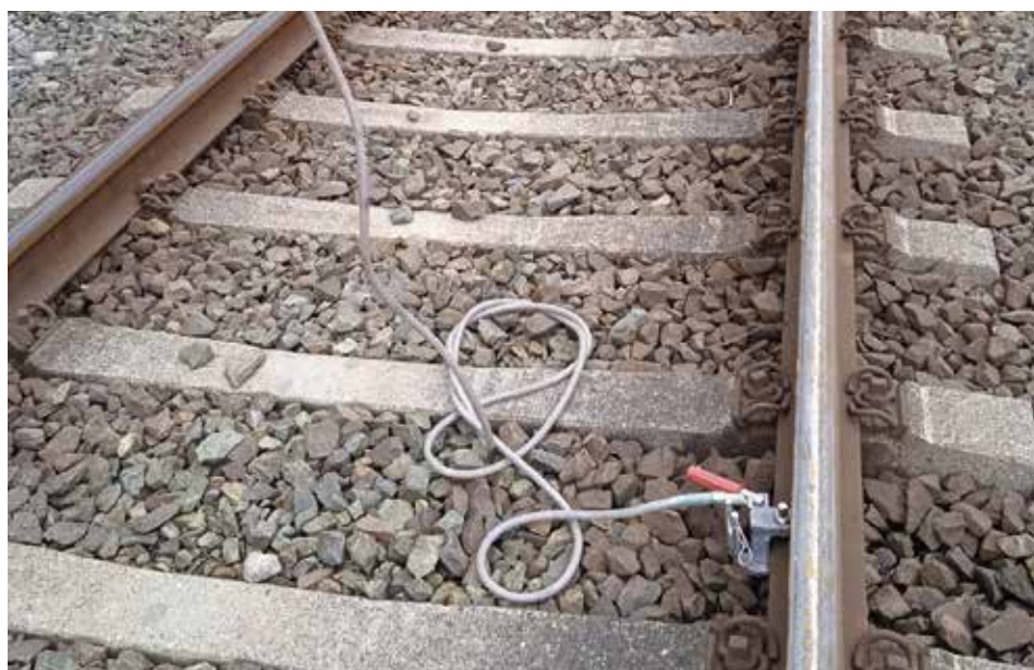
Fotografía 157. Toma de tierra del carril.
