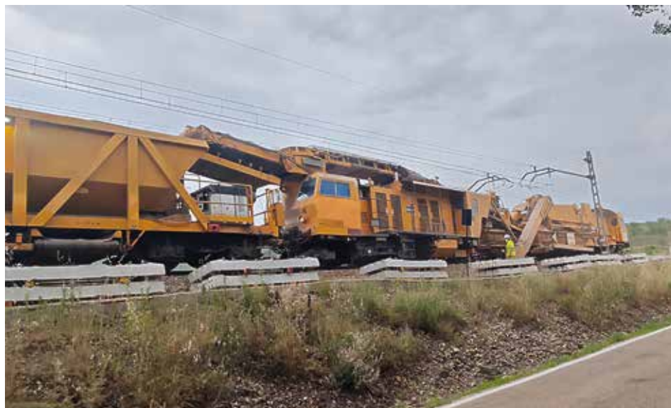
Fotografía 1. Máquina desguarnecedora y tren de cintas.
