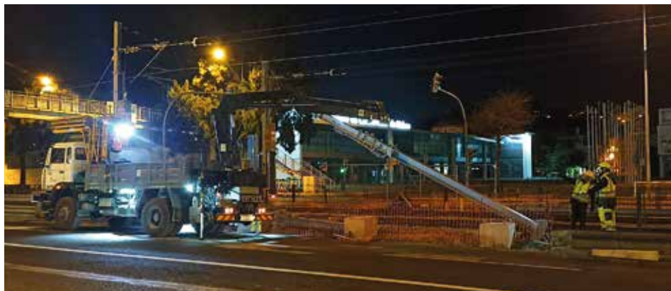
Fotografía 115. Izado de poste sujeto.
