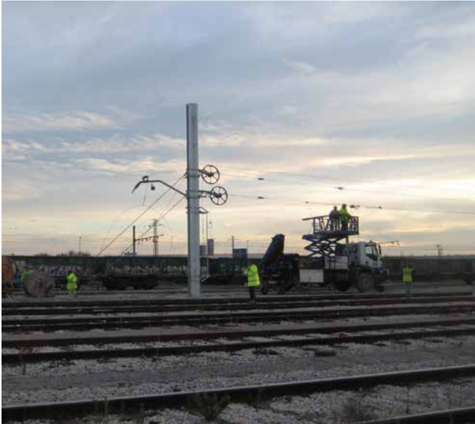
Fotografía 108. Reparación o sustitución de elementos de instalación de catenaria.
