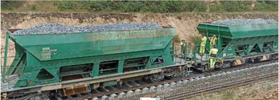
Fotografía 11. Personal trabajador subiendo a un tren de tolvas.
