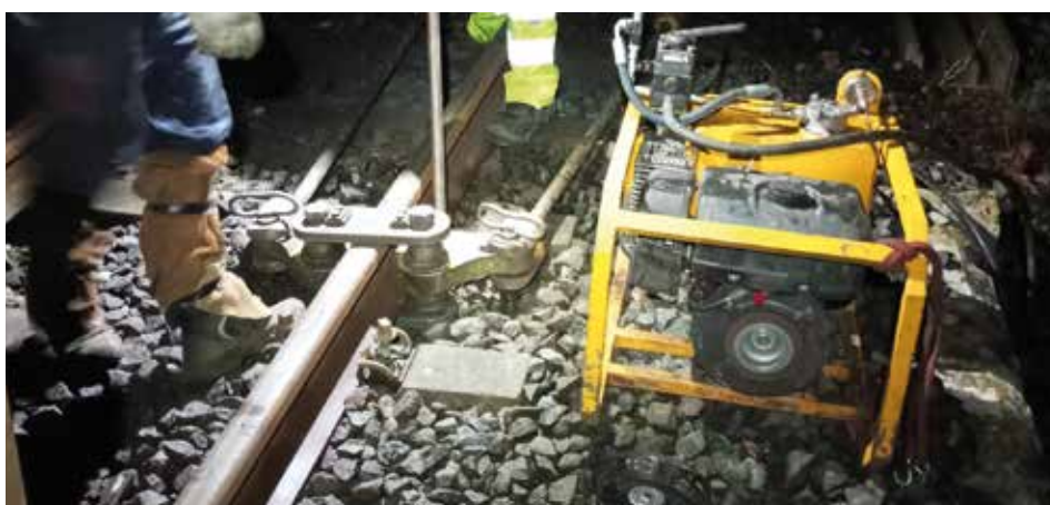
Fotografía 153. Tensor hidráulico con compresor (equipo de liberación de tensiones).
