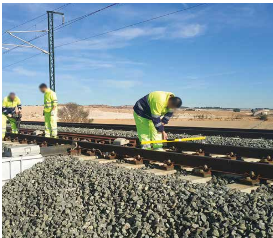
Fotografía 72. Inspección de vía.
