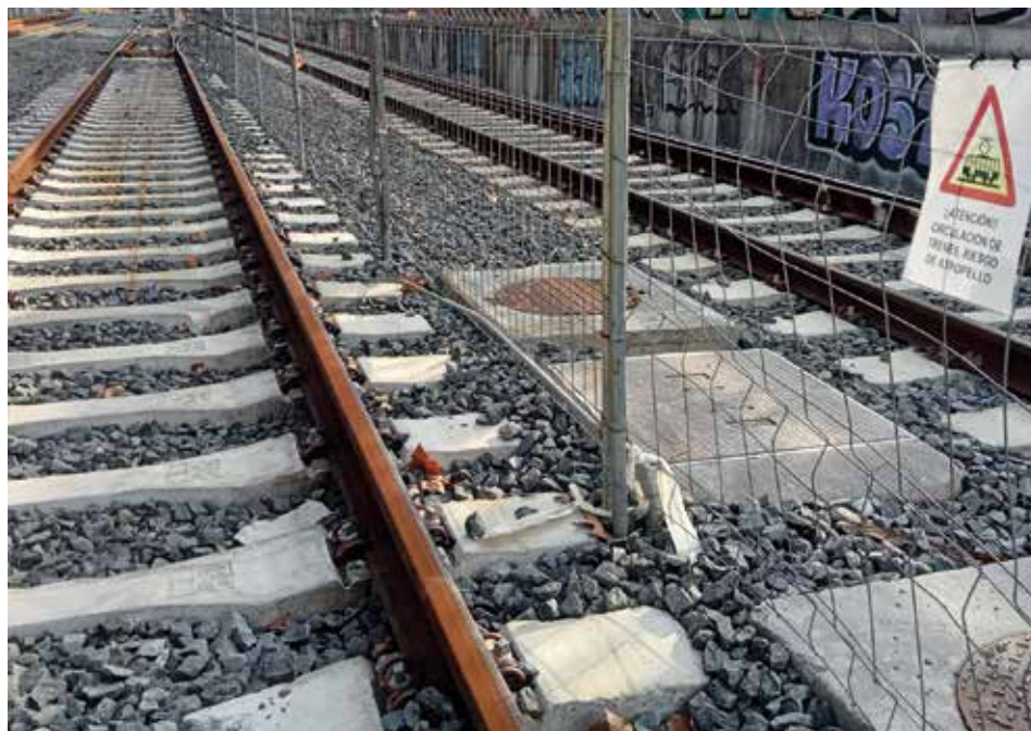
Fotografía 155. Ejemplo de cerramiento en trabajos en zona de dominio.
