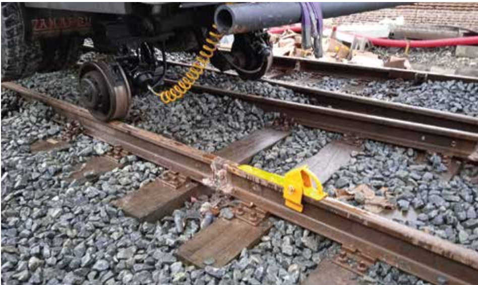
Fotografía 26. Calzo específico de carril.
