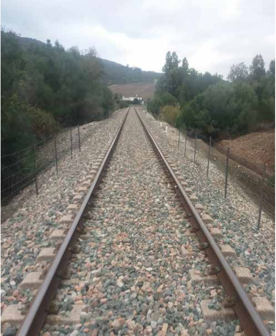
Fotografía 68. Protección de ODT-3.
