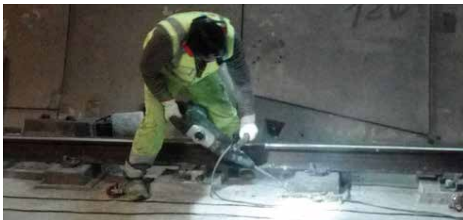
Fotografía 31. Demolición de losa de hormigón con martillo.
