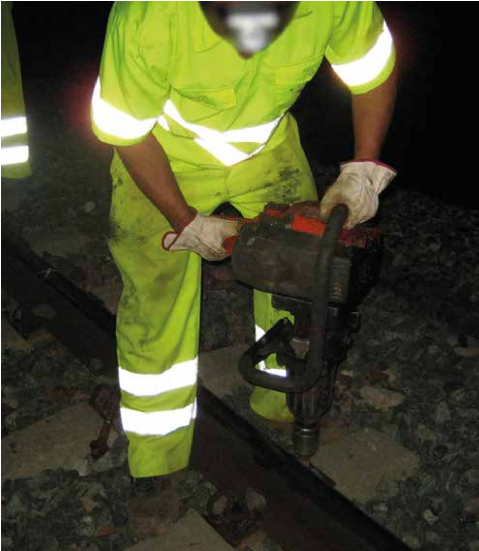
Fotografía 89. Uso de clavadora.
