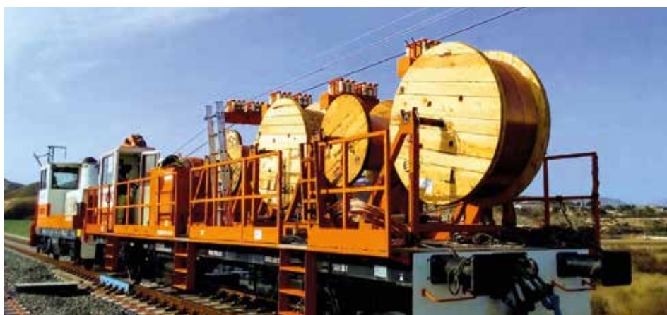
Fotografía 149. Tren de tendido de catenaria.
