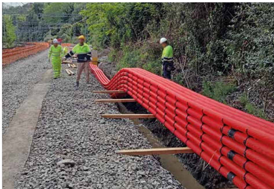
Fotografía 118. Delimitación de superestructura y balizamiento de vía.
