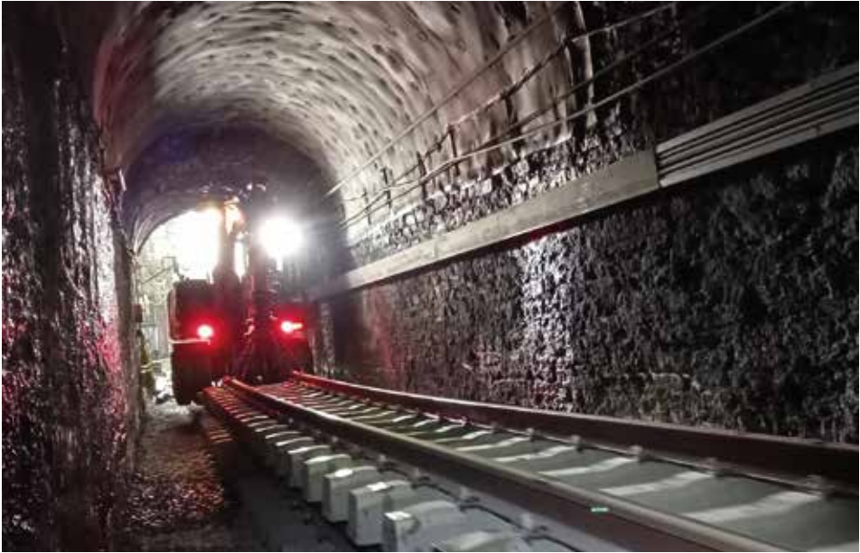
Fotografía 25. Circulación en el interior del túnel.
