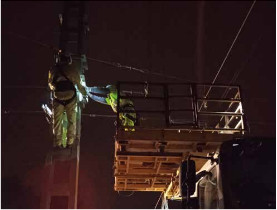
Fotografía 113. Trabajos sobre poste y castillete.
