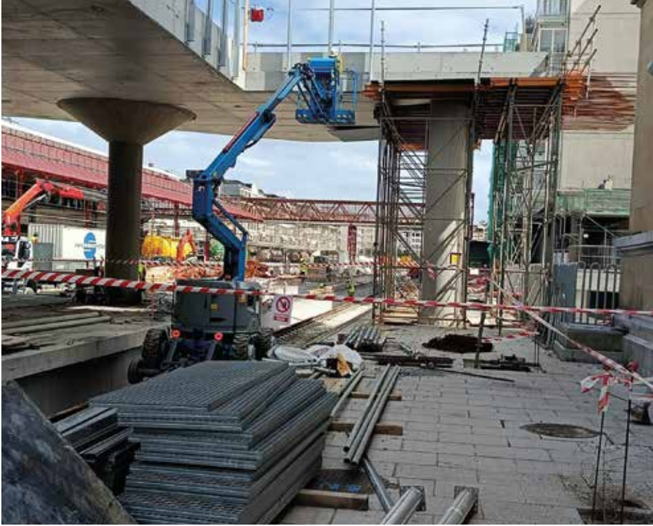
Fotografía 53. Zona de trabajos delimitada.
