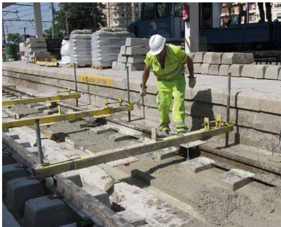
Fotografía 30. Hormigonado de una nueva losa.
