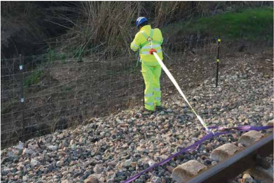
Fotografía 69. Personal trabajador utilizando arnés, línea de vida.
