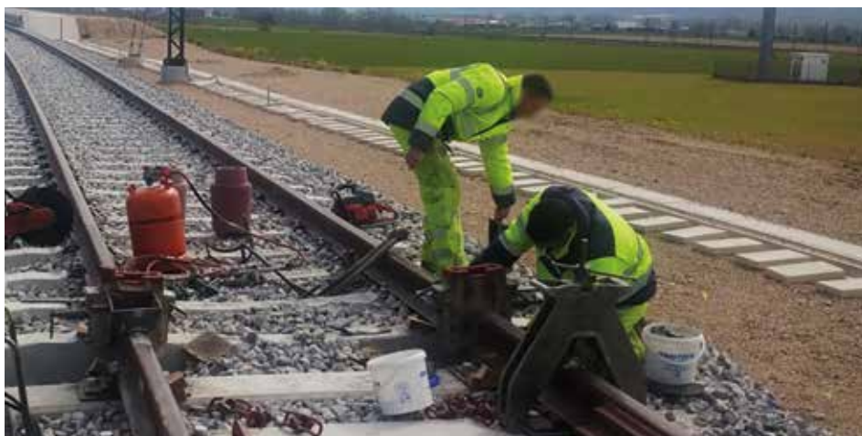
Fotografía 130. Equipo de calentamiento (carro quemador con botellas de aire-propano).
