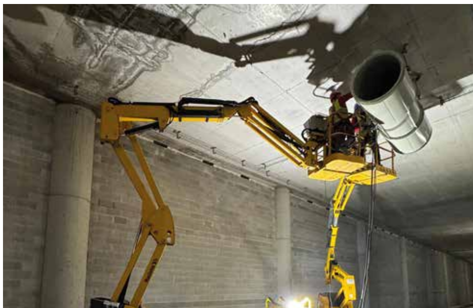
Fotografías 52. Reparaciones en zonas elevadas.
