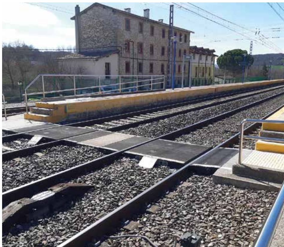
Fotografía 66. Paso a nivel de material asfáltico.
