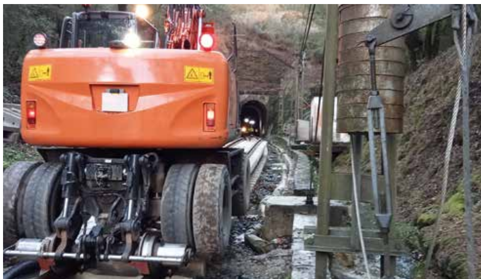
Fotografía 23. Maquinaria adaptada para circular sobre la vía.
