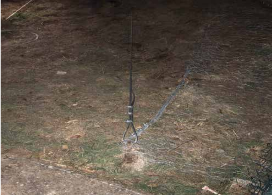
Fotografía 63. Malla fija al terreno.
