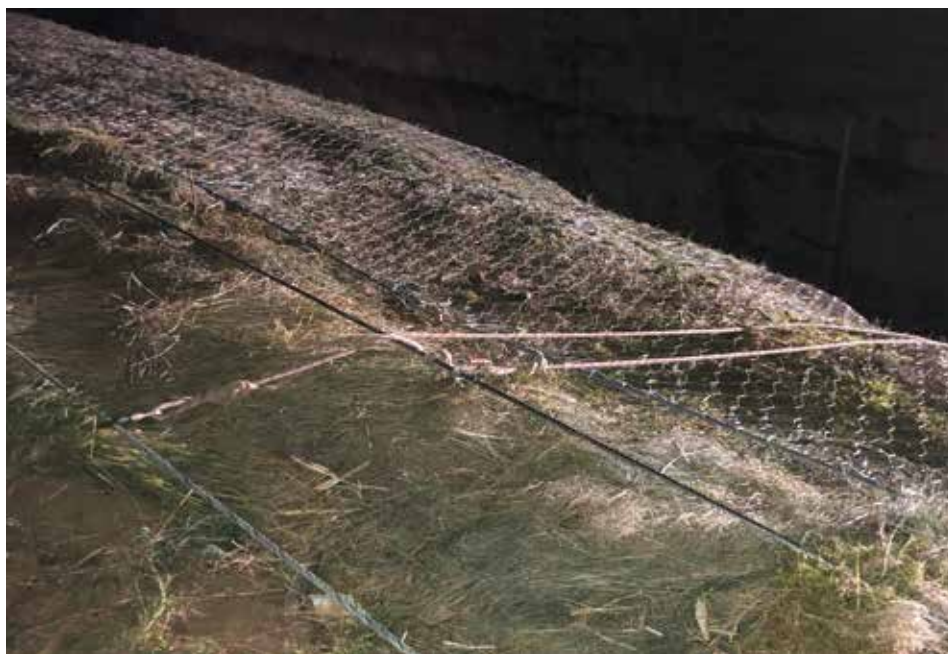
Fotografía 62. Dos cuerdas de sujeción independiente, una como medio de acceso y de descenso y otra como medio de emergencia. Vigilar posible desgaste de las cuerdas por roce con la malla.
