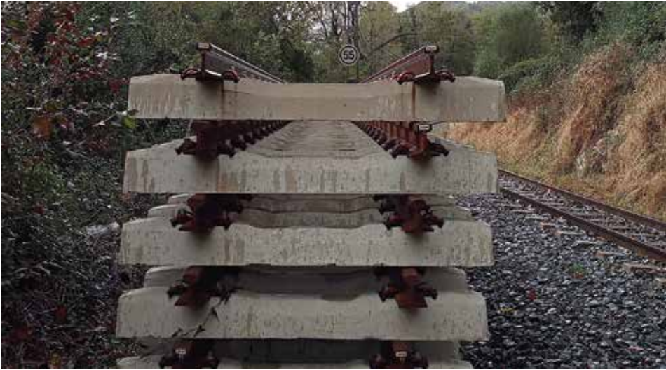
Fotografía 17. Se planificará la altura de los acopios.
