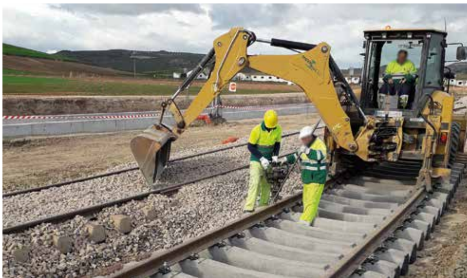
Fotografía 96. Personal trabajador utilizando clavadora.
