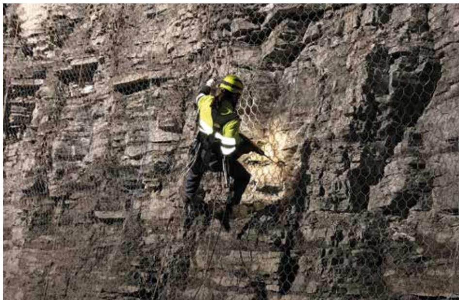
Fotografía 65. Personal trabajador en posición suspendida.
