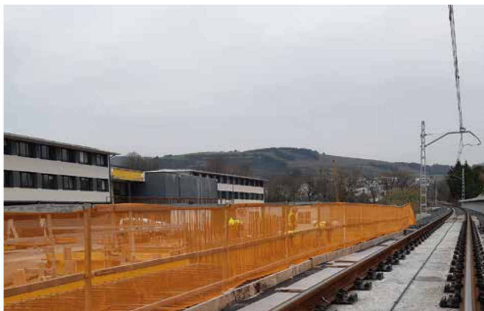
Fotografía 154. Ejemplo de cerramiento en trabajos en zona de dominio.
