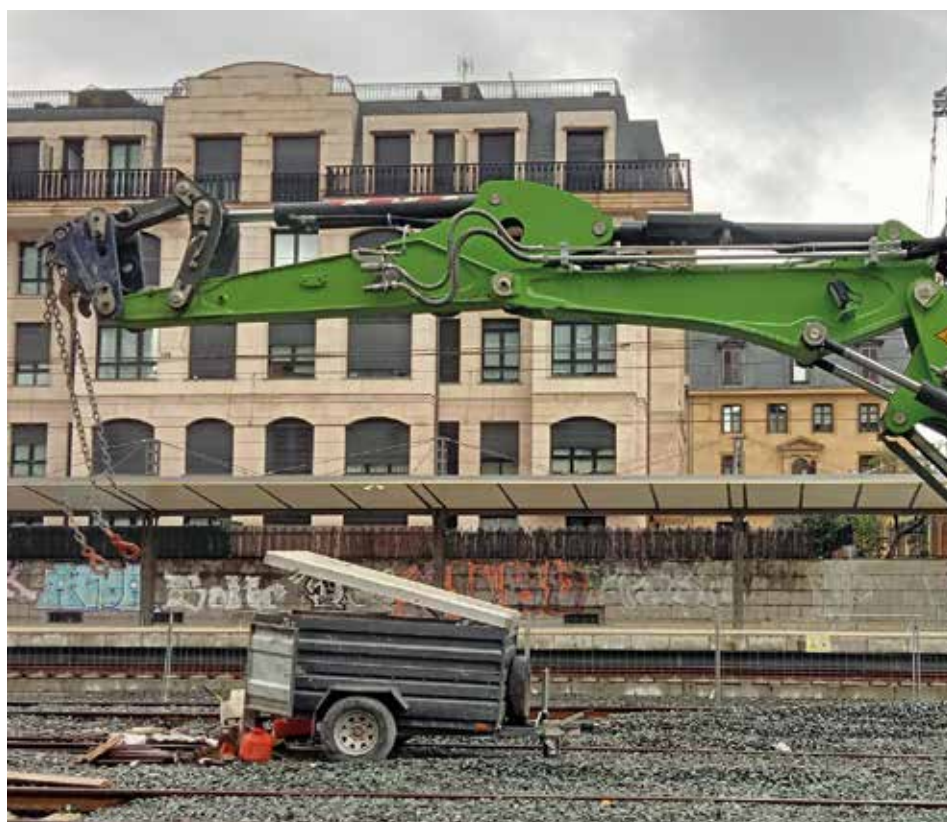
Fotografía 159. Retroexcavadora con limitador de altura.
