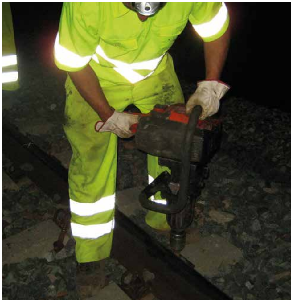
Fotografía 123. Clavadora impacto (mosquito) .
