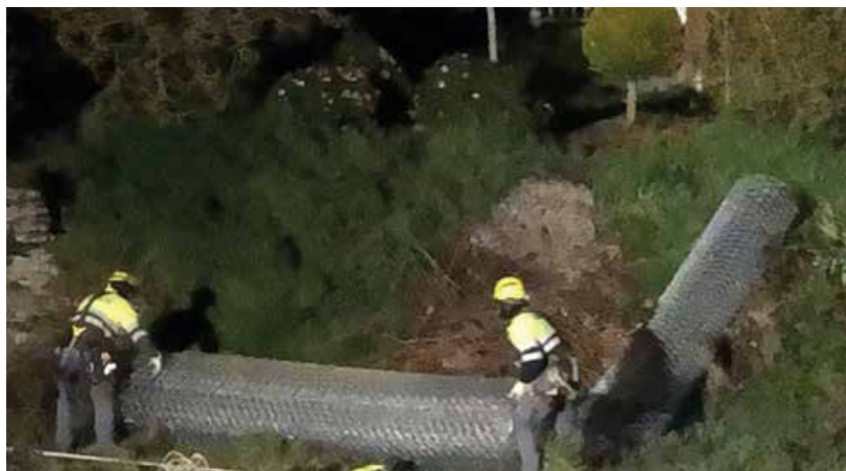
Fotografía 64. Uso de guantes de protección mecánica y casco con barbuquejo.
