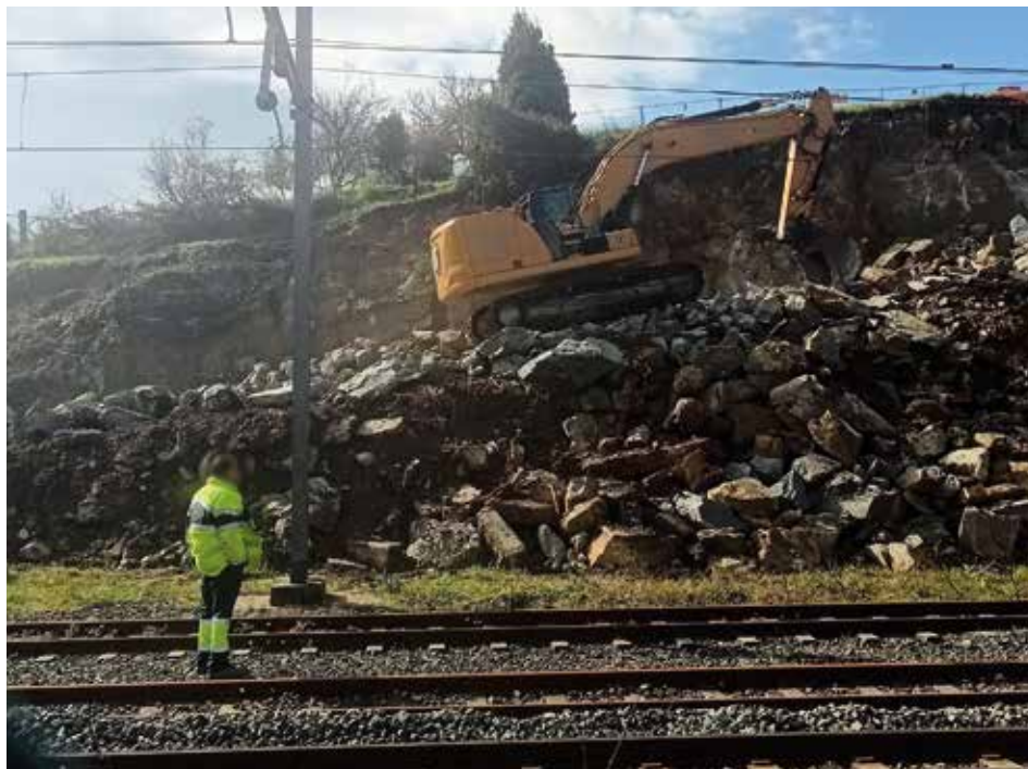
Fotografía 156. Personal encargado de trabajos verificando la zona.
