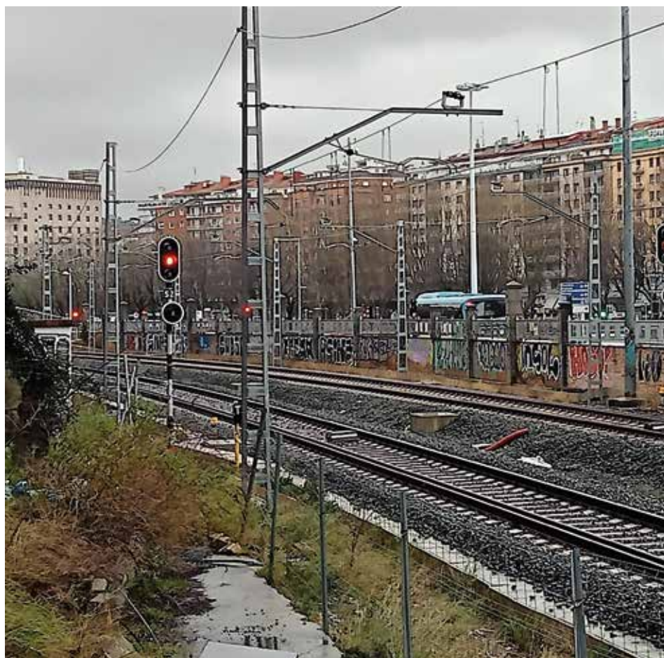
Fotografía 116. Señales en vía.
