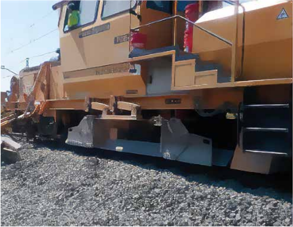
Fotografía 103. Perfilado de banqueta.
