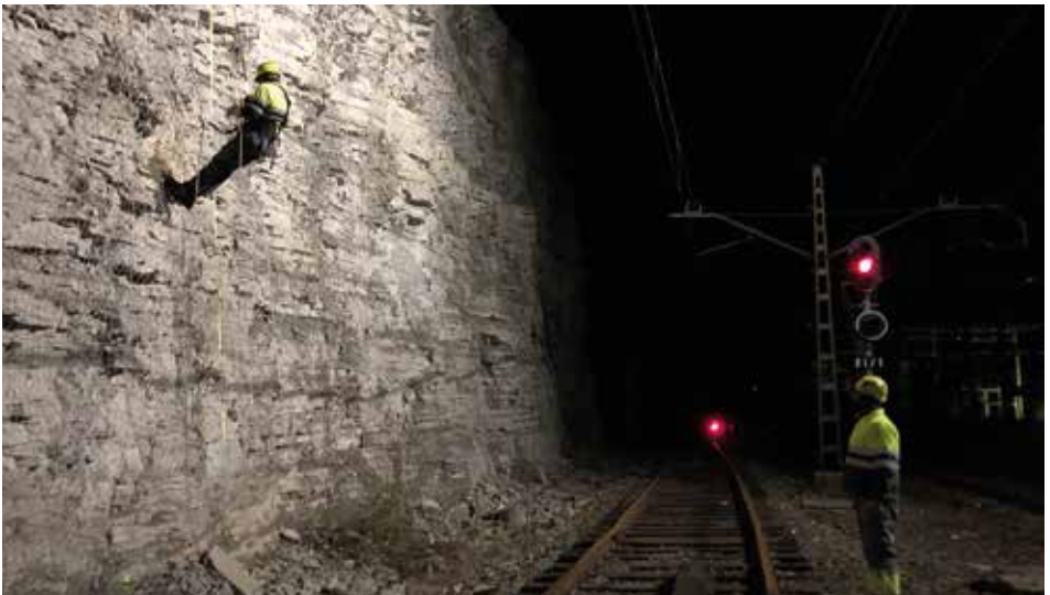
Fotografía 61. Uso de medios de protección individual, supervisando su correcta utilización.
