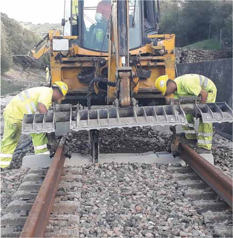
Fotografía 95. Traviesa situada bajo el carril.
