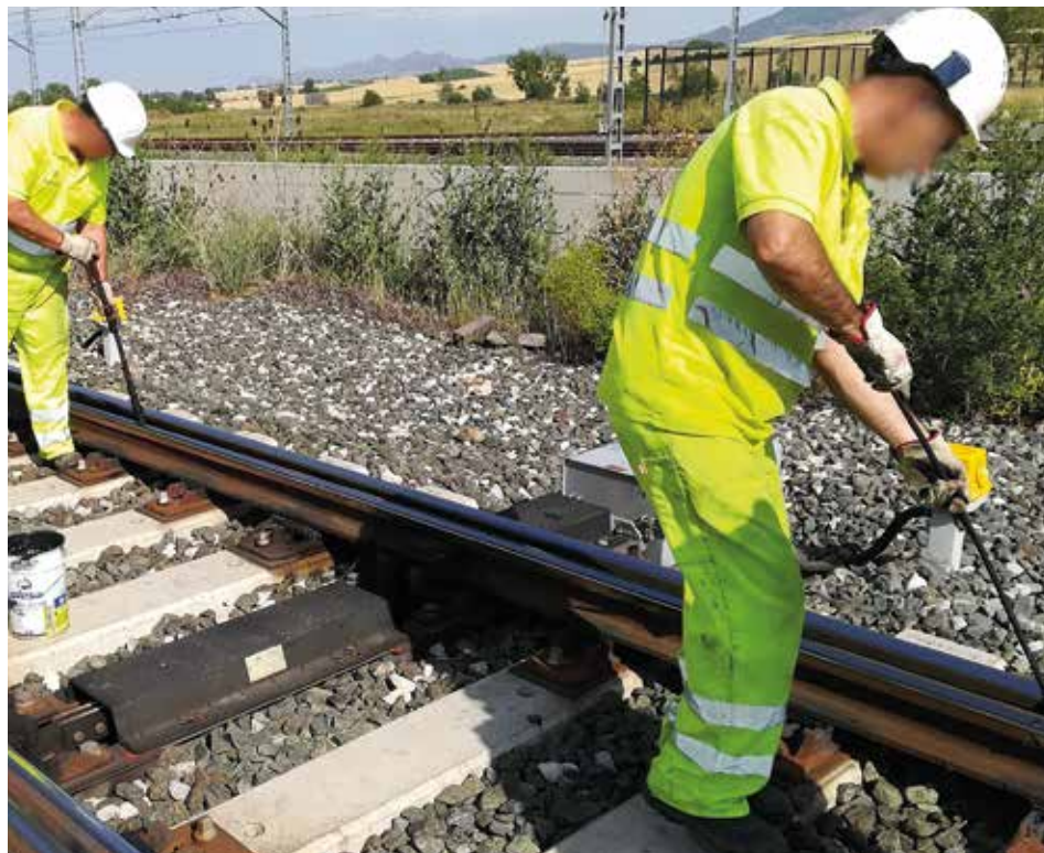
Fotografía 98. Zona de trabajo ordenada y limpia.
