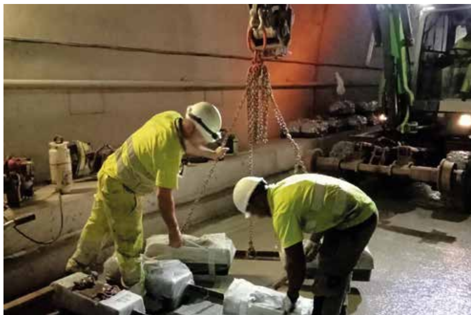
Fotografía 34. Movimiento de traviesa con cadenas.
