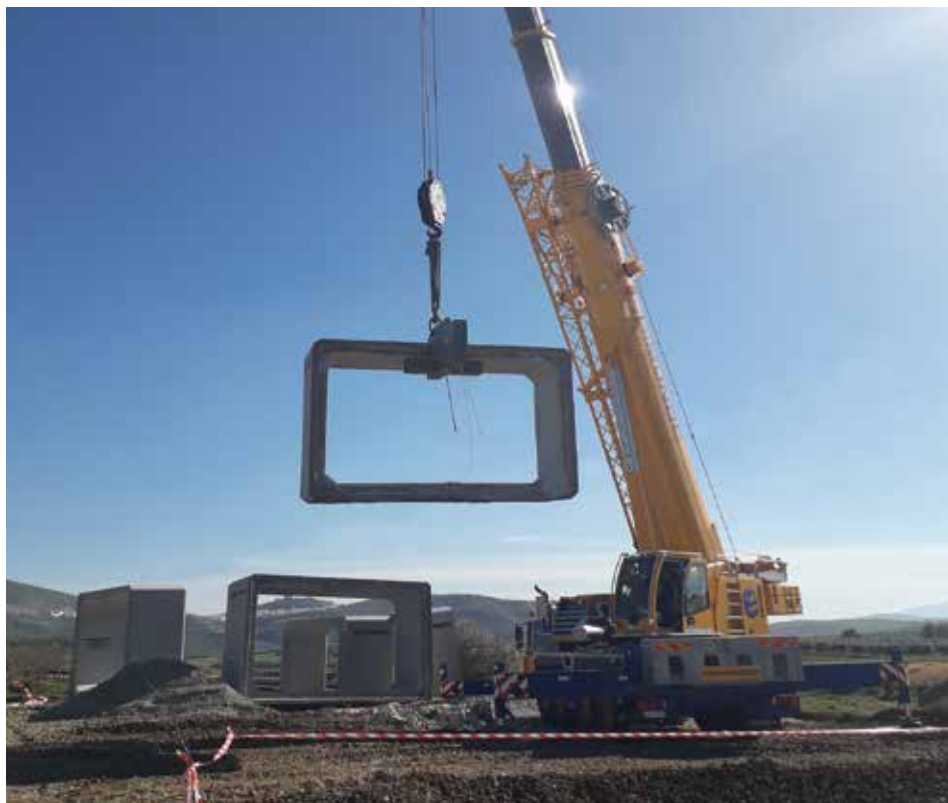
Fotografía 54. Carga correctamente sujeta.
