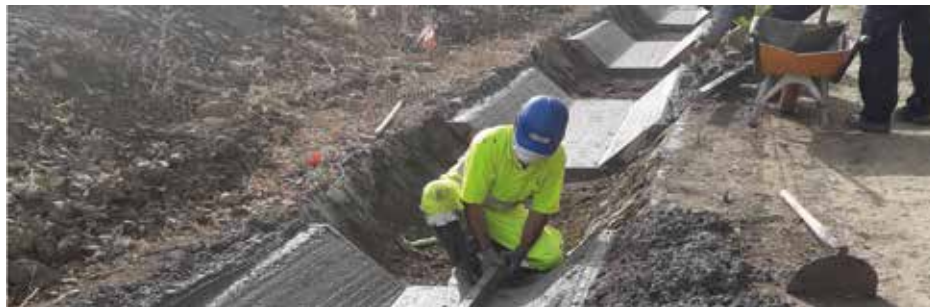
Fotografía 55. Manipulación de sustancias cáusticas y corrosivas empleando los equipos de protección individual adecuados.
