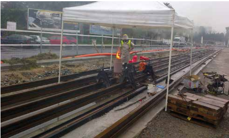
Fotografía 37. Trabajos de soldadura.
