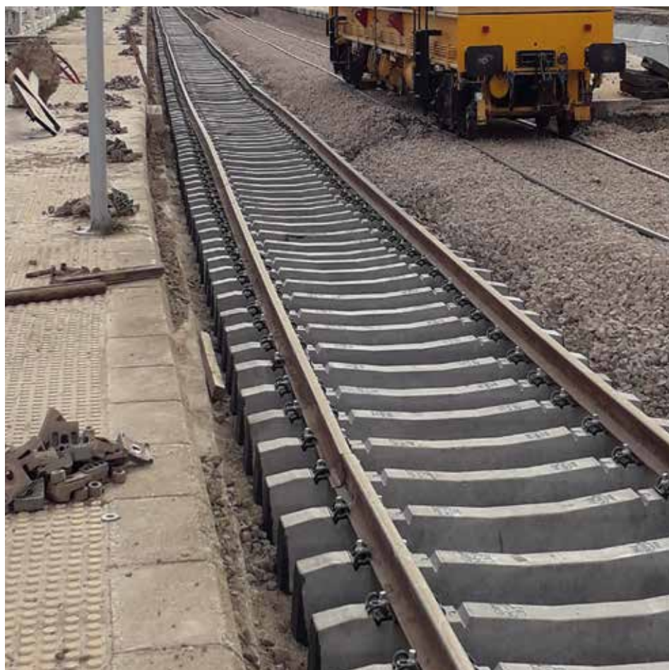
Fotografía 91. Tareas auxiliares, retirada de tornillería.
