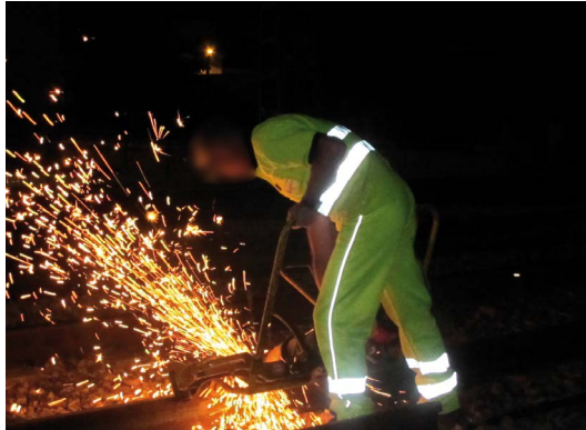
43. argazkia Soldadura aluminotermikoa. Errailaren esmerilaketa
