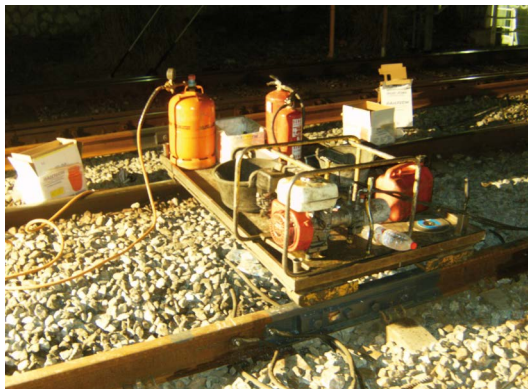
44. argazkia Soldadura aluminotermikoa. Mahai osagarria
