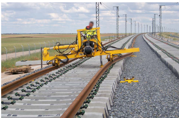
Fotografía 19 Montaje de barra larga soldada (BLS). Posicionamiento de carril
