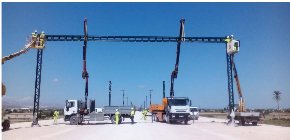
Fotografía 72 Montaje de pórticos, ménsulas y aisladores
