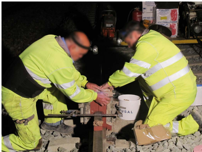
Fotografía 46 Soldadura aluminotérmica.
