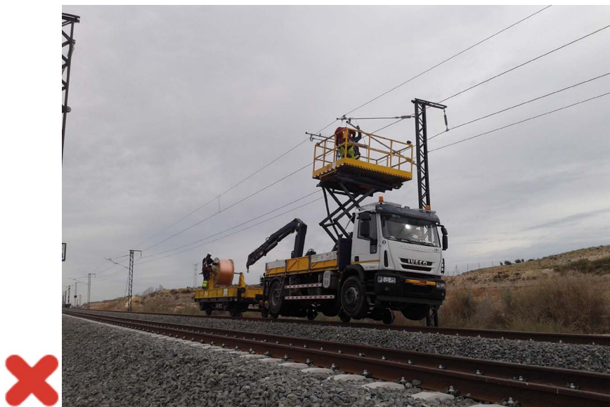
Fotografía 79 Tendido de elementos de catenaria. Riesgo de caídas de personas a distinto nivel
