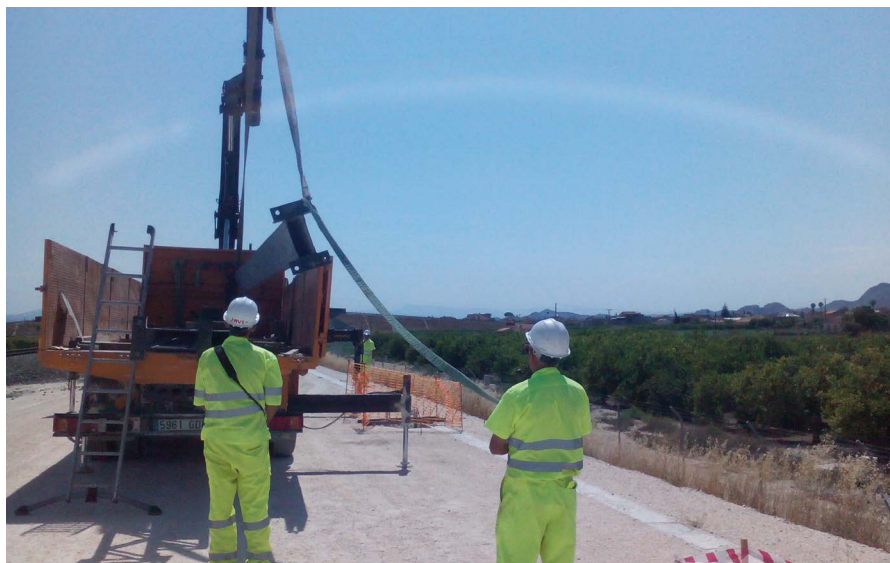
Fotografía 66 Replanteo, cimentación y colocación de postes. Riesgo de caída de objetos en manipulación
