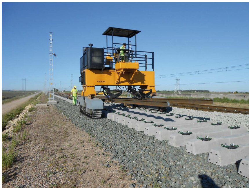
Fotografía 22 Montaje de carriles.
