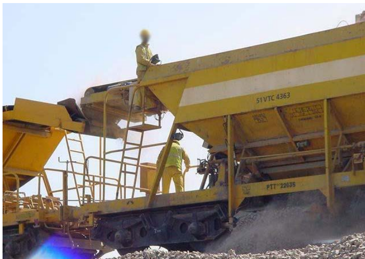
Fotografía 28 Aporte de balasto. Riesgo de caída de personas a distinto nivel
