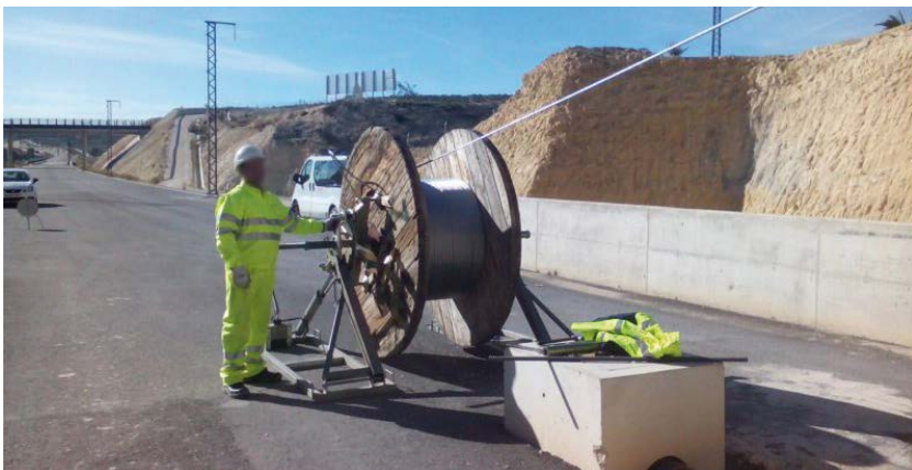
Fotografía 82 Tendido de elementos de catenaria. Riesgo de choques y contactos contra objetos móviles
