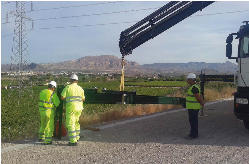
Fotografía 68 Replanteo, cimentación y colocación de postes. Riesgo de atrapamiento o aplastamiento por o entre objetos
