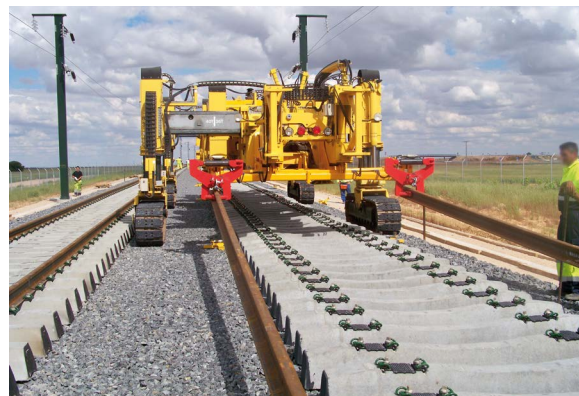
Fotografías 16, 17 y 18 Montaje de barra larga soldada (BLS). Mediante descarga directa sobre traviesas desde el tren carrilero
