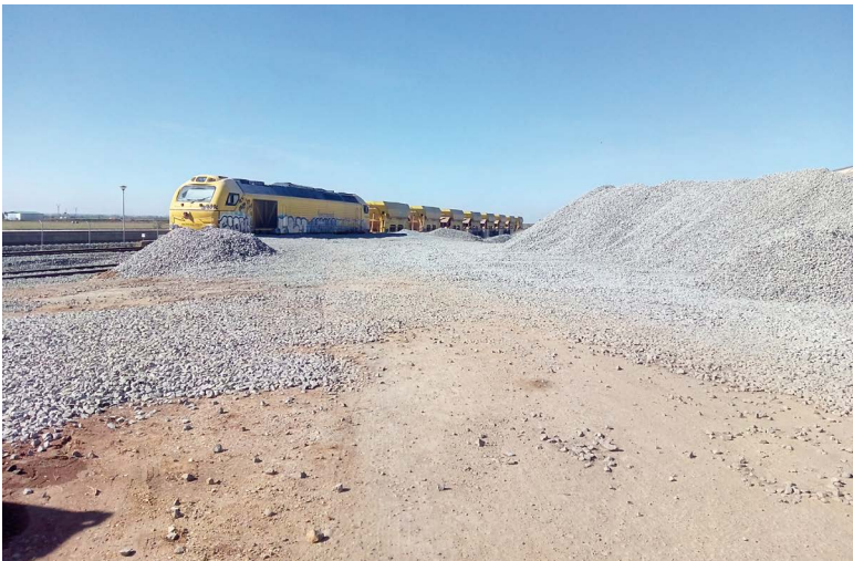
Fotografía 31 Acopio de balasto
