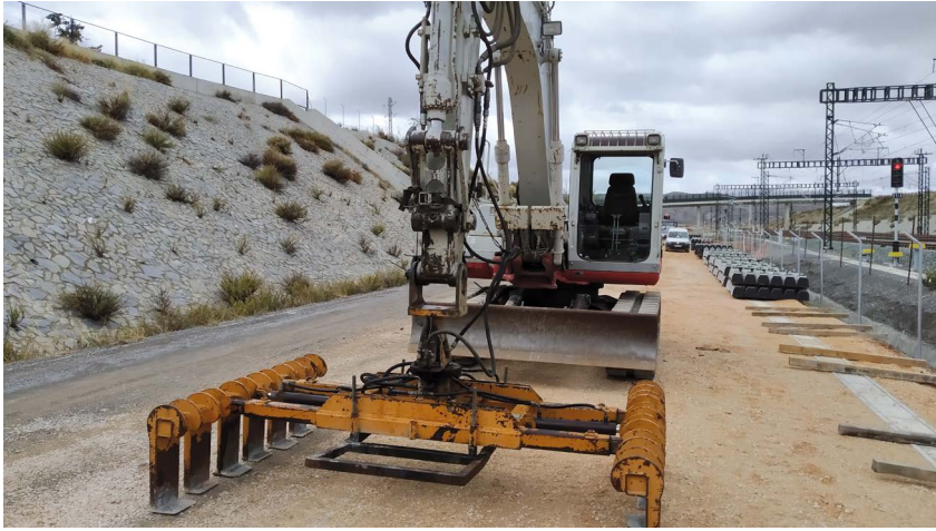
Fotografía 7 Transporte y descarga de traviesas. Accesorio de elevación
