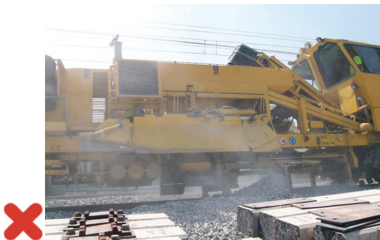
Fotografía 37 Perfilado de banqueta. Riesgo de exposición a sustancias nocivas
