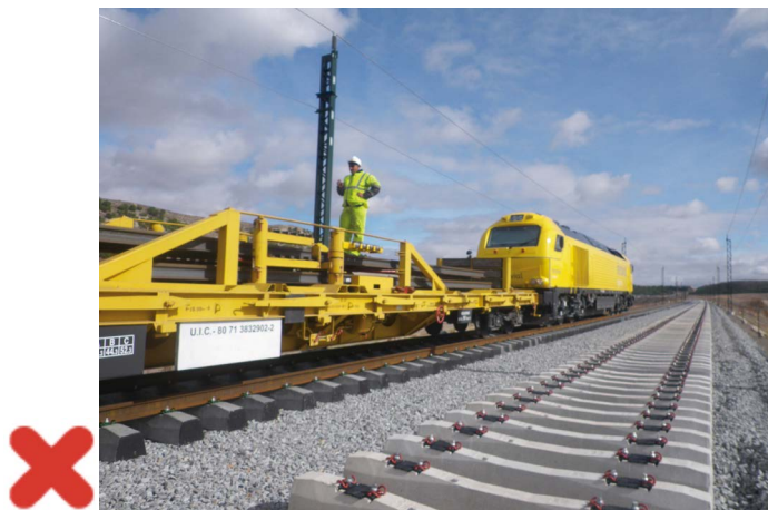
Fotografía 13 Transporte y descarga de carriles. Riesgo de caídas de personas a distinto nivel
