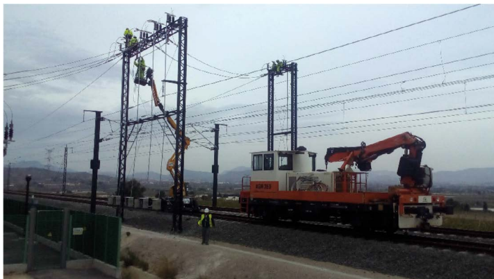
Fotografía 84 Montaje de aparamenta eléctrica. Riesgo de caídas de personas a distinto nivel
