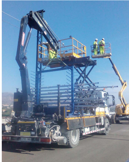
Fotografía 83 Montaje de aparamenta eléctrica. Riesgo de caídas de personas a distinto nivel
