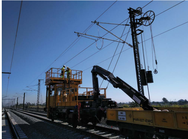
Fotografías 77 y 78 Tendido de elementos de catenaria
