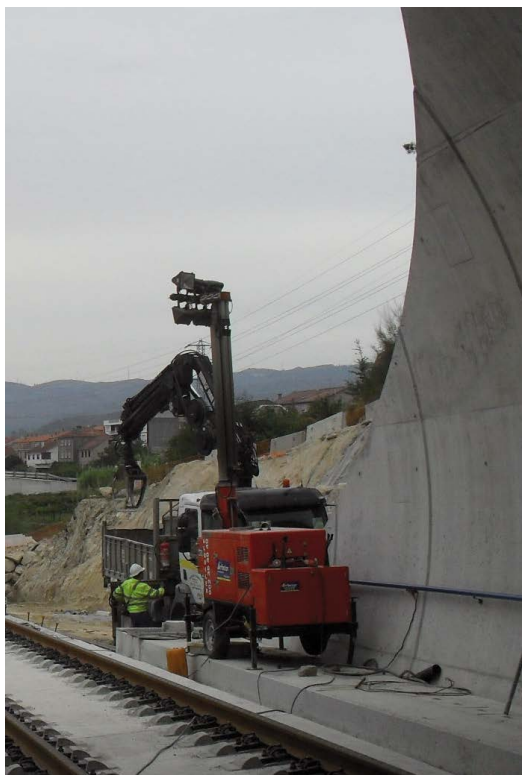
Fotografía 59 Montaje de vía en placa («in situ» y/o prefabricada). Riesgo de contacto eléctrico
