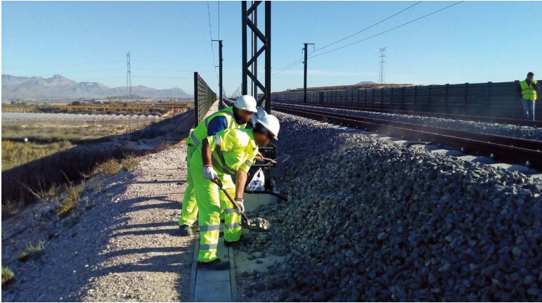
Fotografía 30 Aporte de balasto. Riesgo de proyección de fragmentos o partículas
