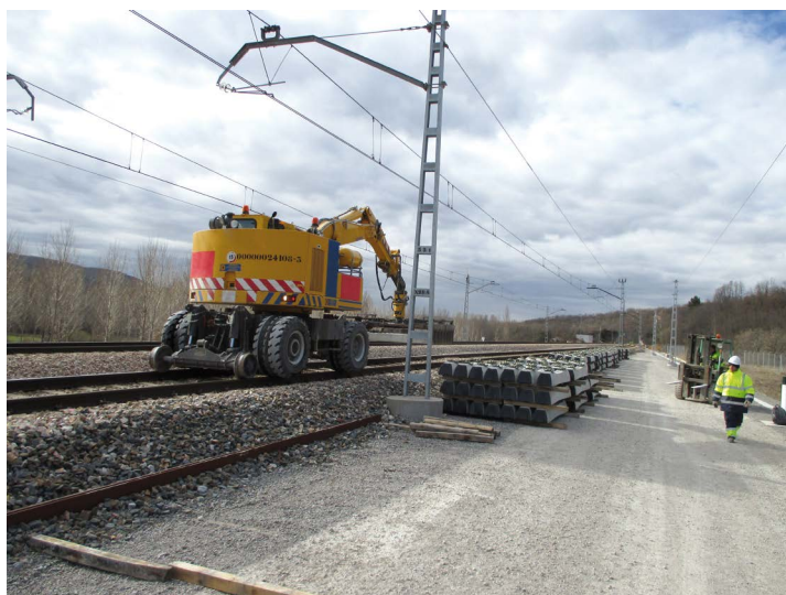
Fotografía 6 Transporte y descarga de traviesas. Acopio de materiales
