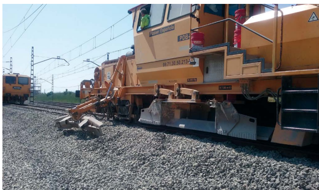
Fotografías 35 y 36 Perfilado de banqueta
