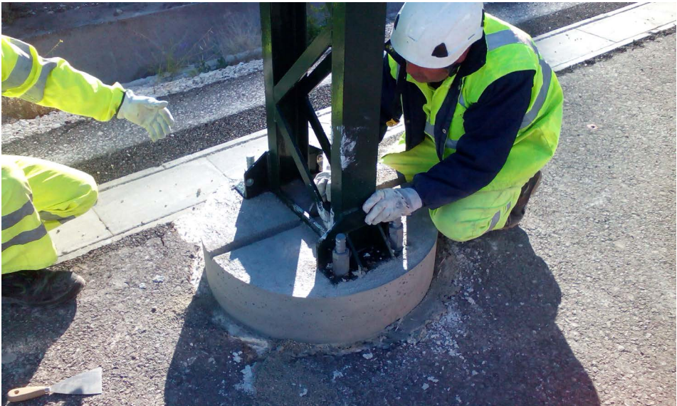
Fotografía 65 Replanteo, cimentación y colocación de postes. Riesgo de caída de objetos por desplome o derrumbamiento
