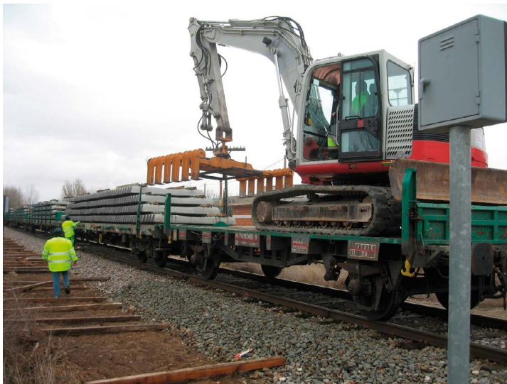
Fotografía 4 Transporte y descarga de traviesas. Con vía auxiliar
