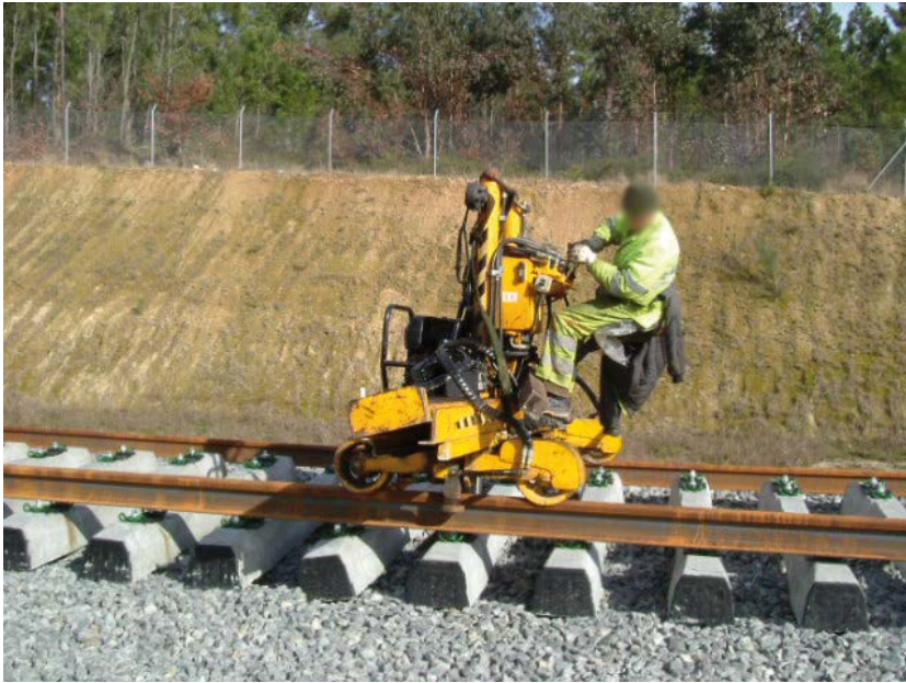
Fotografía 24 Montaje de carriles. Riesgo por exposición a vibraciones
