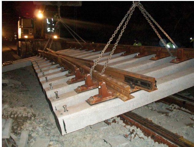
Fotografía 26 Montaje de aparatos de vía
