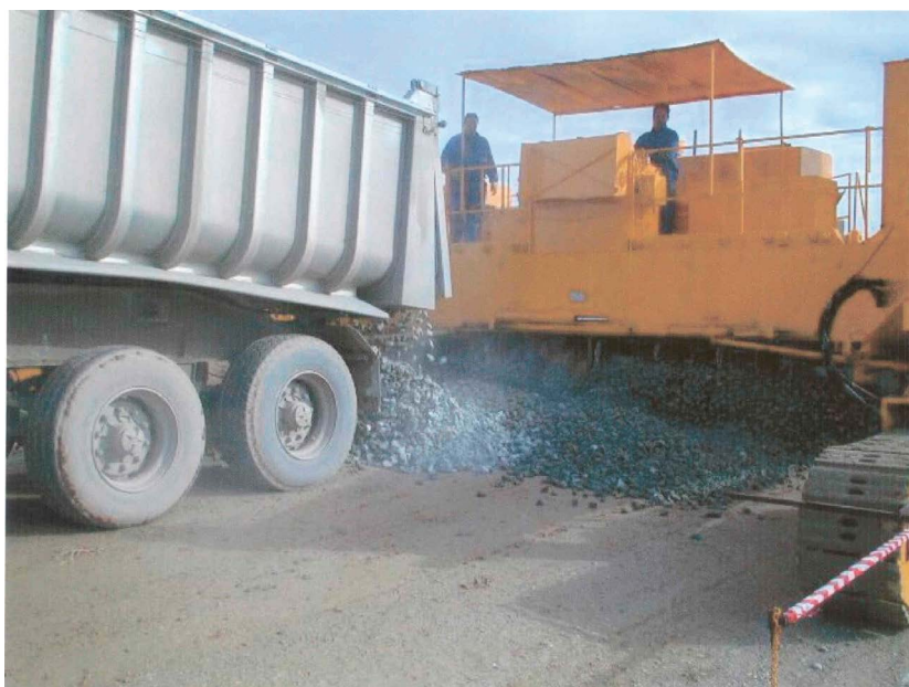
Fotografía 1 Extendido del lecho o capa de balasto
