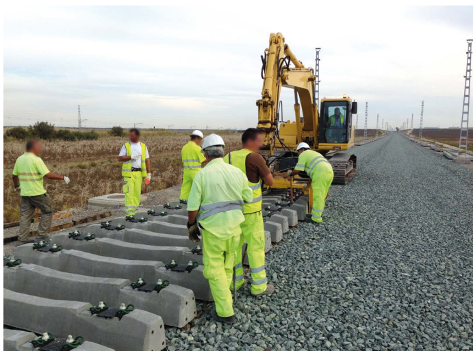
Fotografía 3 Transporte y descarga de traviesas. Sin vía Auxiliar
