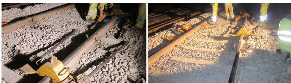
Fotografías 48 y 49 Liberación de tensiones
