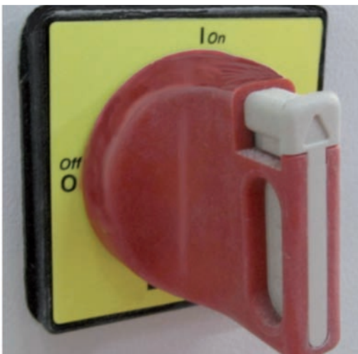
39. argazkia: ebakigailua abian dago, 1ean dago-eta. Giltzarrapoaren edo antzekoaren bidez ere blokeatu ahal izango da, beharrezkoa izanez gero.
