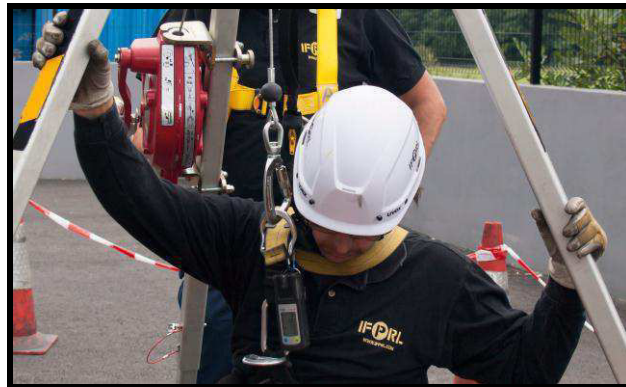
Gune konfinatuan gasen detektagailuarekin sartzea
