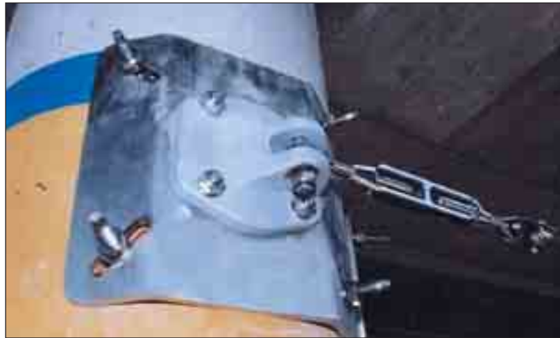
Anclaje a placa de acero inoxidable fijación a pilares redondos.
