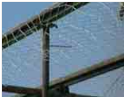
Detalle. Redes de seguridad fijadas con pasadores.
