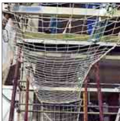
Red instalada en calle de perímetro mediante pasadores a puntales.
