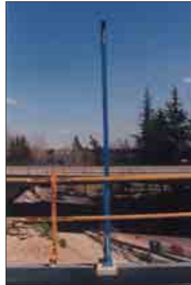
Taco de madera para dar mayor estabilidad al Sistema.
