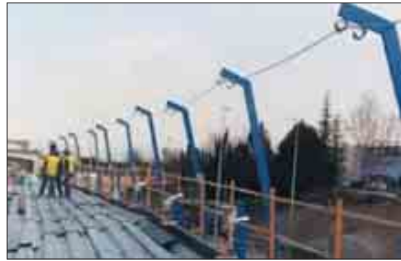
Cable guía instalado en espera de ser tensado.
