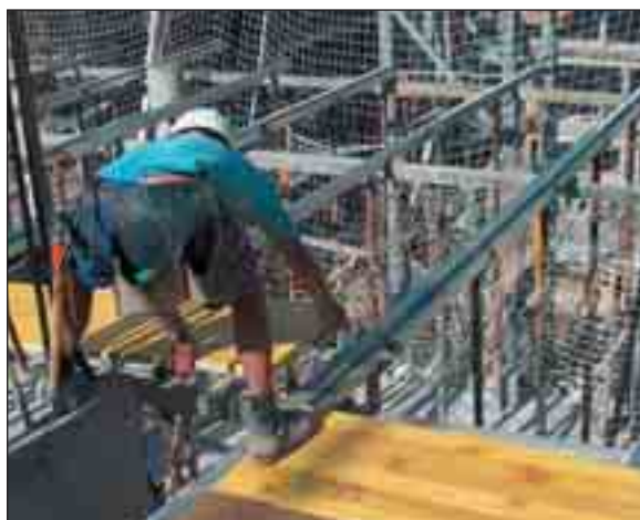
Operario colocando tableros con la protección de redes bajo forjado.
