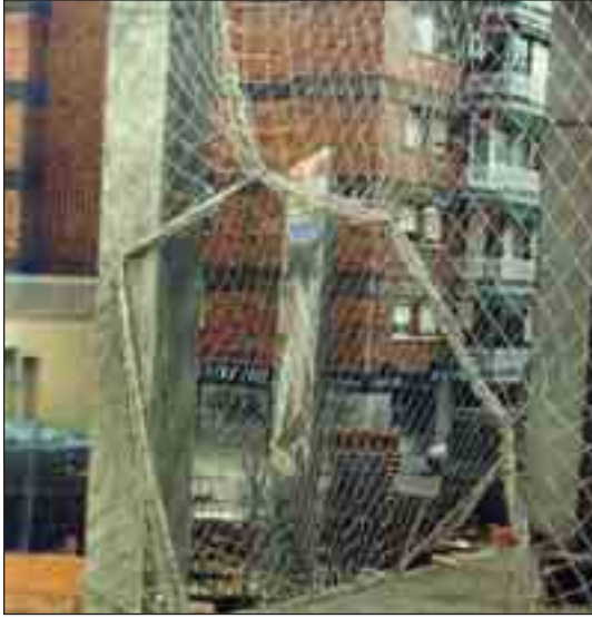
Entrada a obra.
