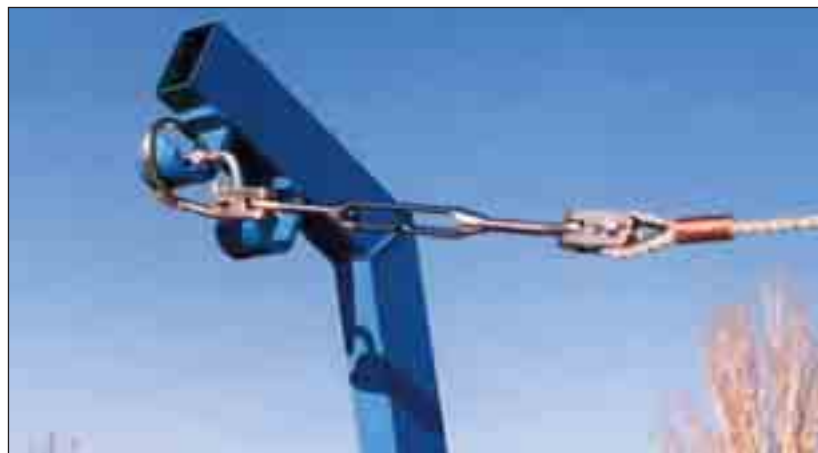
Mosquetones de fijación 30 kN, tensor caja abierta y cable guía.
