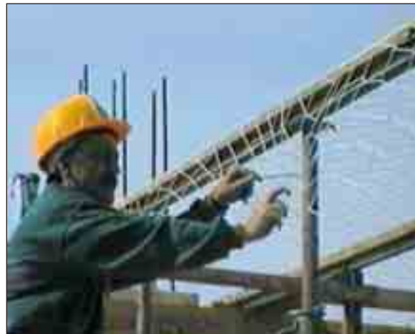
Una vez extendida la red de seguridad con la ayuda de medios auxiliares, el sobrante se introduce entre las esperas de los pilares, siendo éstos, su principal punto de apoyo .
