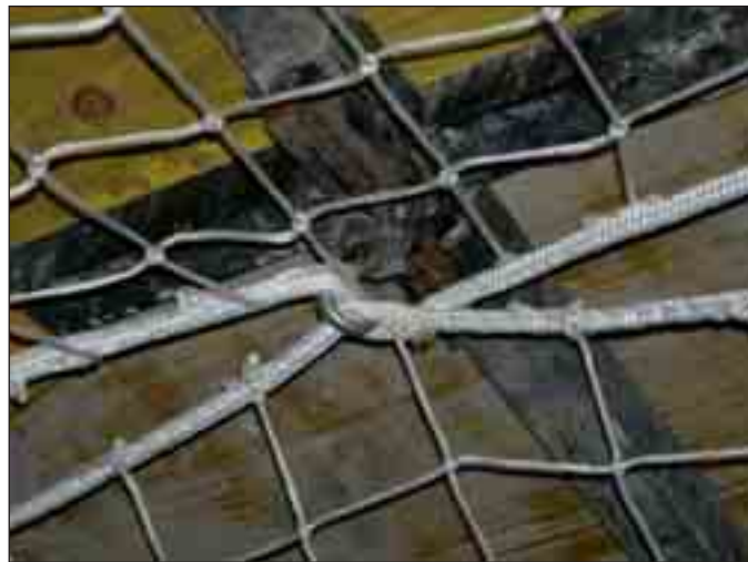
Sistema de red bajo forjado en el encofrado recuperable.
