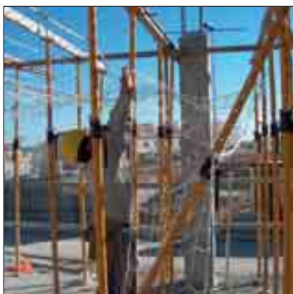
Operario instalando red desde el suelo.
