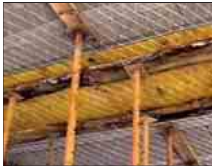
Red de seguridad bajo forjado. Vigueta y bovedilla. Tableros.
