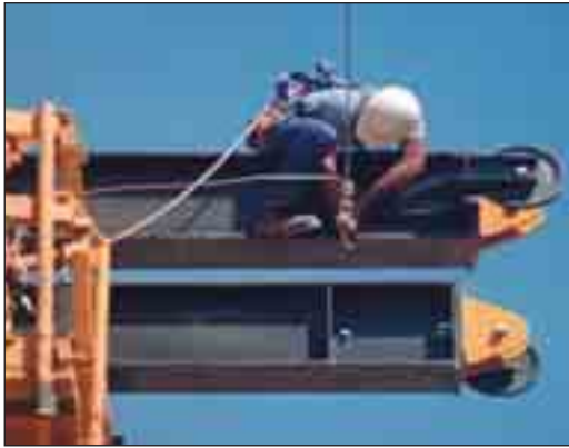
Instalación de cables guía para redes tipo toldo aplicando técnicas de alpinismo.
