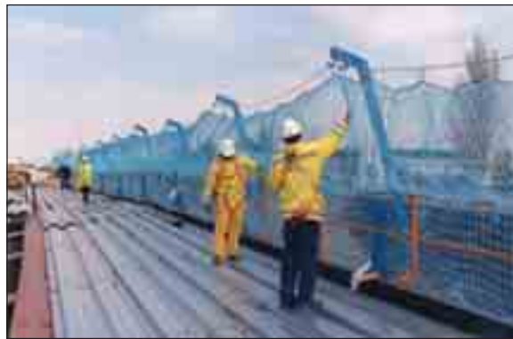
El siguiente paso consiste en la instalación de la red en los cables guía.
