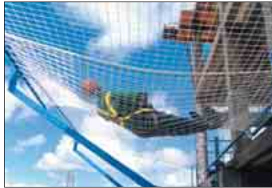
Distancia de Seguridad desde el punto medio del solape entre Redes al Brazo de 1,20 a 1,25 mts.
