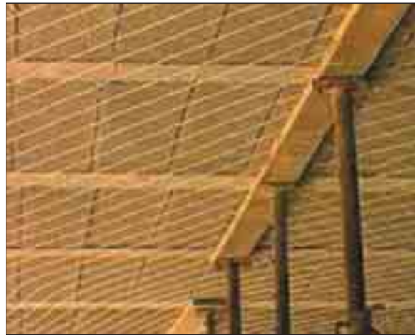
Red de seguridad bajo forjado. Vigueta y bovedilla
