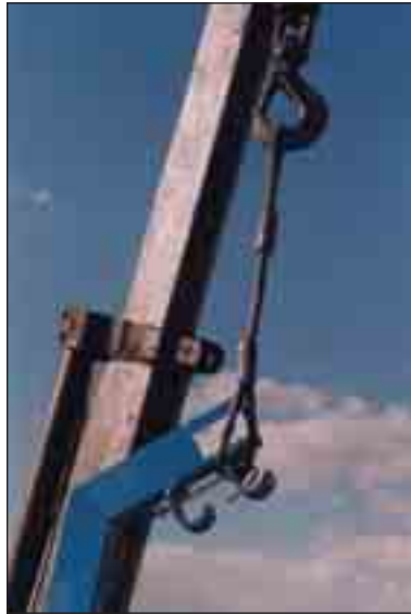
Apoyo de grúa para colocación del Sistema.
