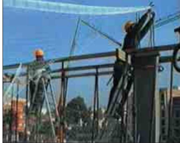
Una vez extendida la red de seguridad con la ayuda de medios auxiliares, el sobrante se introduce entre las esperas de los pilares, siendo éstos, su principal punto de apoyo .
