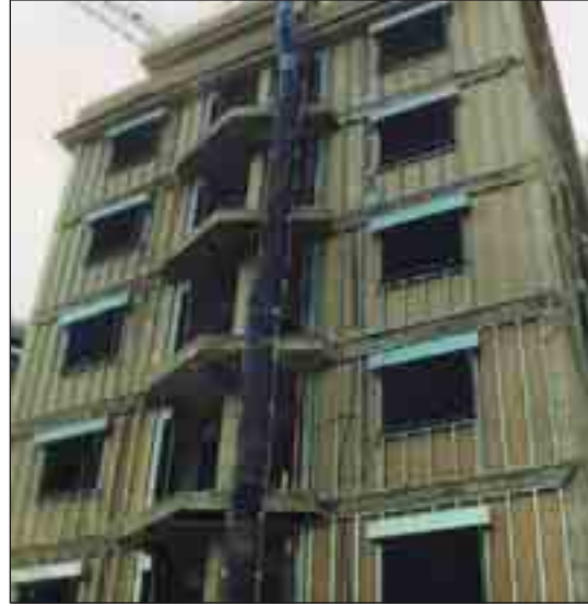
Red y trompa de desescombro.
