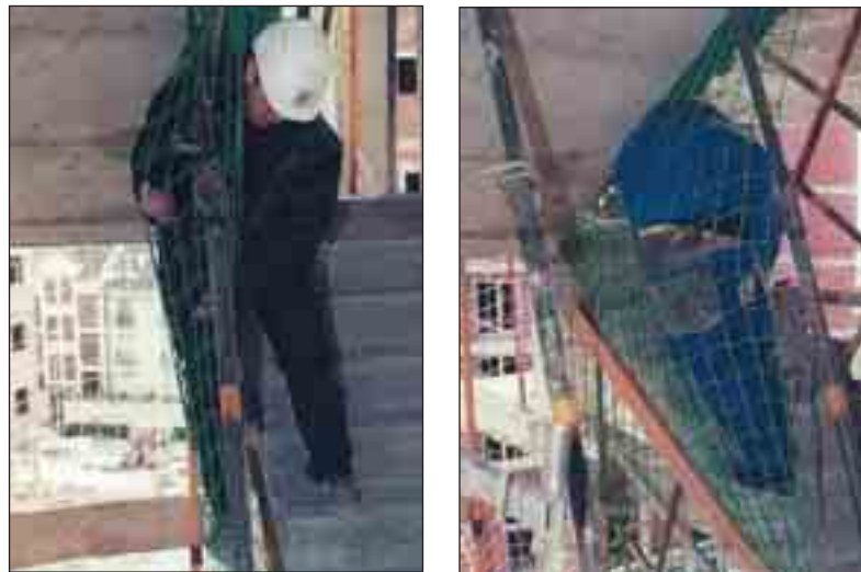
Operarios realizando pruebas de eficacia.
