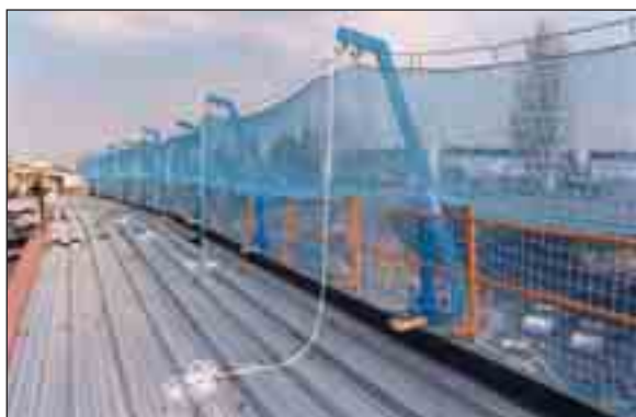
Se colocan cuerdas auxiliares para desplegar o izar el sistema.
