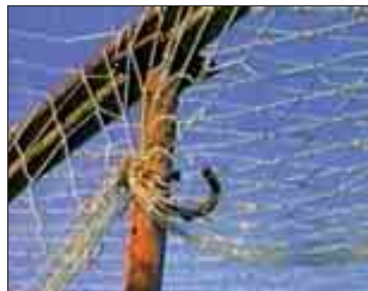
Detalle. Redes de seguridad fijadas con pasadores.
