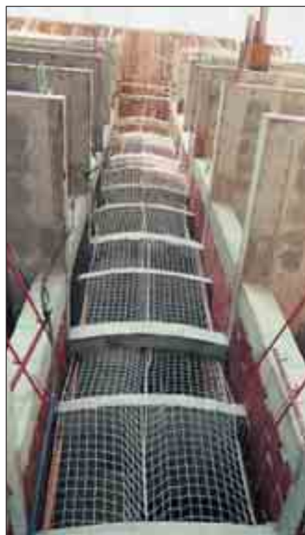
Red tipo Perona protegiendo un hueco exterior de escaleras.
