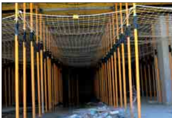
Calles 1, 2 y 3 de Redes bajo forjado sobre puntal.
