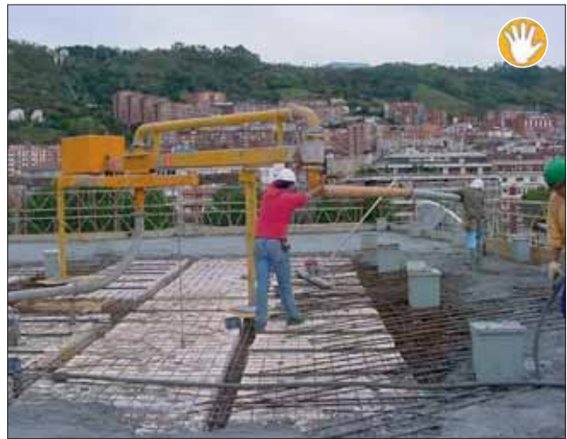
Hormigoi-ponparen mahuka erabiltzeagatik kolpe-arriskua egon daiteke
