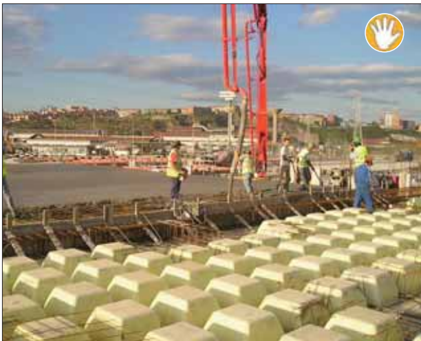
Hormigoi-ponparen mahuka erabiltzeagatik kolpe-arriskua egon daiteke
