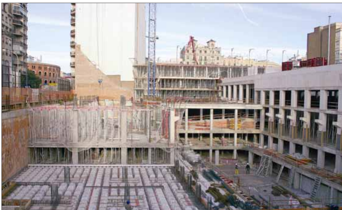
Ohiko obra-aldiaren argazkia: Kasetoiak jarrita daude, oholak trinkoteetan eta zepak jarrita, eta instalatuko den burdinaren banaketa hasita dago eta, obraren atzealdeko gunea prest dago kasetoiak jartzen eta oholeztatzen hasteko.
