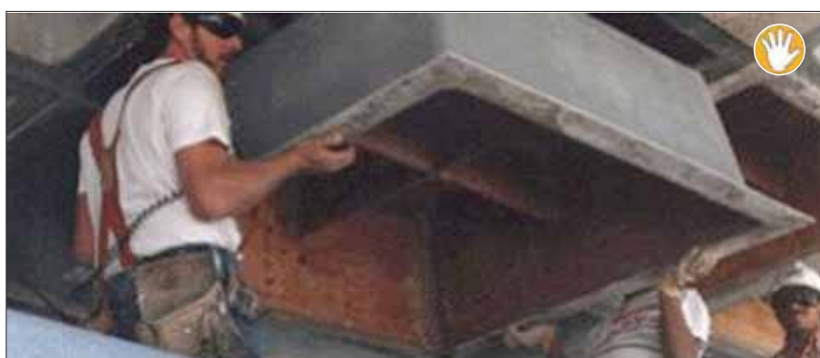
Kasetoiak manipulatzea: gehiegizko esfortzuak, maila batetik bestera erortzea, manipulatzen ari diren eta/edo askatutako objektuak erortzea
