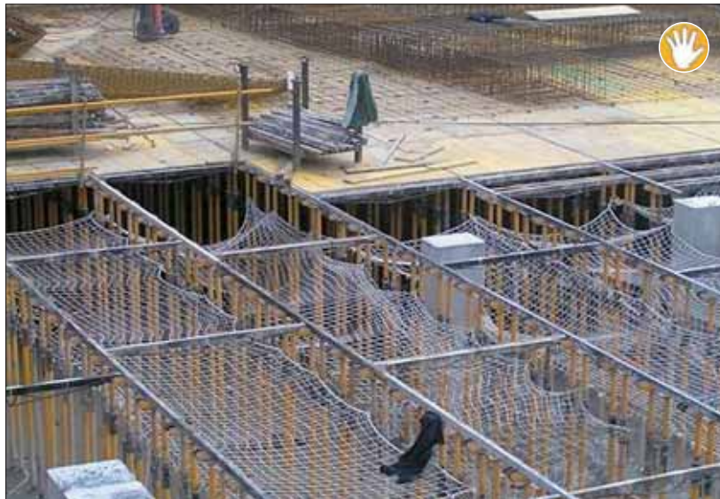
Forjatu azpiko sare horizontalaren muntaketa "hobegarria"
