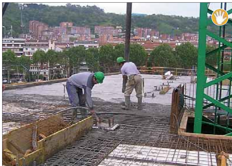
Maila berean erortzeko arriskua, zoru irregular baten gainean lan egin eta hormigoiaren mahuka-ponpo erabiltzeagatik.
