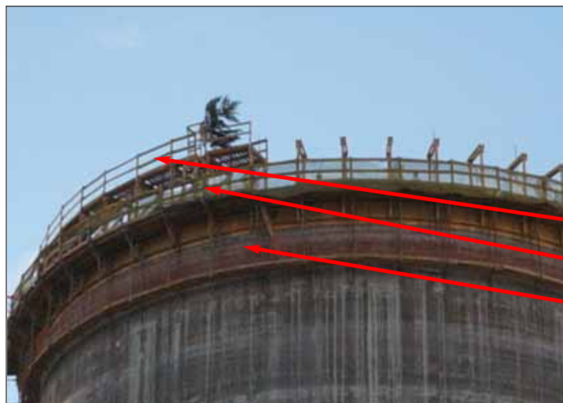
Kanpoko perimetro osoan zehar hiru lan-plataforma daude. Goikoan, altzai- rua jartzen da, erdikitik hormigoitu egi- ten da eta behekotik, hormigoi freskoa zarpiatu eta txalotxatzen da.
