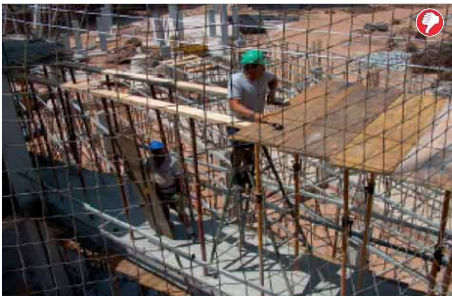
Plataforma desegoki baten gainetik, azpiko mailako enkofratuaren muntaketa
