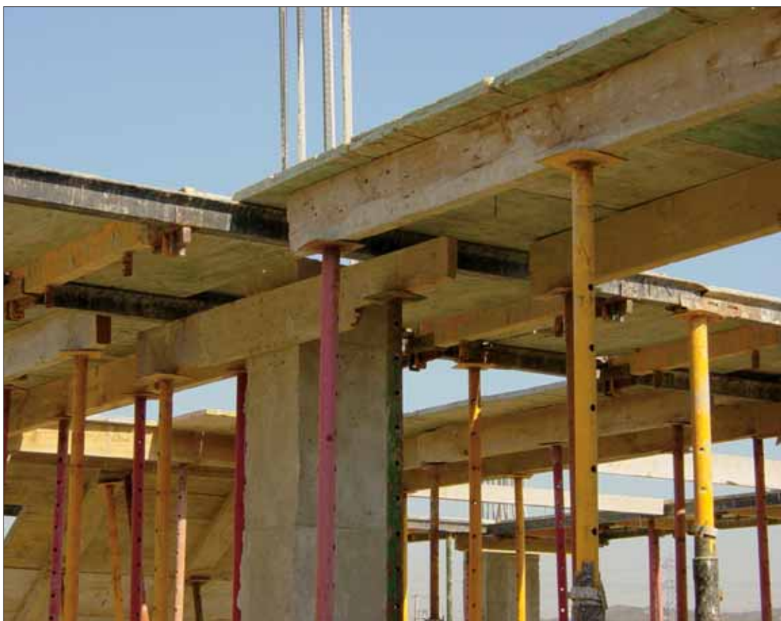
Zubatearen muturrean zurezko karpeta edo itxitura jartzea
