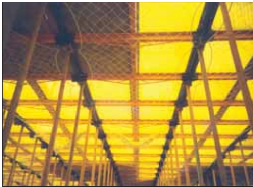
Encofrado de cubetas con red recuperable
