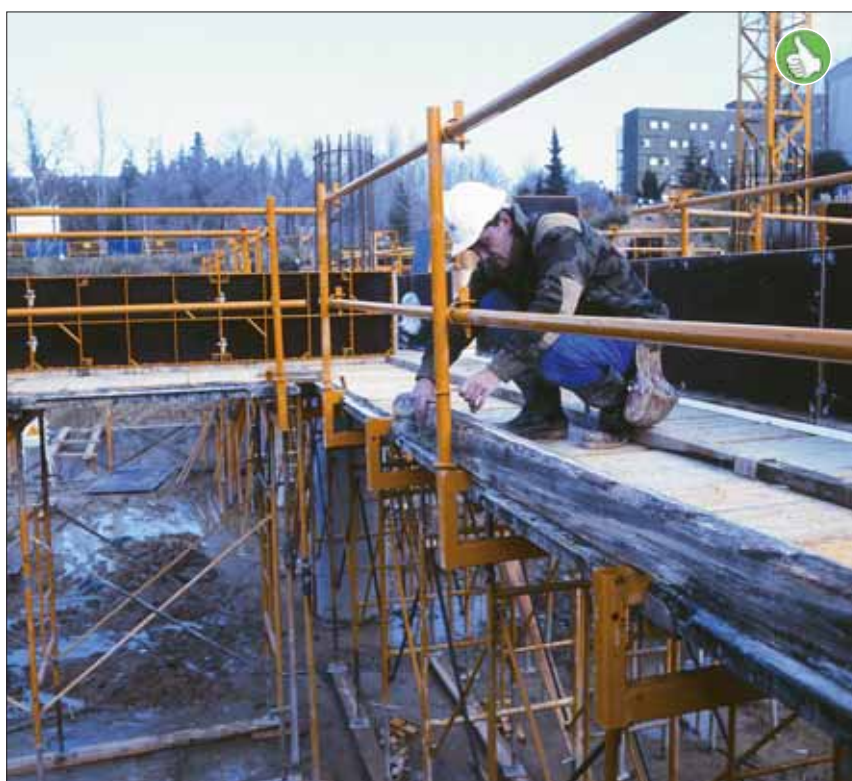
Colocación de rodapié
