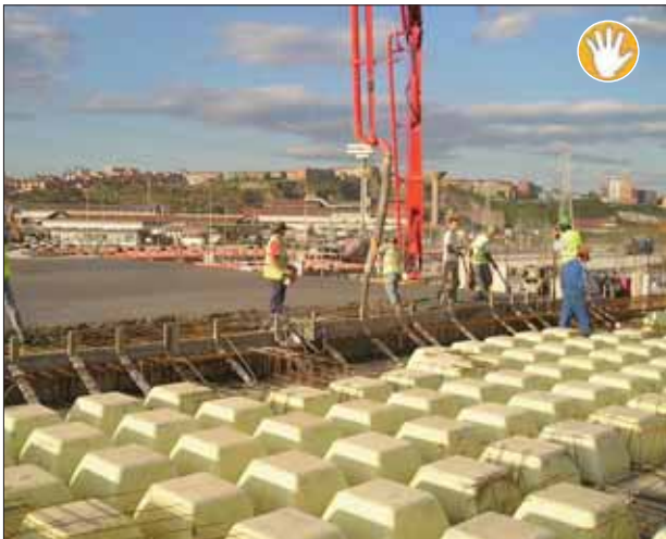
Riesgo de golpes durante el manejo de la manguera de la bomba de hormigón
