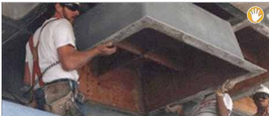
Manipulación casetones: sobreesfuerzos, caída a distinto nivel, caída objetos en manipulación y/o desprendidos.
