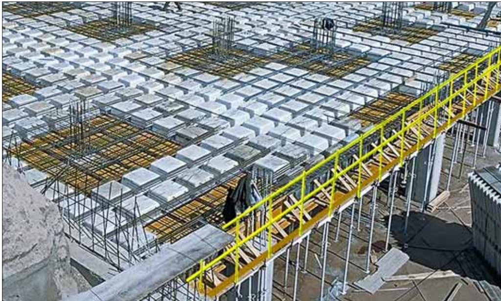
Vista general de forjado bidireccional de cubetas
