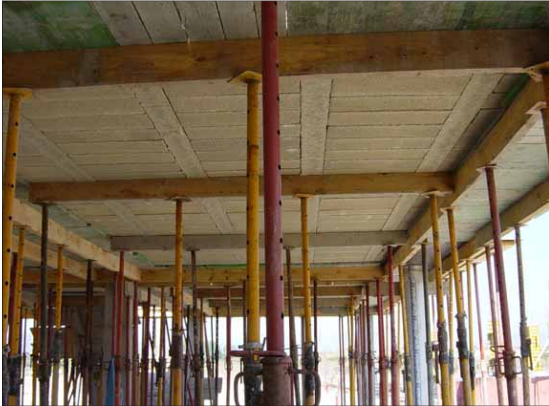
Sopandas colocadas en fondos de vigas y forjado
