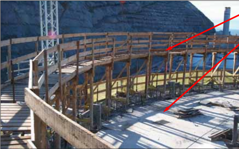
Paredes Interiores del Silo deslizadas
