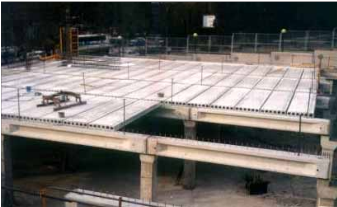
Estructura prefabricada de vigas y pilares y forjado de placa alveolar.
