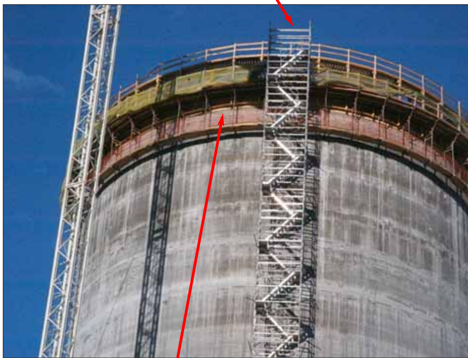
Panel deslizante, espesor 1,40 metros dos caras
