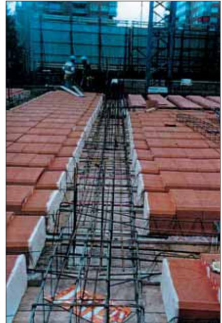
Detalle de forjado de vigueta y bovedilla con jácena plana
