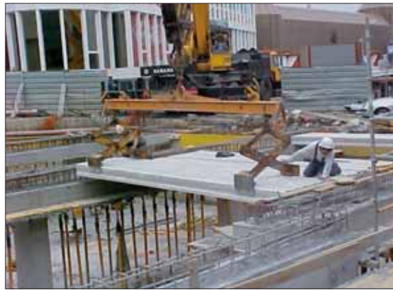
Forjado de prelosa de hormigón armado
