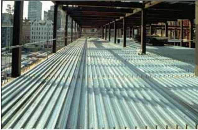
Forjado de chapa grecada o colaborante
