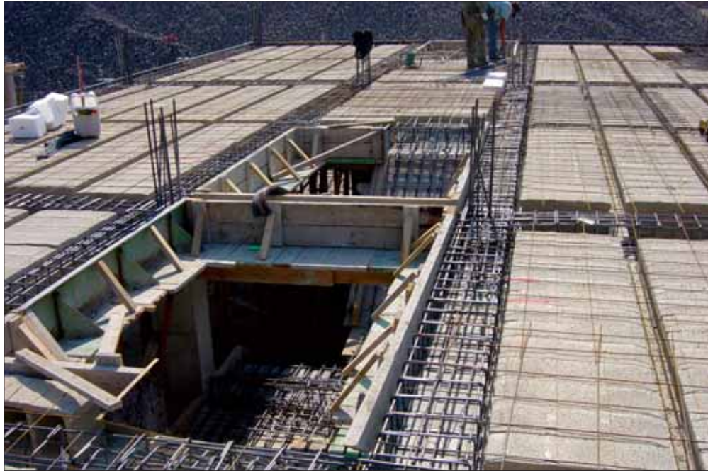
Forjado unidireccional de semivigueta y bovedilla
