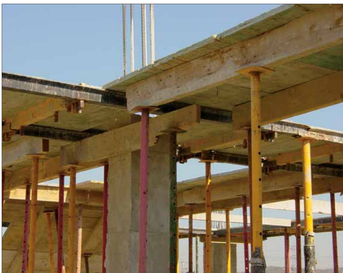
Colocación de carpeta o cierre en cabeza de pilar
