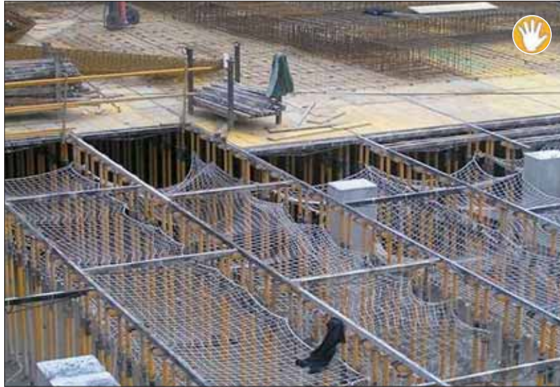
Montaje de red horizontal bajo forjado “mejorable”
