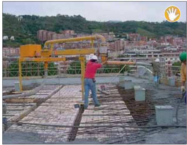
Riesgo de golpes durante el manejo de la manguera de la bomba de hormigón
