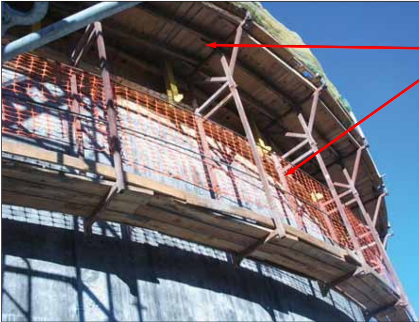
Plataforma Intermedia exterior
