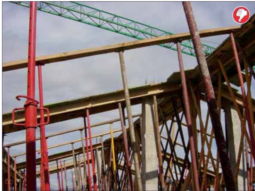
Trabajos en cubierta inclinada sin protección contra caídas
