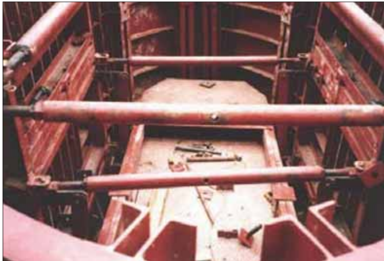
Plataforma de trabajo en el interior de la pila
