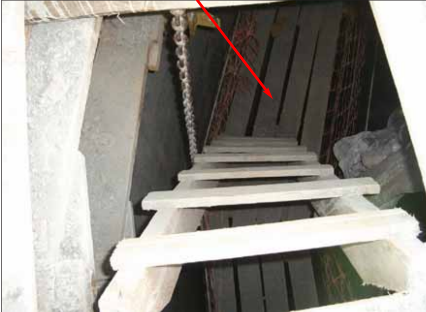
Plataforma Inferior / Interior
