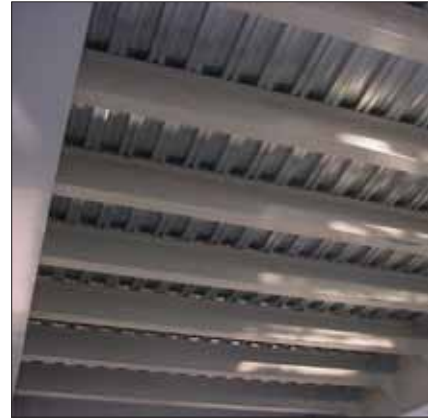
Forjado de chapa grecada o colaborante
