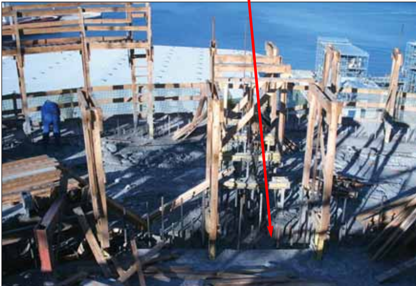
Paredes Interiores del Silo deslizadas
