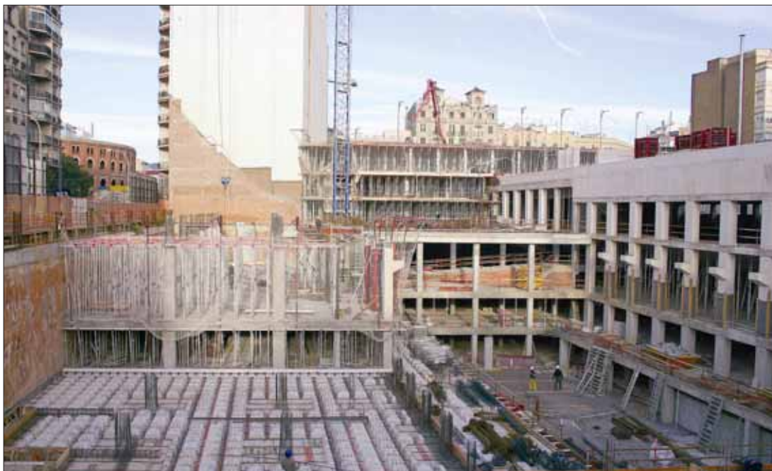
Foto en fase habitual de obra: Casetones colocados, tableros en macizos y encepados y se está comenzando a repartir el hierro para su colocación y al fondo zona de obra preparada para comenzar a recibir casetones y tablero
