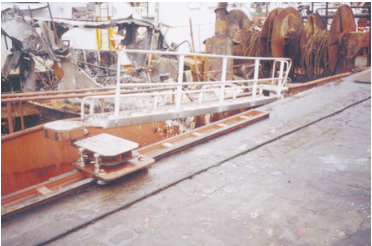
Detalle de la zona de rodadura ubicada en el muelle, así como la parte móvil de la pasarela de acceso al buque de pesca.
