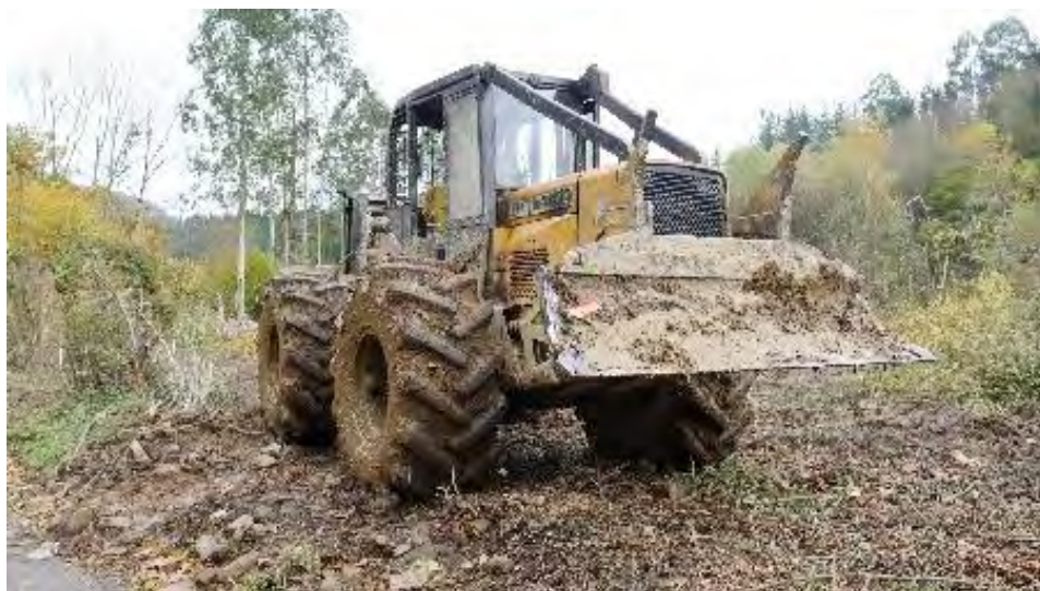
Imagen 7. Planificación del trabajo - Acondicionamiento de accesos
