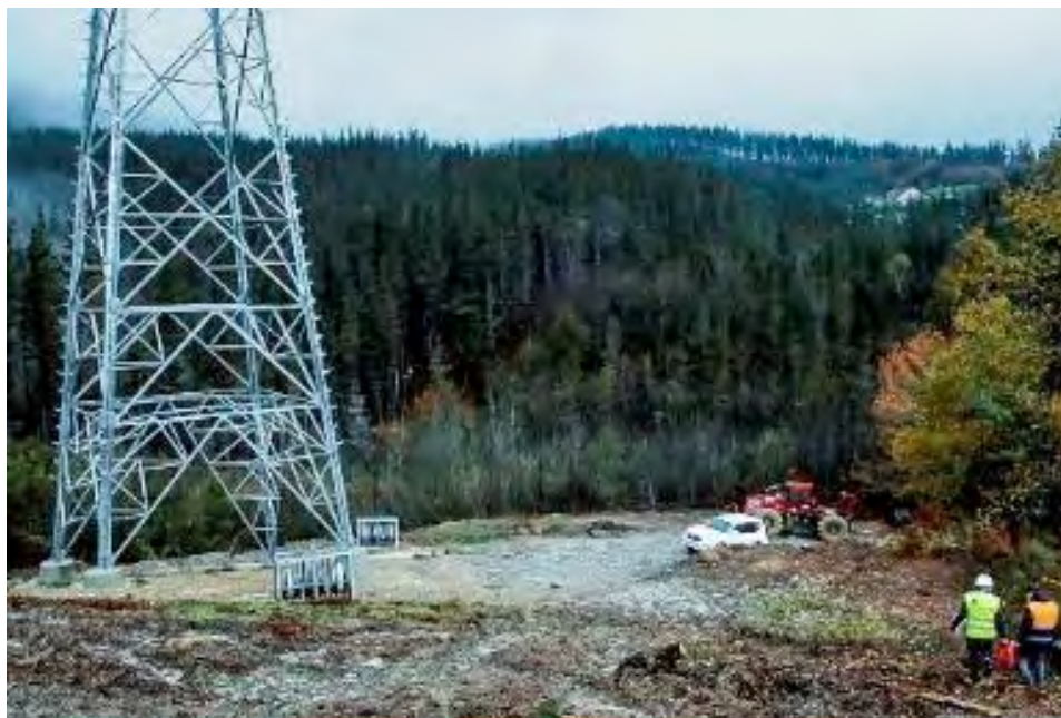
Imagen 6. Planificación del trabajo - Reconocimiento accesos y redes eléctricas
