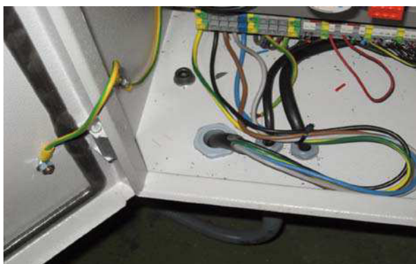
Foto.- Puesta a tierra (cable amarillo/verde) desde el interruptor principal hasta las partes metálicas sin tensión de la máquina.
