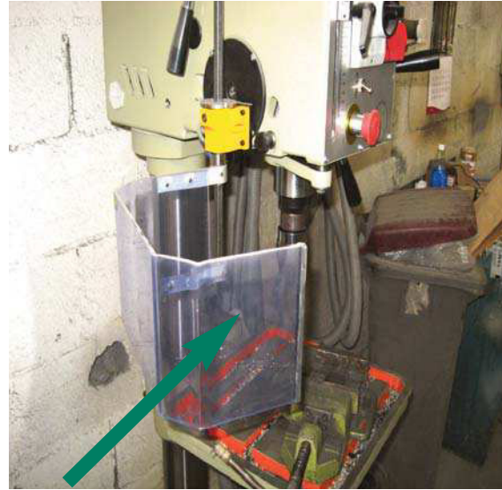
Resguardo (pantalla) abierto: la máquina se para al abrirse y no puede funcionar.
