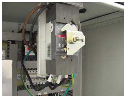
Foto.- Puesta a tierra (cable amarillo/verde) desde el interruptor principal hasta las partes metálicas sin tensión de la máquina.
