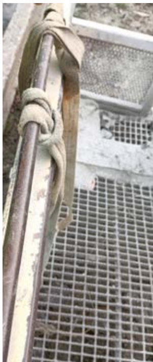
Altuerako erorketen aurkako ainguraketa-gailuak falta dira
