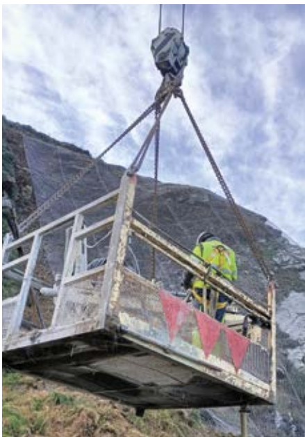
Langileak plataforman, arnesa modu ezegokian finkatuta ainguraketa-puntu ez-seguru batera
