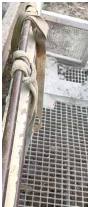
Faltan dispositivos anclaje contra caídas en altura.
