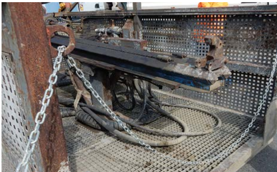
Cesta desprotegida, el uso de cadena como protección de borde resulta ineficaz
