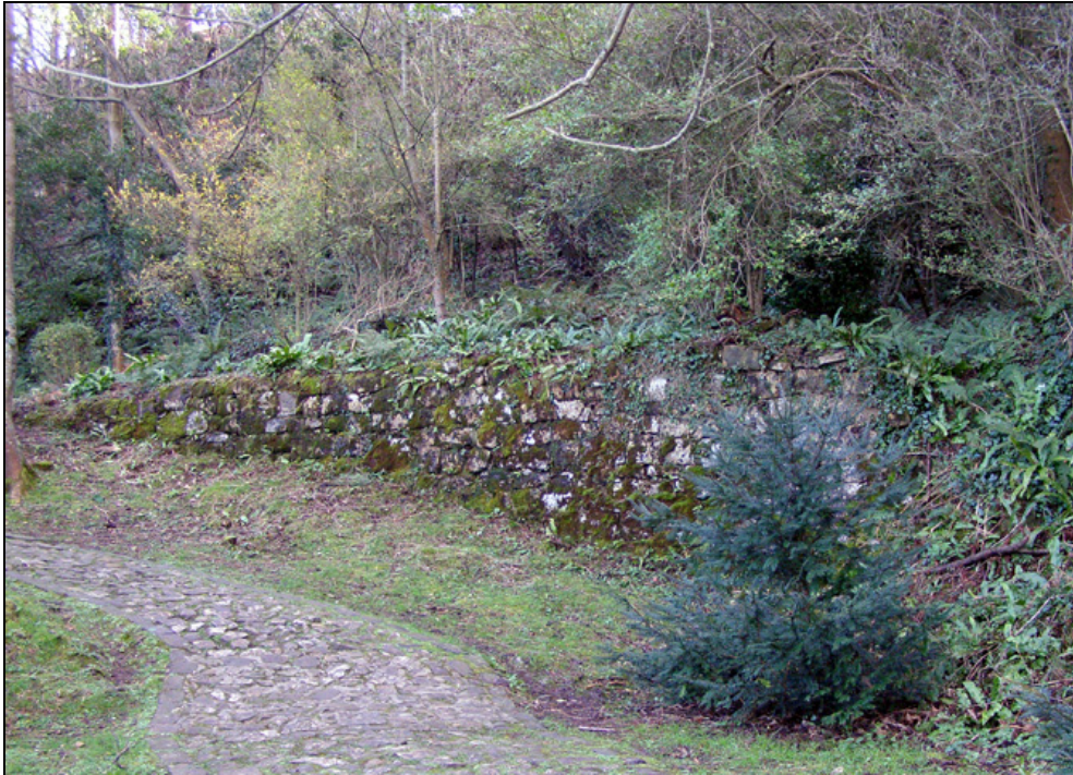
Figura 16 . Murete con grietas y vegetación entre las piedras donde se observaron numerosas salamandras, en la ladera norte.
