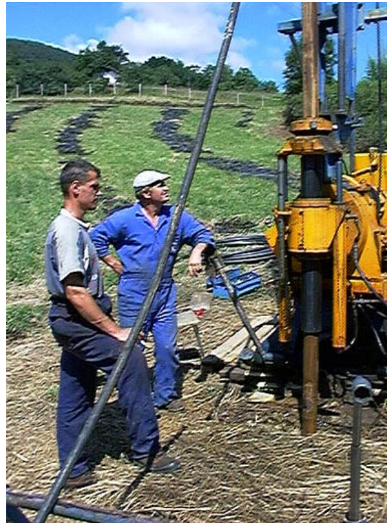
Fotografía 5. Perforando en Sakone-1.
