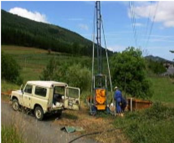
Fotografía 1. Perforando en Sakone-2.
