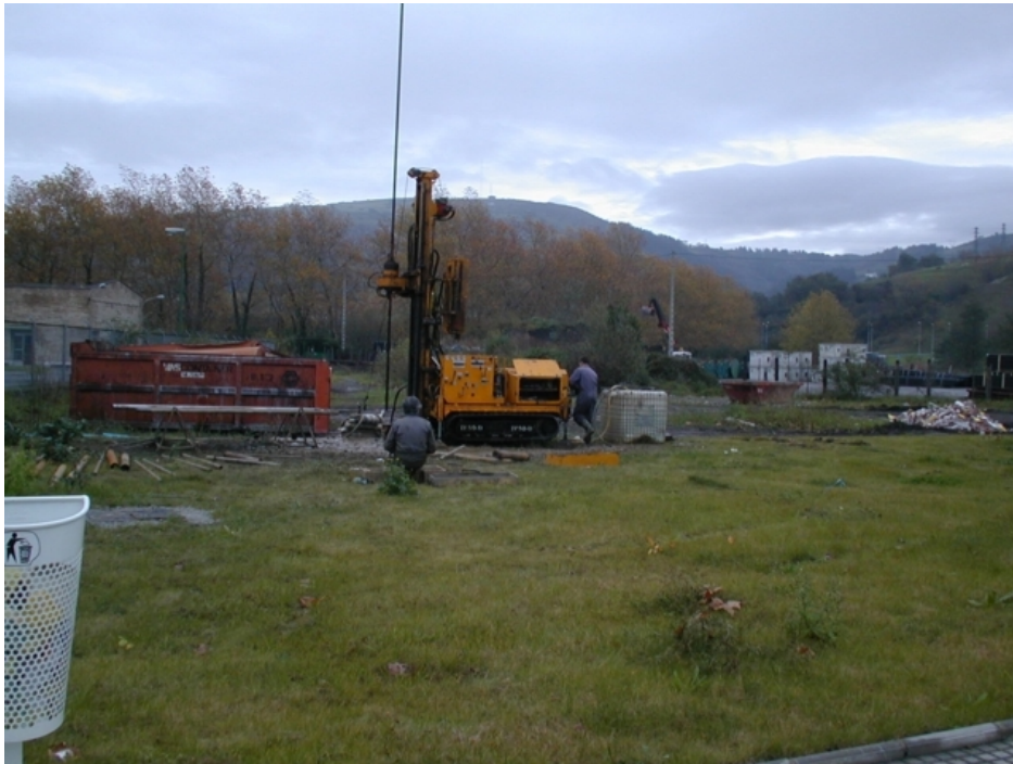
Equipo de perforación
