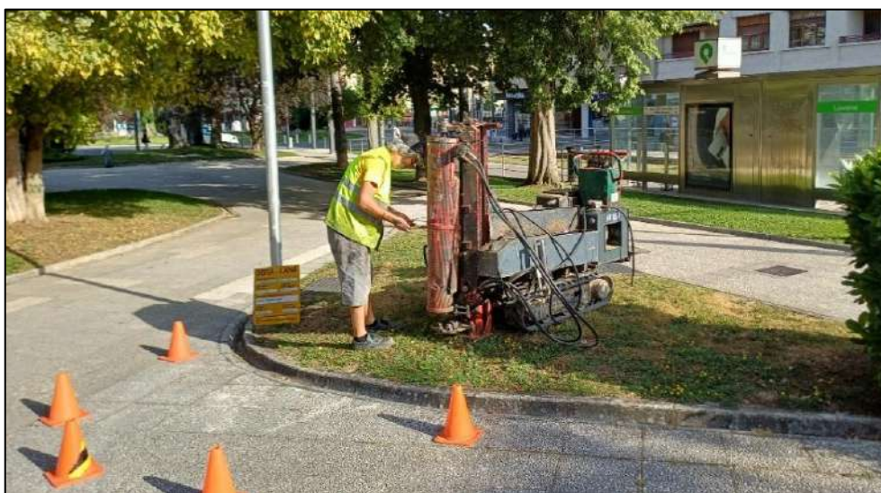
Figura 13. Equipo DPSH en la posición del ensayo P-1.
