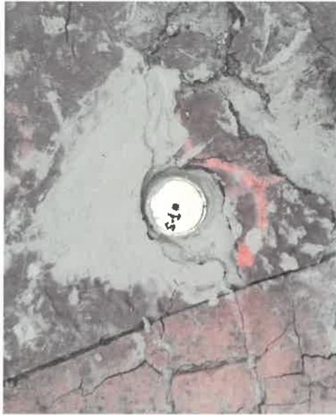
FOTOGRAFÍA DE LA TAPA, DESPUÉS DE LA EJECUCIÓN DEL SONDEO
