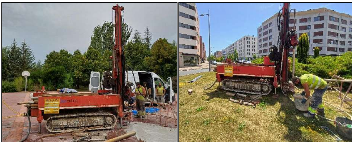
Figura 11. Equipo de perforación de sondeos en la posición de los sondeos S-1 y S-2.
