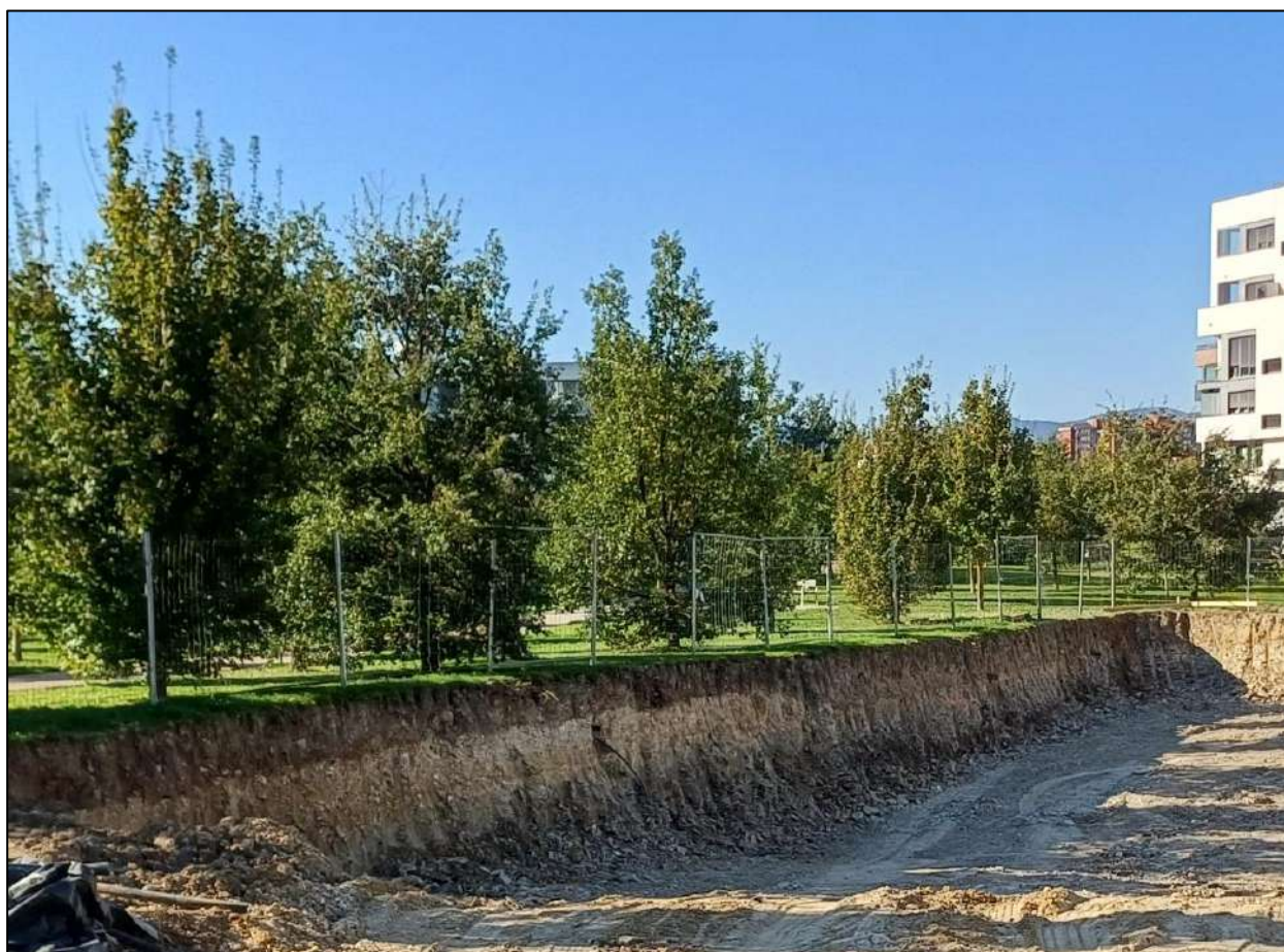
Figura 4. Afloramiento típico de suelo, con un nivel superior de tierra vegetal y rellenos (marrón oscuro), seguido por arcillas amarillentas (suelo residual) y margas grises altamente meteorizadas (GM IV).
