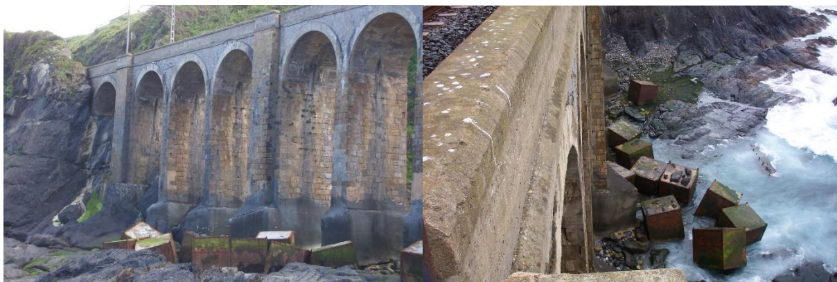
Figura 4. Cubos desplazados en 2003.
