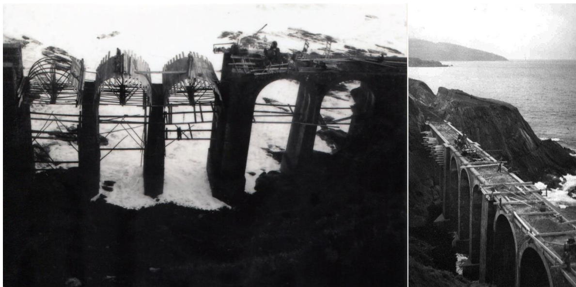
Figura 2. Cimbras de madera para ejecución de bóvedas de hormigón.
