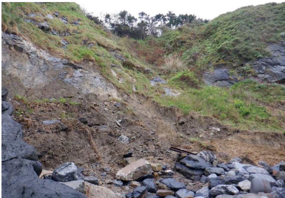
Erosiones localizadas en el pie de la ladera.
