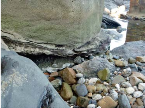
Falta de penetración de gunitado en zona inferior
