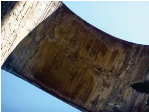
Fisura y humedad en bóveda.
