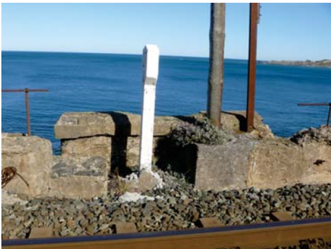
Pérdida de elementos de muro de protección.
