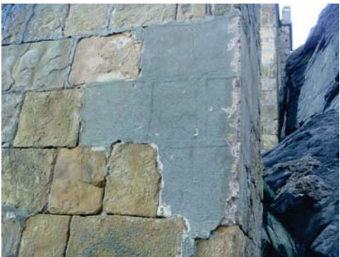
Mortero de reparación en pila.
