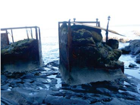
Pérdida de protección de acero y hormigón en
