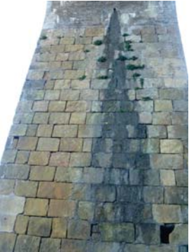
Humedad y eflorescencia en cara interior de pila.
