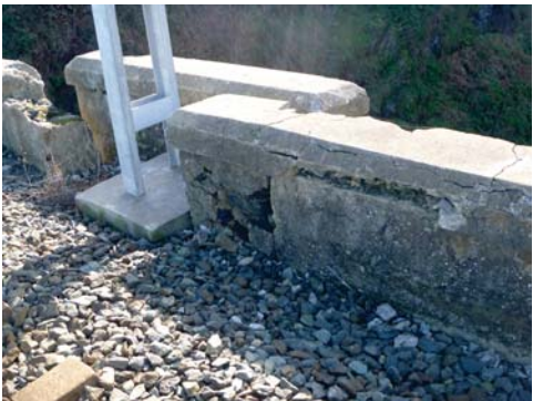
Pérdida de hormigón en muro.
