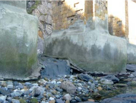
Fisuración en gunitado
