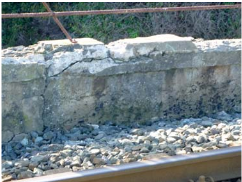
Hormigón de muro fisurado.
