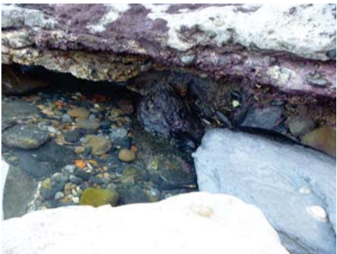
Posible descalce de pila.
