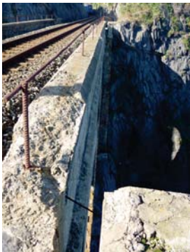
Pérdida de hormigón en muro de protección.
