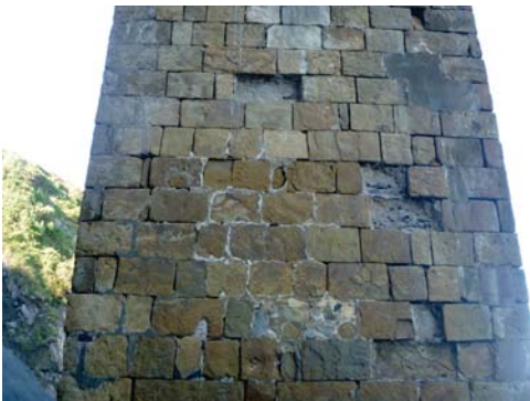
Pérdida de elementos y de material en juntas.
