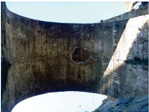
Fisuración en bóveda. Humedad con pátina.
