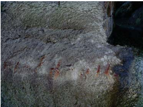
Oxidación de armadura en gunitado.
