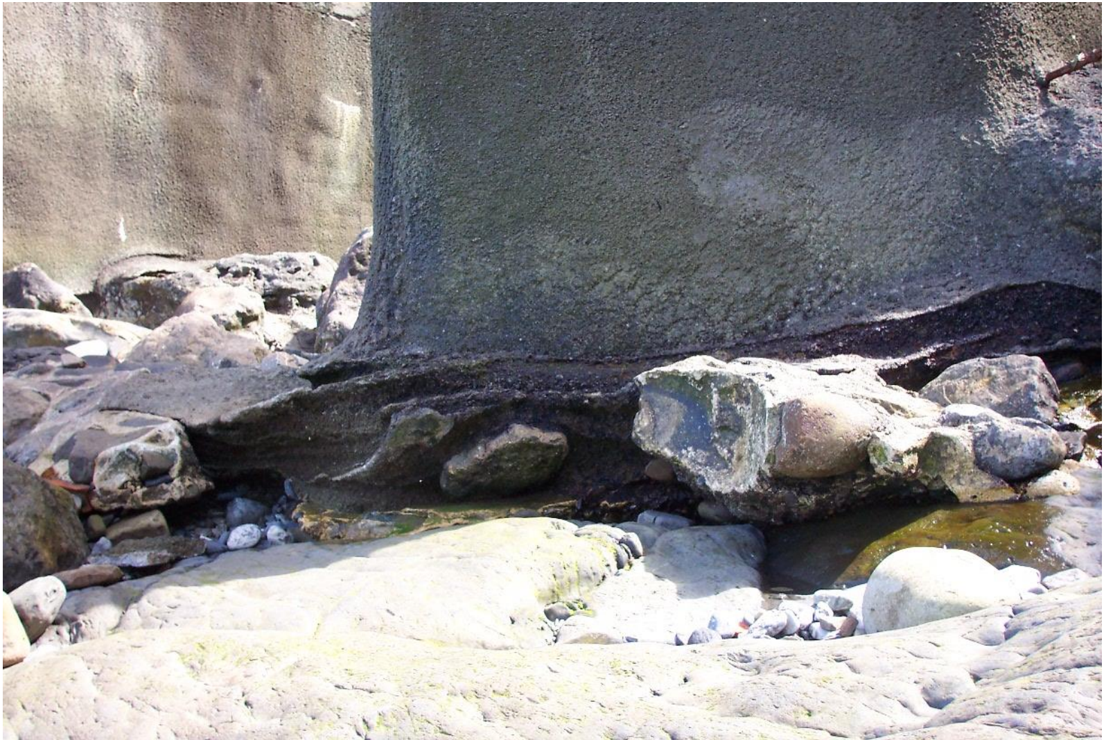
SOCAVACIÓN EN CIMENTACIONES
