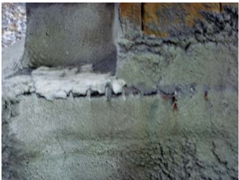
Armadura vista en gunitado.
