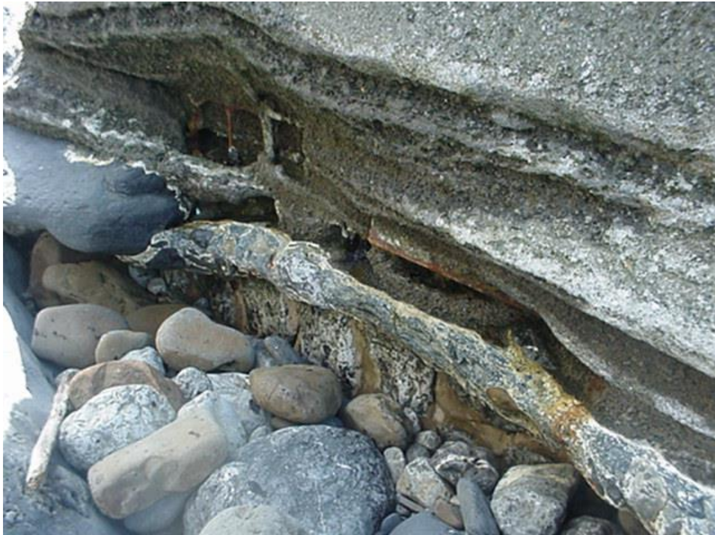
SOCAVACIÓN EN CIMENTACIONES
