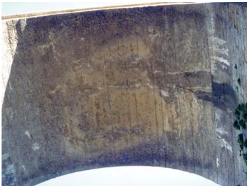
Fisura longitudinal en bóveda.
