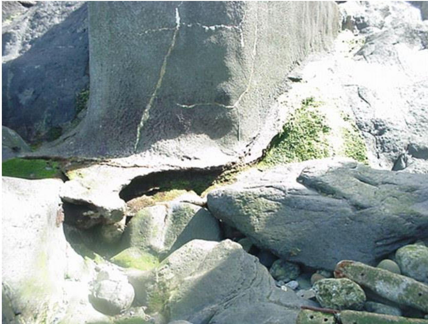
SOCAVACIÓN EN CIMENTACIONES
