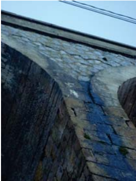
Humedad en pila.
