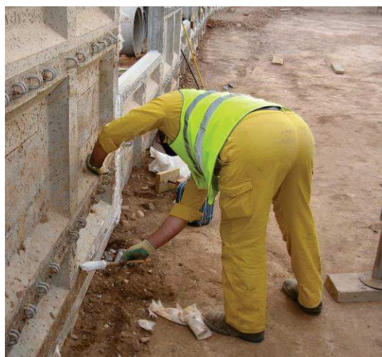
Fotografía durante la aplicación de pegamento sobre el borde de las placas.
