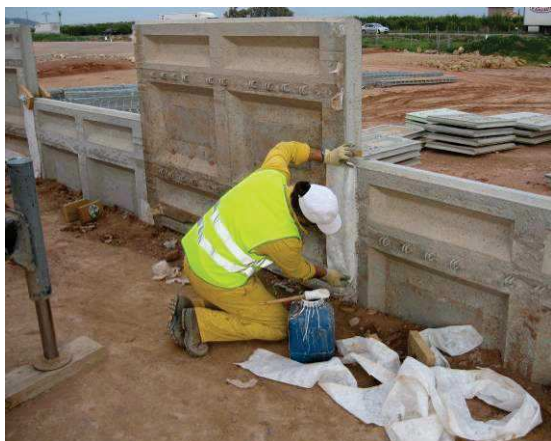
Fotografía del posicionamiento del geotextil en las juntas.
