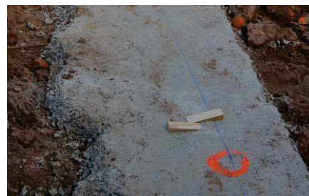
Fotografía de las 4 cuñas de madera para apoyar las placas de arranque.
