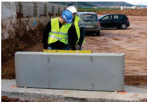
Fotografía de la verificación de horizontalidad de una placa media tipo B1 apoyada sobre cuñas.
