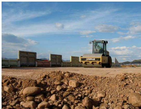
Fotografía durante la compactación de una capa de relleno.
