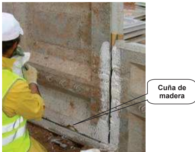
Fotografía durante el montaje. Se observa la cuña de madera inferior.
