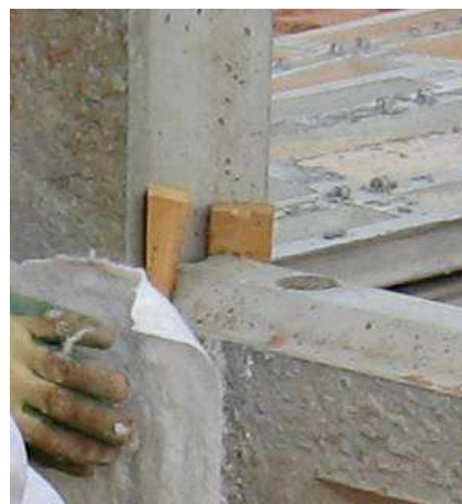
Fotografía de las cuñas de madera provisionarias para fijar las placas.
