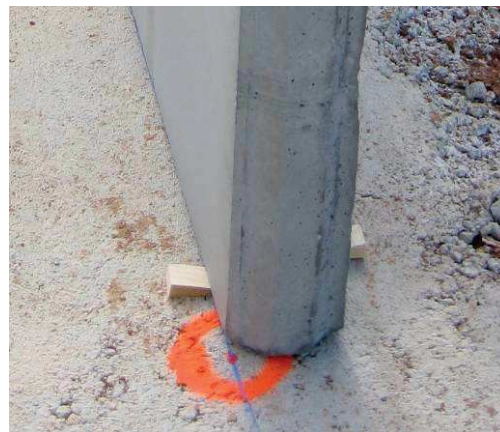
Fotografía de la línea exterior de alineación y del punto de verificación del muro.
