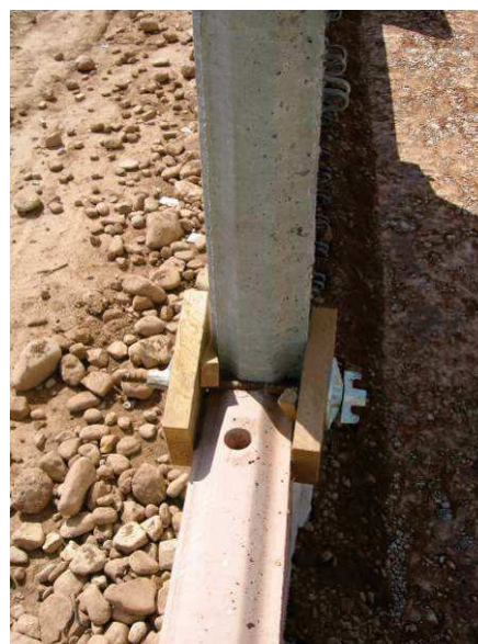
Fotografía de las cuñas de madera adicionales en la prensa de montaje (solo para la segunda fila de placas y posteriores).
