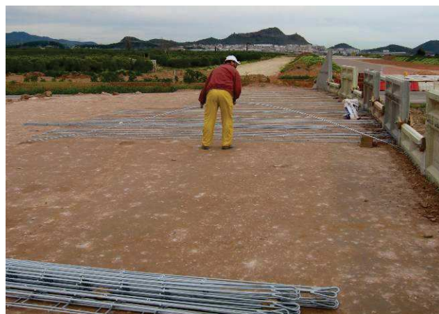
Fotografía durante el montaje de mallas.
