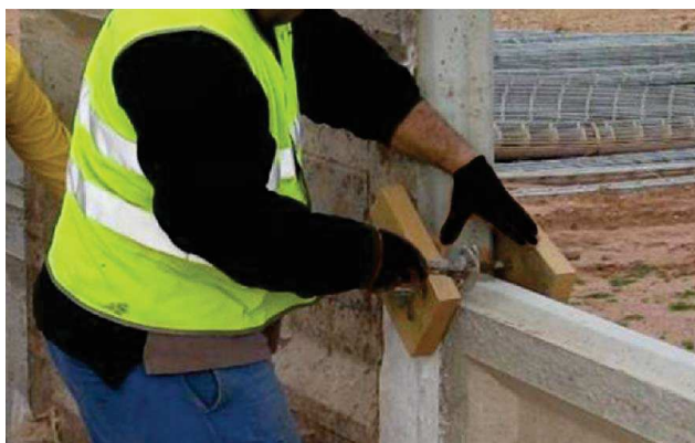
Fotografía del montaje de prensas.
