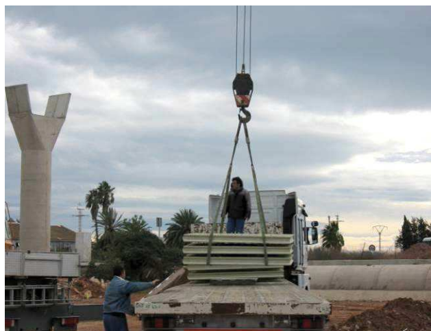
Fotografía durante la descarga de placas por grupos con eslingas de nylon.
