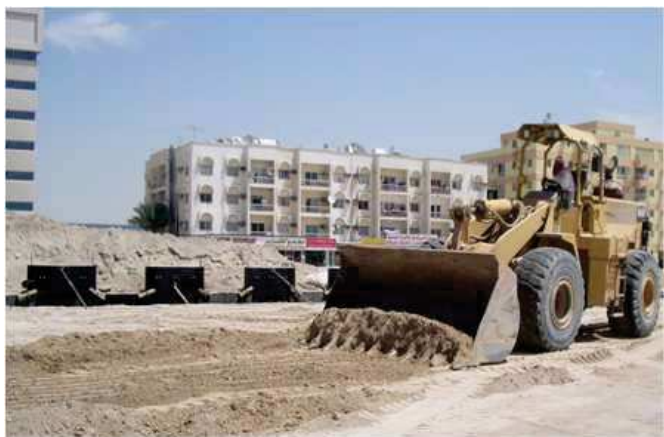
Fotografía durante la distribución del relleno (segunda capa de relleno).
