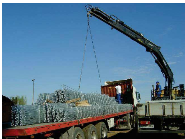
Fotografía durante la descarga de mallas de refuerzo a pie de obra.
