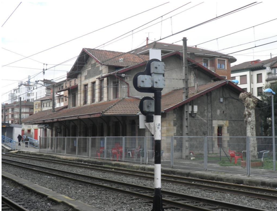
Imagen del alzado lateral Norte actual y del alzado a las vías en el año 2015, previamente a la rehabilitación llevada a cabo en el año 2020.
