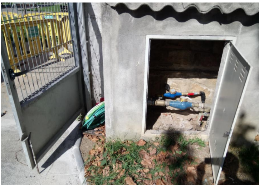
Hornacina existente donde se instalará el nuevo contador de agua
