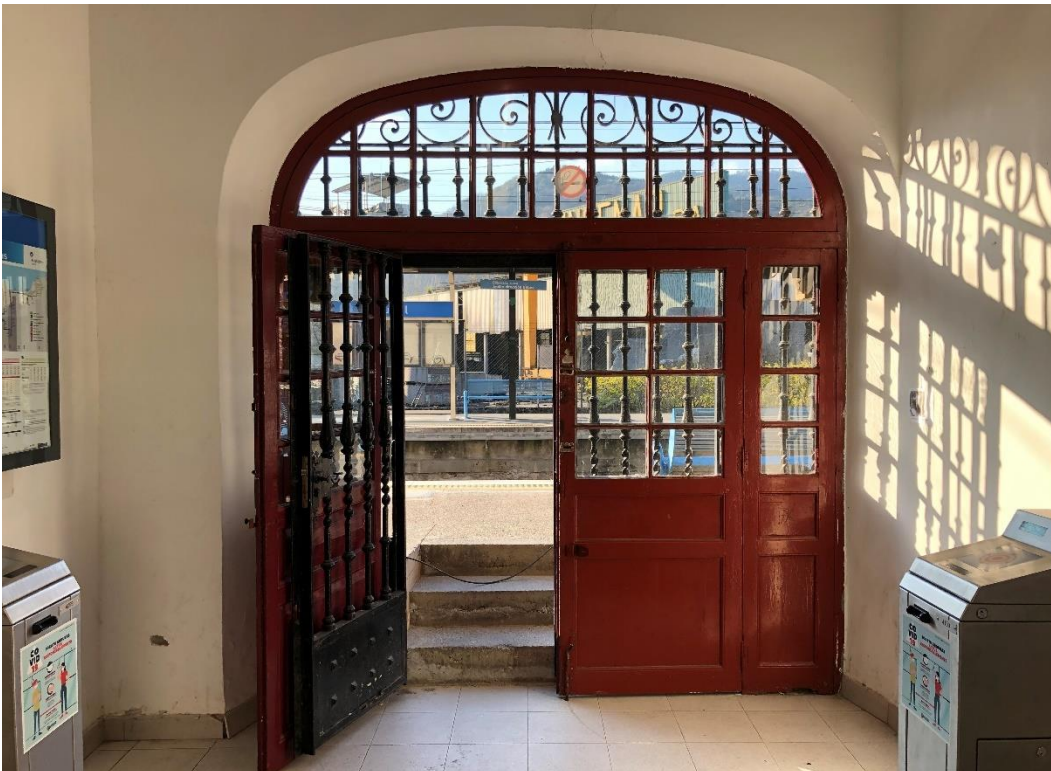
Figura 5. Puerta de acceso a andenes actual Vista inerior estación
