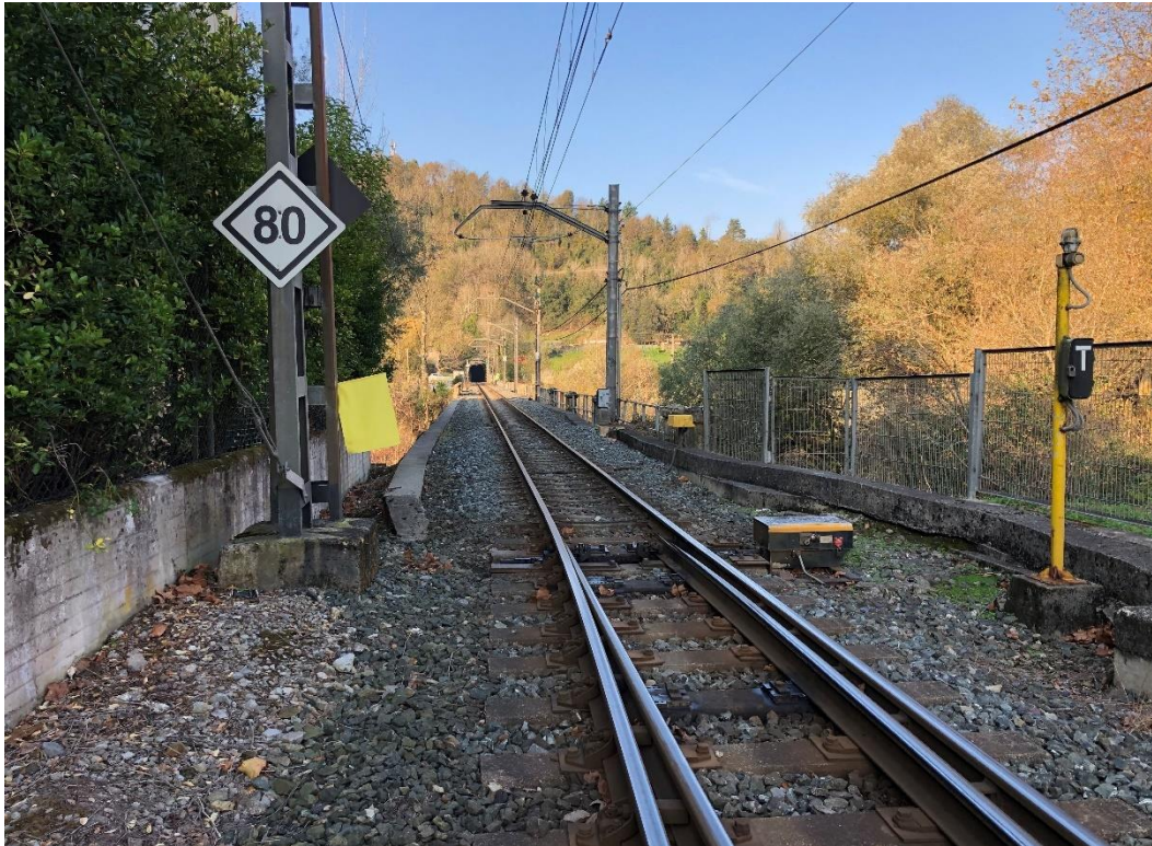
Figura 28. Superestructura Via única - sentido Donosti (Junto a paso a nivel)
