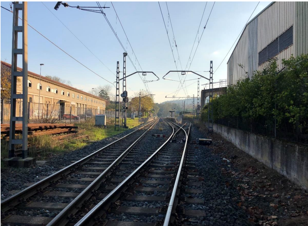
Figura 9. Vías zona final del trazado – Vista Oeste
