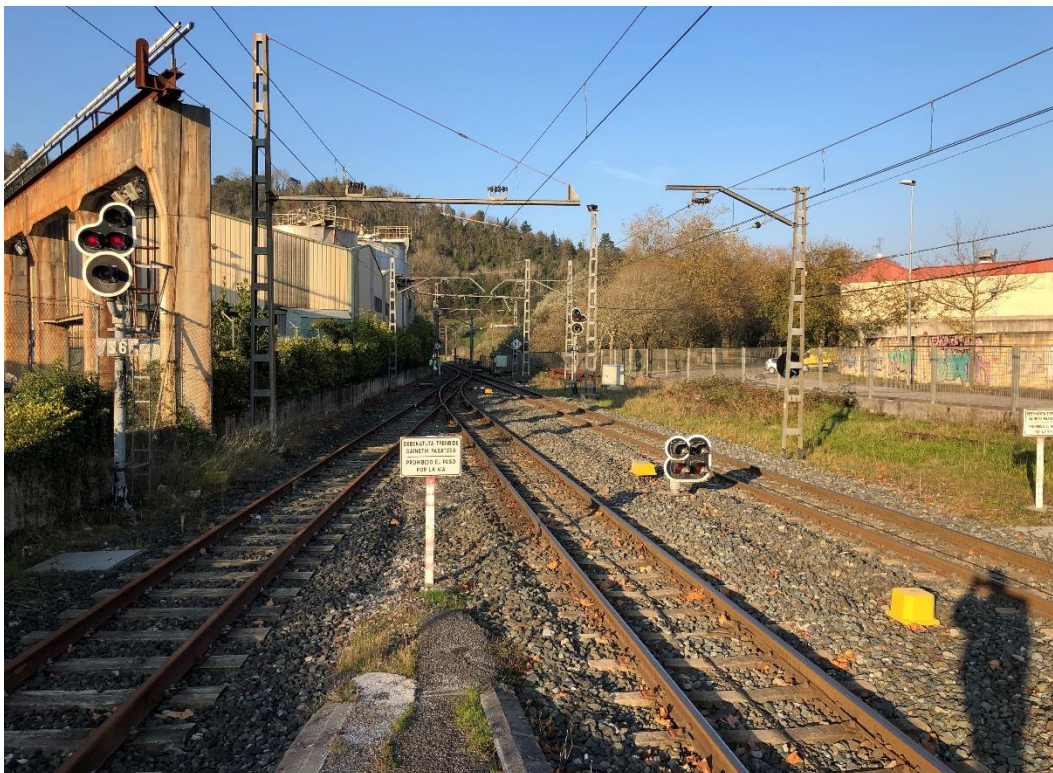
Figura 29. Superestructura final del trazado y andenes sentido Bilbao
