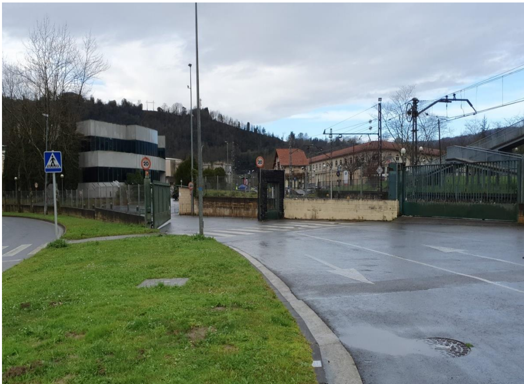
Figura 33. Servicios afectados – Arqueta red saneamiento municipal
