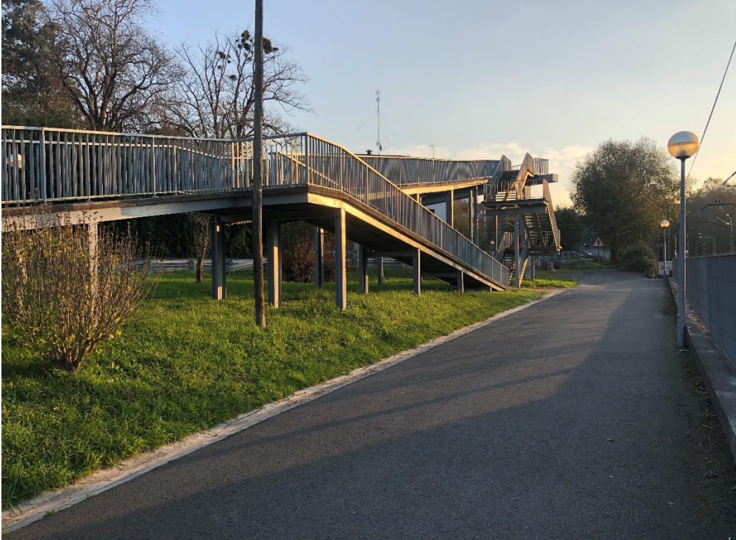
Figura 12. Pasarela peatonal – Desembarco rampa Sur
