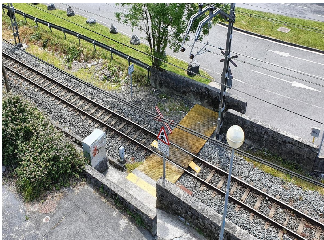
Figura 11. Paso a nivel a eliminar – Conexión del núcleo urbano con el Polígono industrial INGEMAR
