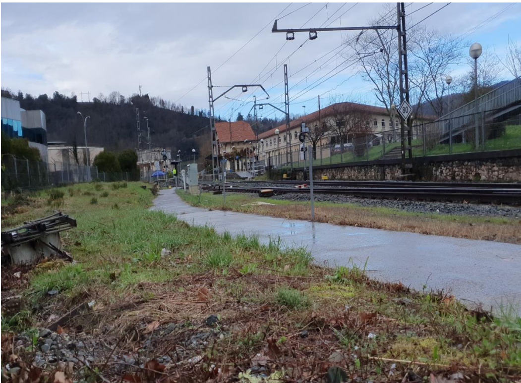
Figura 17. Nuevo emplazamiento de estación, vista Sur-Este
