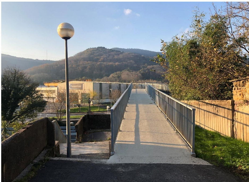
Figura 14. Escalera actual de acceso a pasarela peatonal
