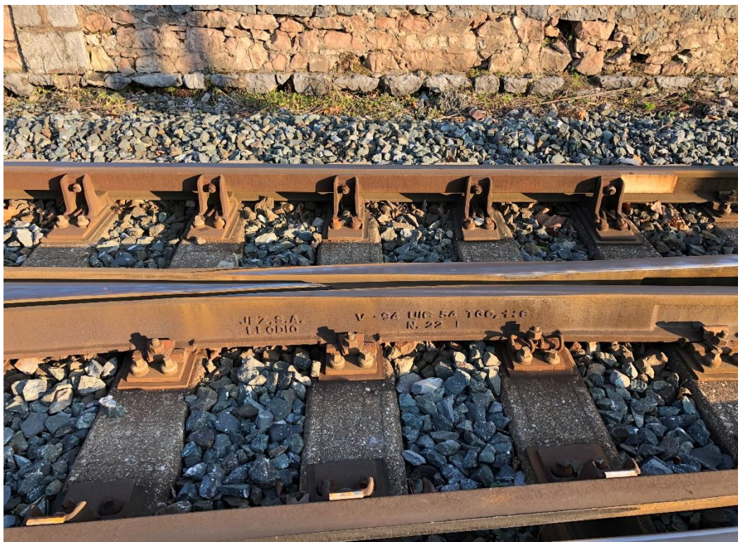
Figura 26. Detalle cruzamiento – Via de escape entre via 1 y via 2 sentido Donosti (Junto a paso a nivel)
