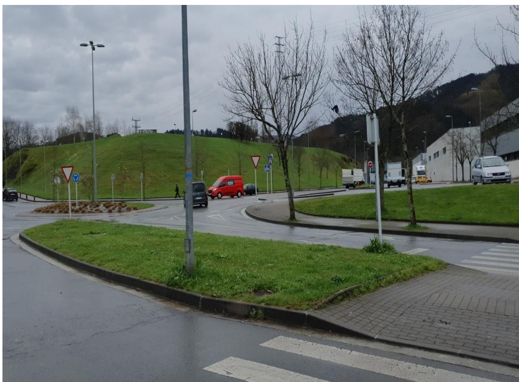
Figura 23. Zona emplazamiento nuevo ascensor y escaleras – Paso de peatones actual
