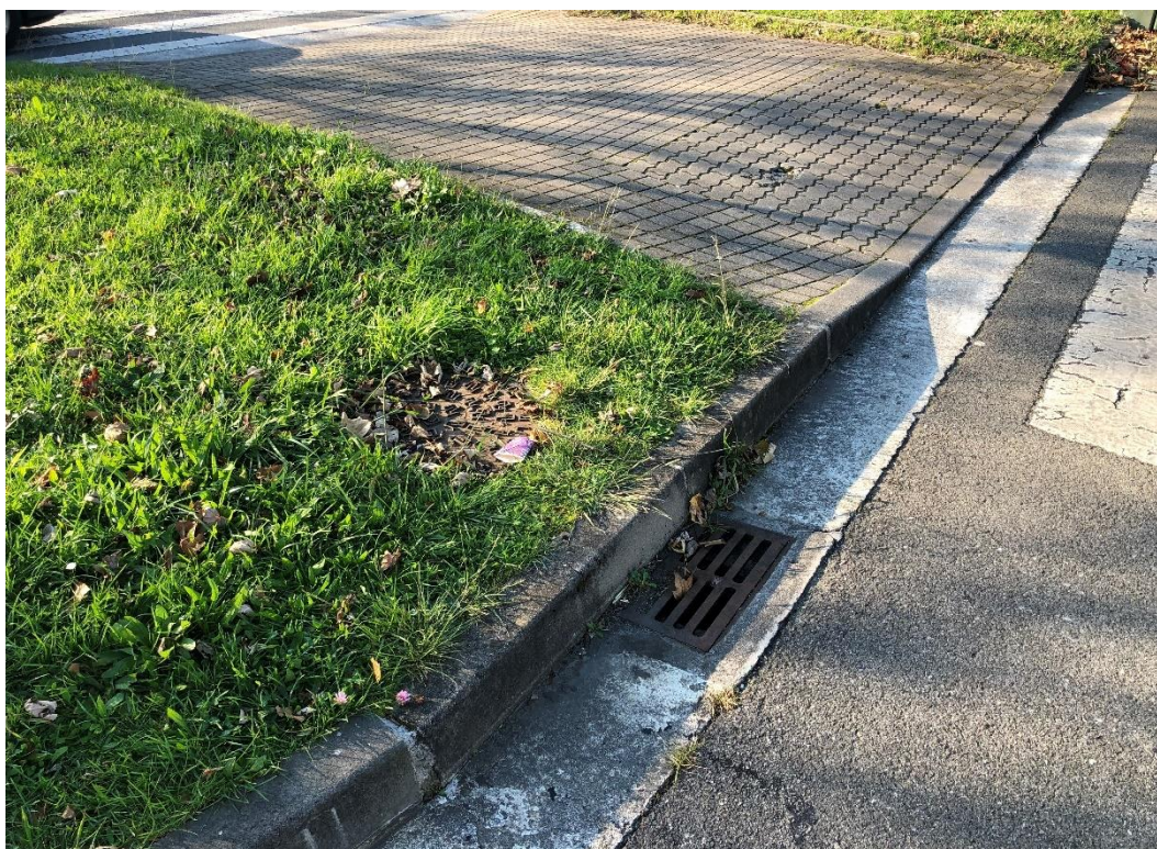
Figura 35. Servicios afectados – Arqueta red saneamiento municipal y sumidero de calzada
