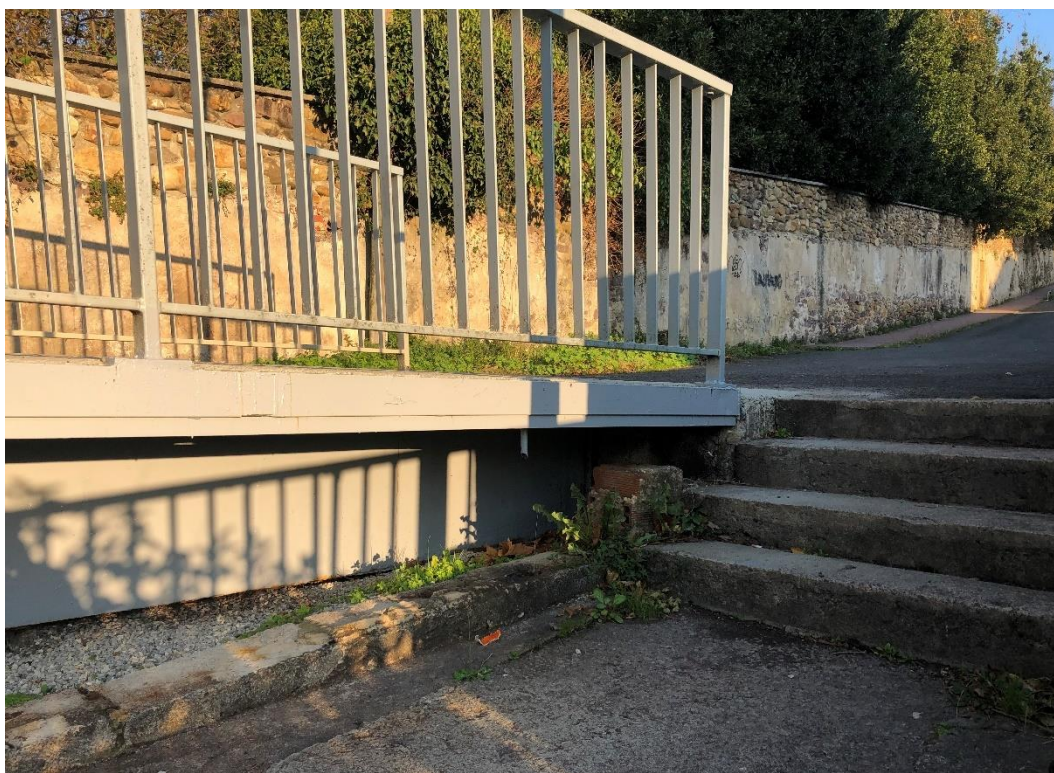
Figura 15. Escalera actual de acceso a pasarela peatonal
