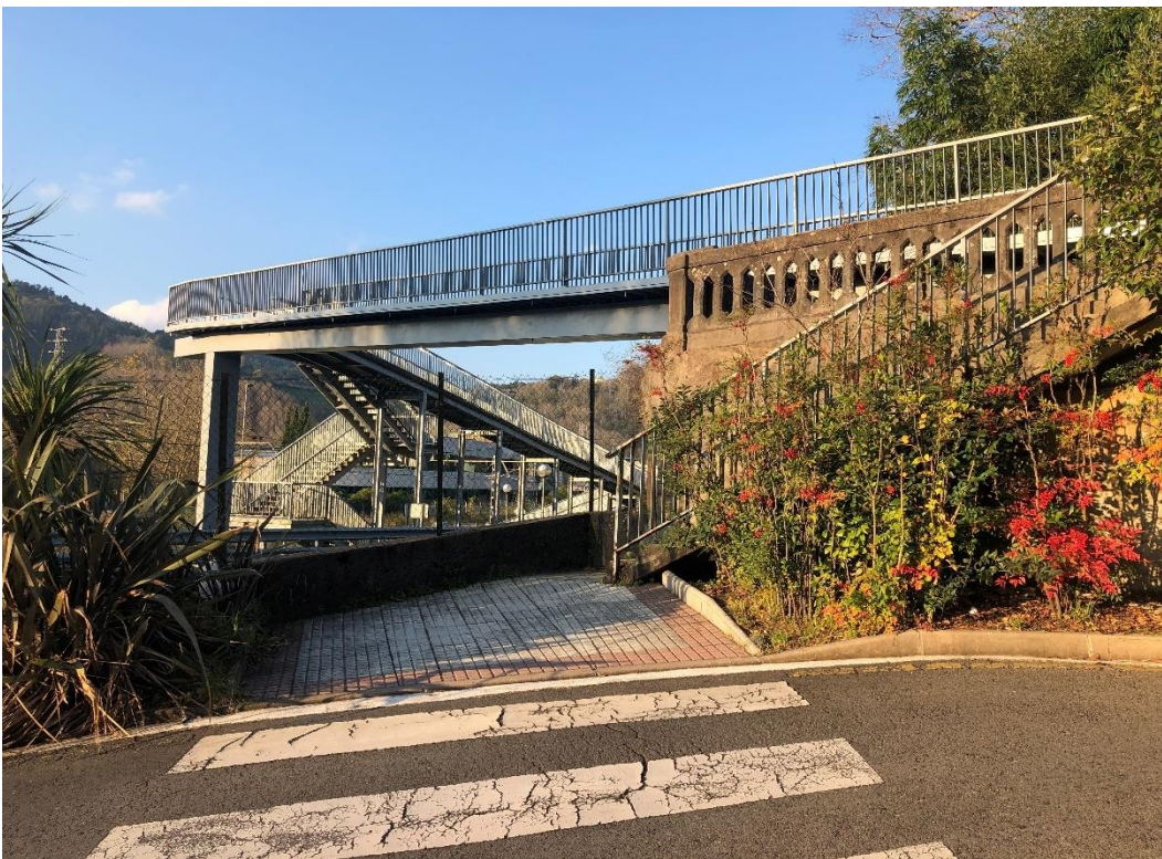
Figura 13. Pasarela peatonal – Desembarco escaleras Norte
