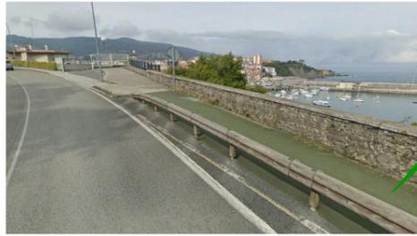
**SOBREANCHO EN LA PARTE SUPERIOR DEL TALUD, JUNTO A LA CARRETERA BI-2235 DONDE ANCLAR LA MAQUINARIA PARA LAS PERFORACIONES DE LOS BULONES**
