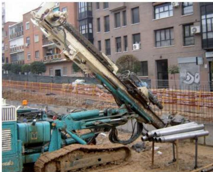
Equipo de perforación y utillaje en borriquetas.
