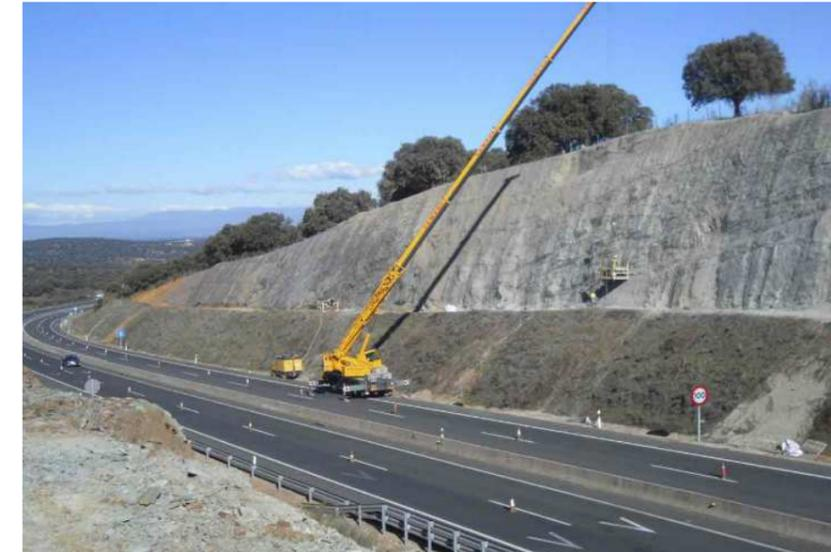
Trabajos de instalación de mallas en taludes e hidrosiembra:
